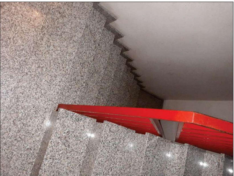
Vano scale comune
