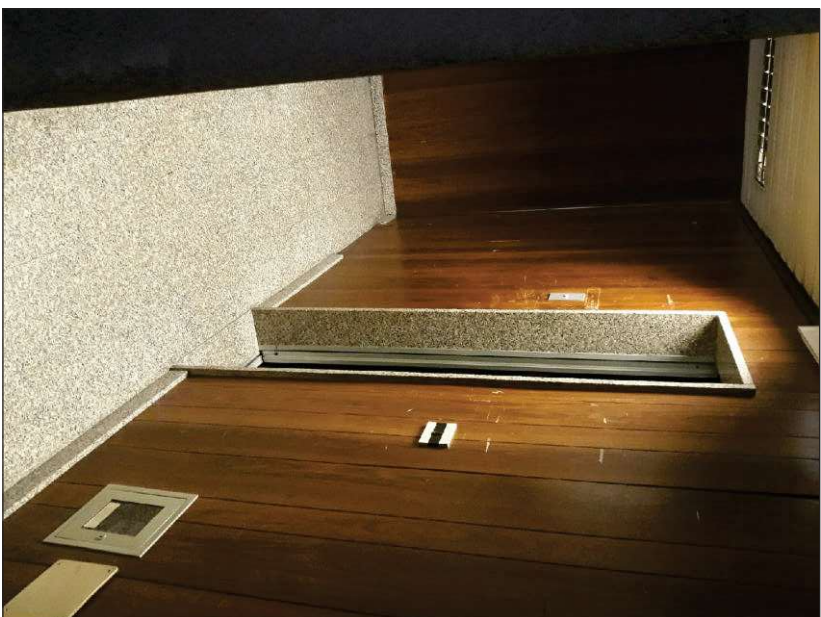
Ascensore al piano
