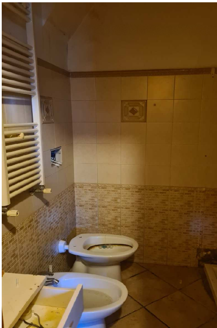
FOTO 18 VISTA INTERNA PIANO S1
