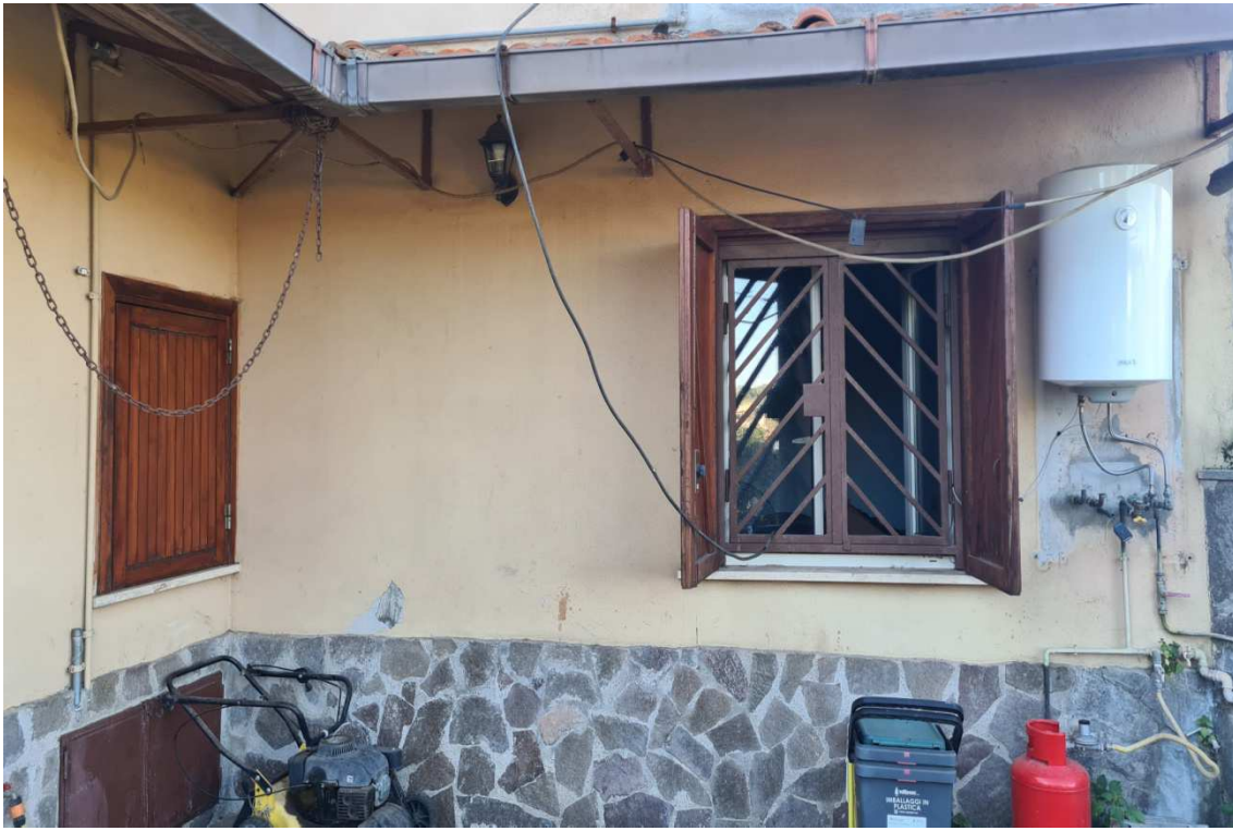
FOTO 8 VISTA ESTERNA FABBRICATO
