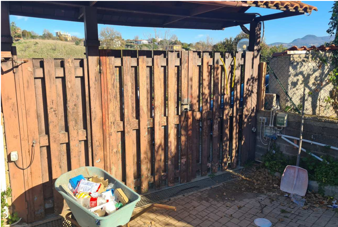
FOTO 1 INGRESSO ALLA PROPRIETA'
