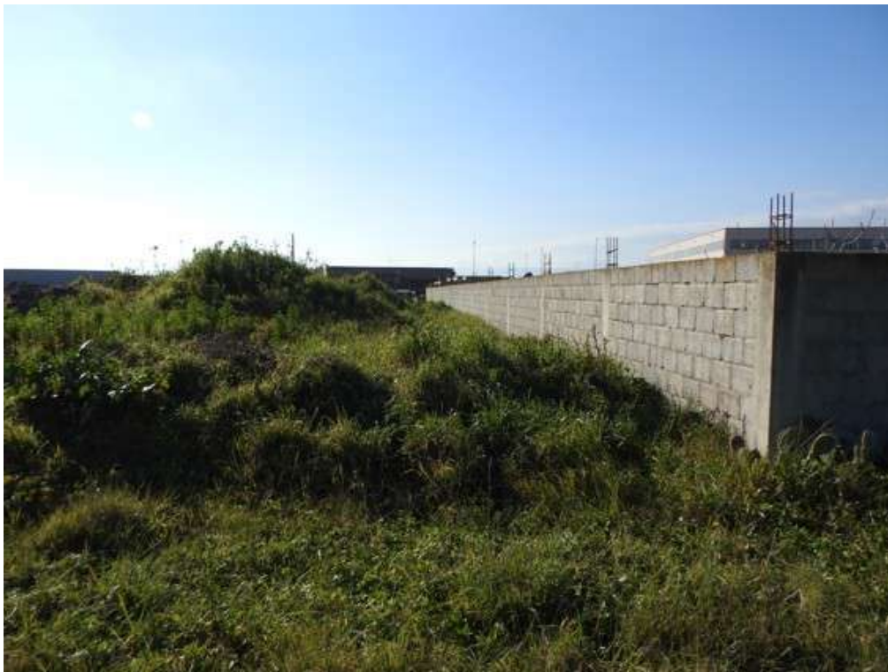
Fotografia F.8 - 08 - LIMITE LOTTO CONFINE NORD
