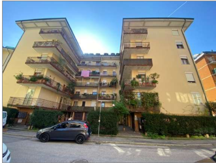
Fronte principale e ingresso condominiale
