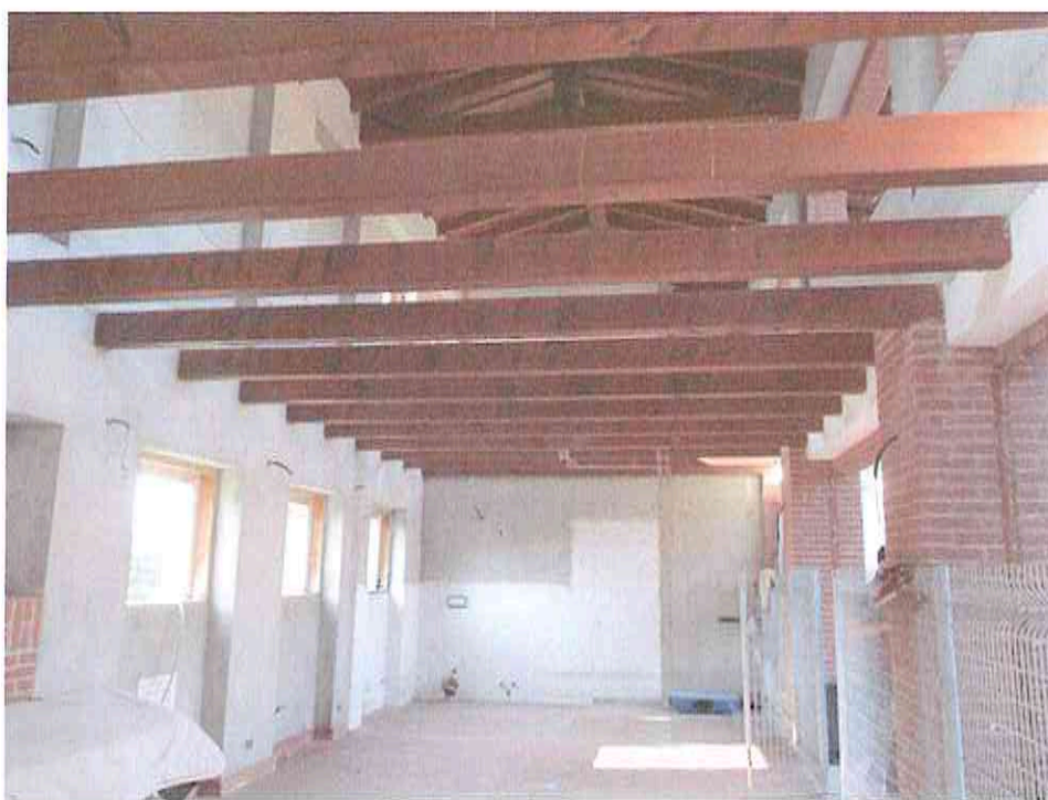
Foto 19 – Vista interna portico
