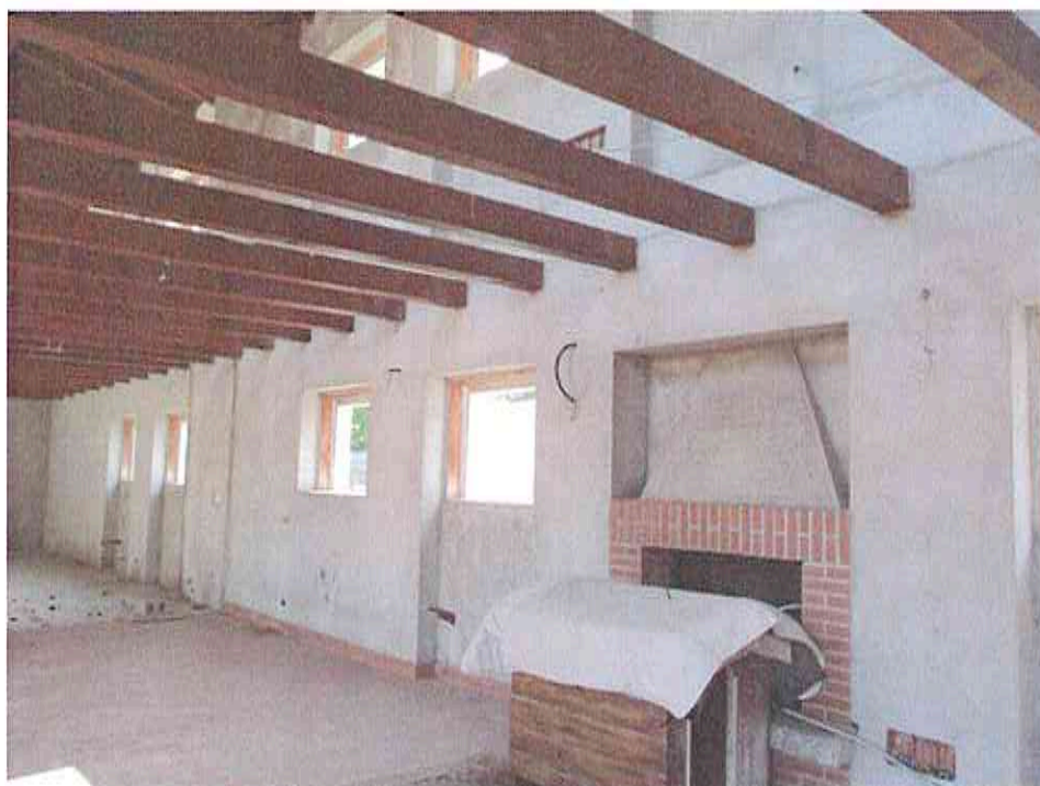
Foto 20 – Vista interna portico
