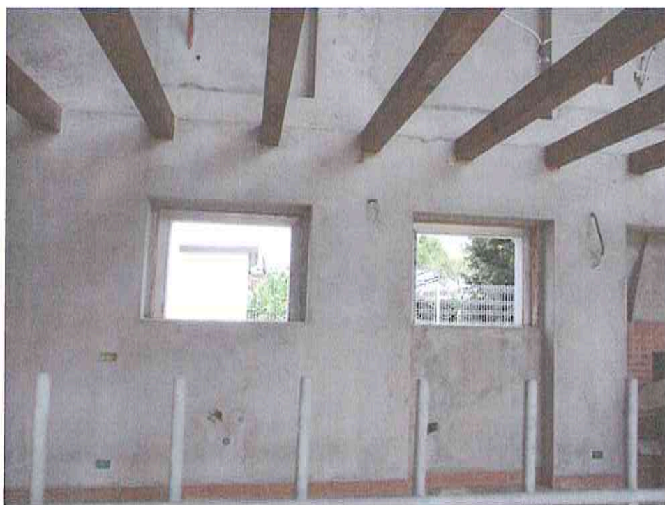
Foto 23 – Vista interna portico
