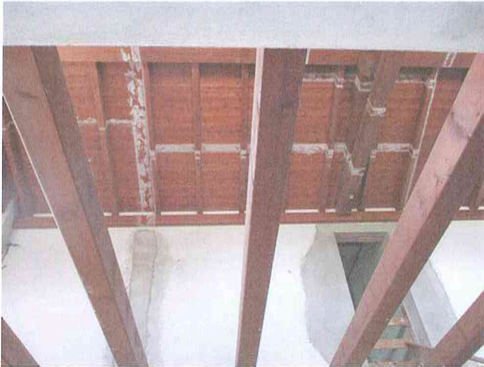
Foto 21 – Vista interna portico
