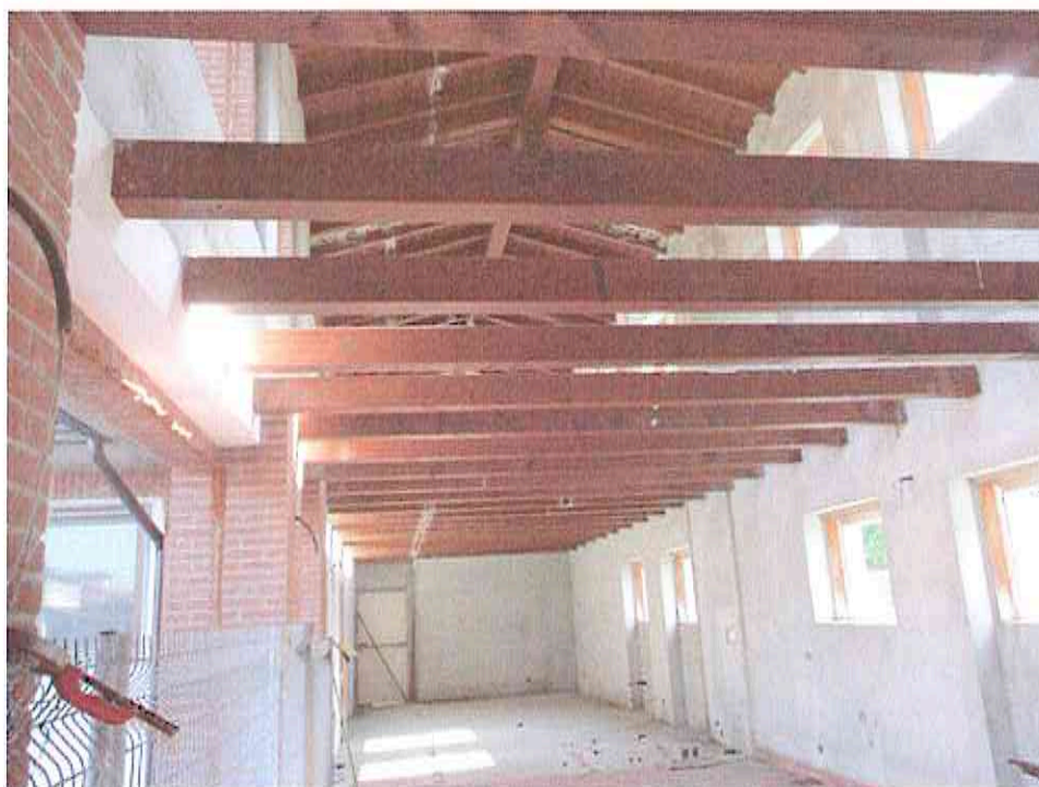
Foto 18 – Vista interna portico
