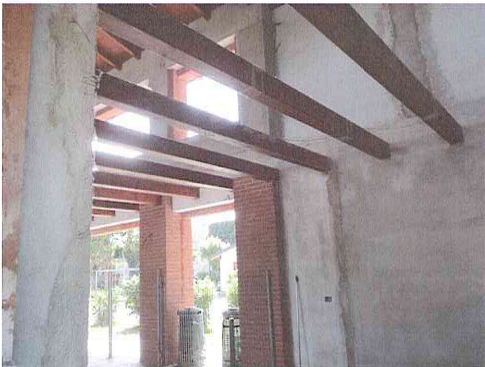
Foto 22 – Vista interna portico
