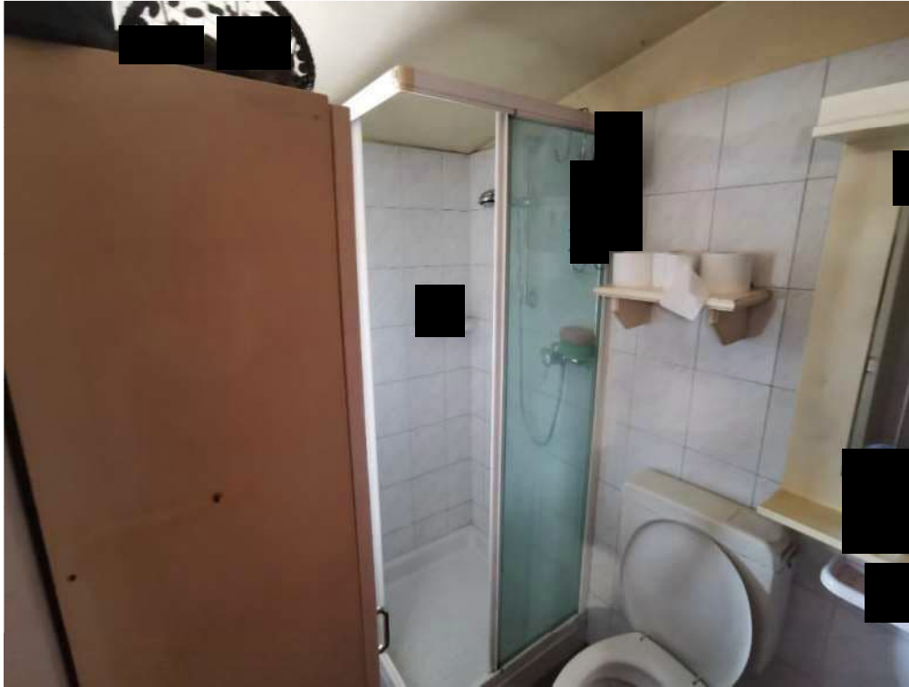
13 – particolare interno (vano accessorio)
