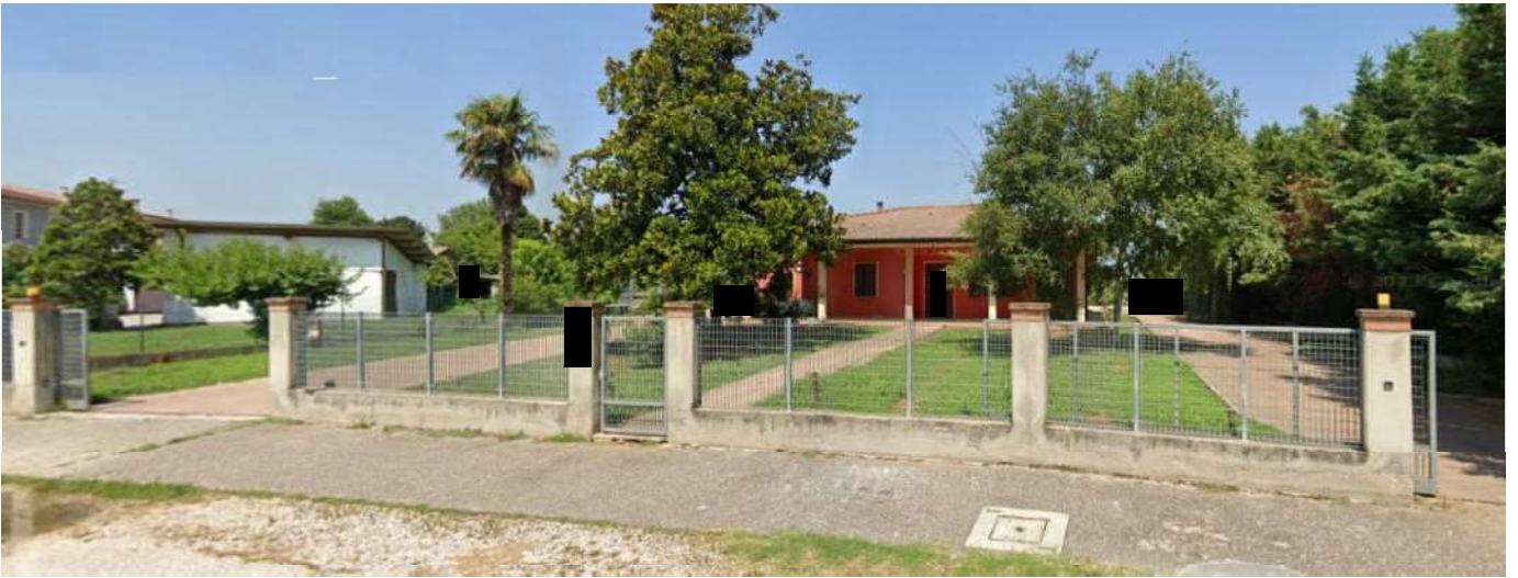
2. particolare prospetto principale con accessi dalla via pubblica
