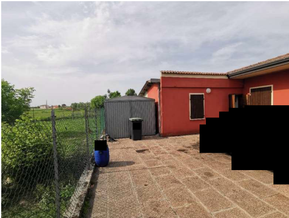
4 – particolare prospetto sud-ovest
