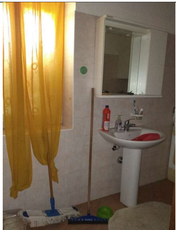
Immagine 24 - Bagno al piano terra
