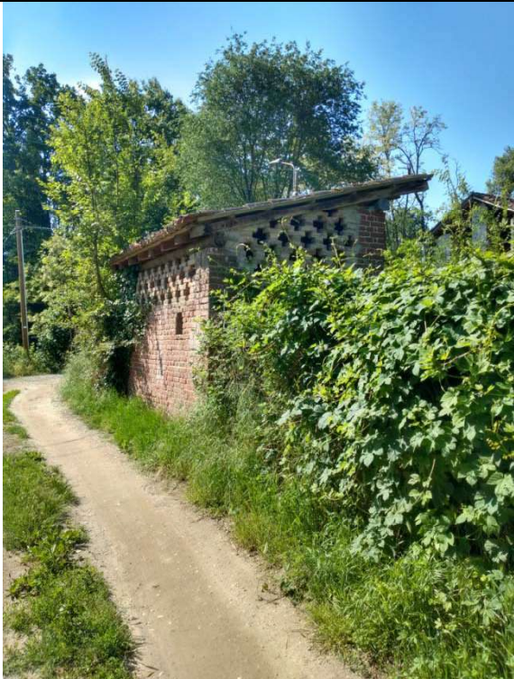
Immagine 3 – Blocco esterno accessorio all'abitazione (subalterno 2)
