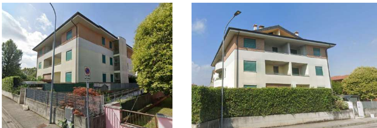
Figura 3. Foto esterne immobile.
