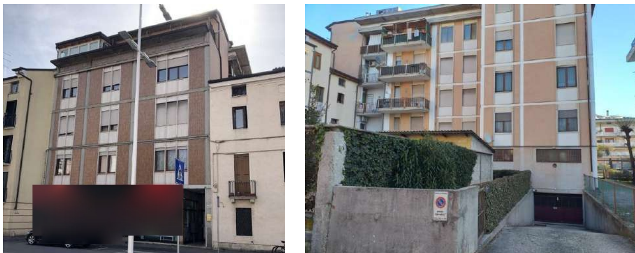
Figura 3. Foto esterne immobile.
