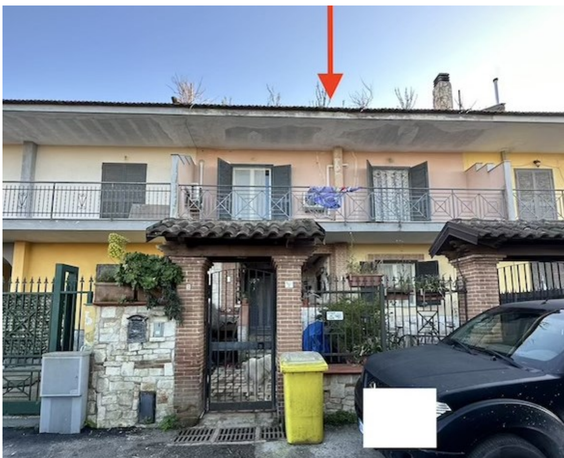
Foto n.1 – Panoramica fabbricato dalla strada d'accesso
