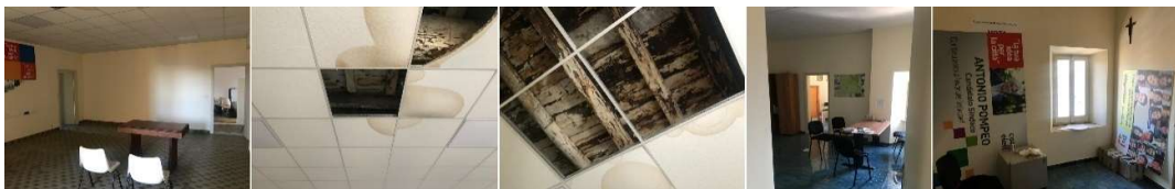
1) Vista Ufficio1; 2-3) Dettaglio controsoffitto dell'Ufficio1; 4) Vista Ufficio2; 5) Vista Ambiente2
