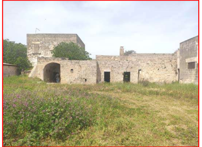
Foto 2 - Lotto 2 – Corpo D – Masseria Chiusa – fgl.58, ptc.132
