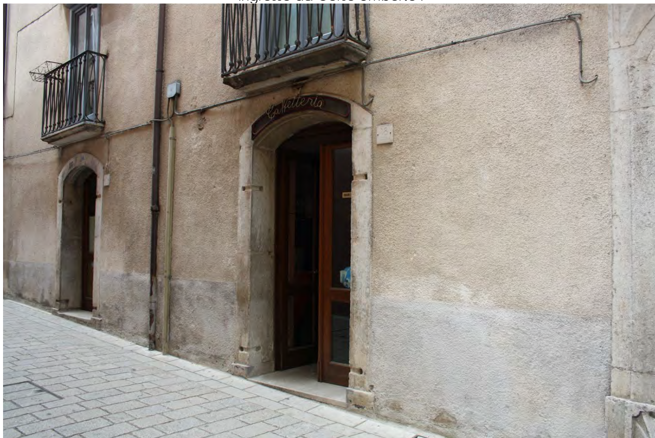
LOTTO D - foto n. 1 - ingresso da Corso Umberto I
