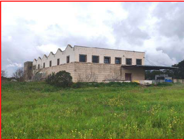
Foto 1 - Lotto 1 – Corpo A – stabilimento vinicolo
