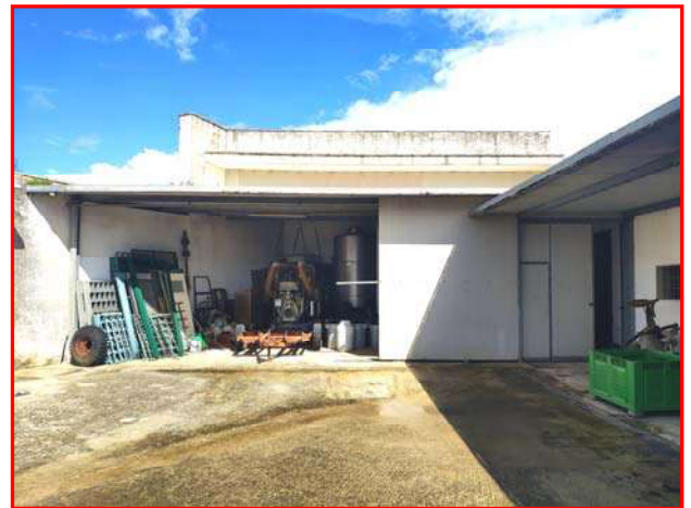
Foto 28 - Lotto 1 – Corpo B – frantoio – scoperto retrostante con tettoie
