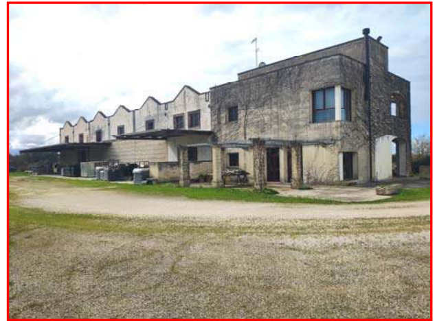
Foto 2 - Lotto 1 – Corpo A – stabilimento vinicolo
