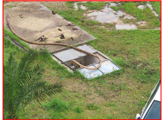
Foto 26 - Lotto 1 – Corpo B - frantoio – pozzo artesiano
