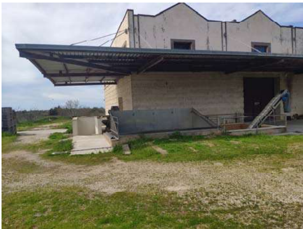
Foto 17 - Lotto 1 – Corpo A – stabilimento vinicolo – esterno
