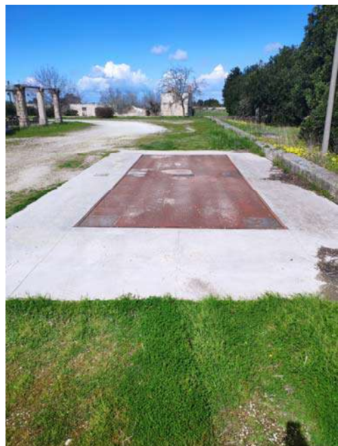
Foto 18 - Lotto 1 – Corpo A – stabilimento vinicolo – esterno
