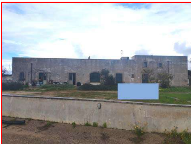
Foto 19 - Lotto 1 – Corpo B– frantoio
