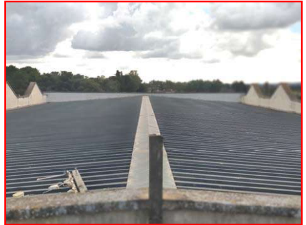
Foto 16 - Lotto 1 – Corpo A – stabilimento vinicolo – piano coperture
