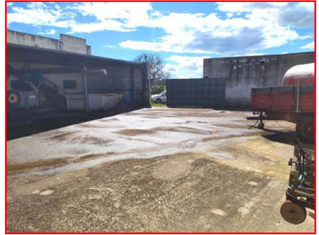
Foto 32 - Lotto 1 – Corpo B – frantoio – scoperto retrostante
