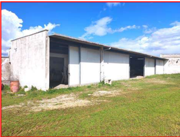
Foto 33 - Lotto 1 – Corpo B – deposito attrezzi agricoli - esterno
