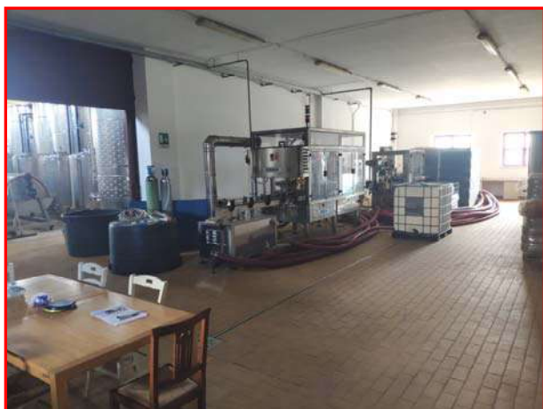
Foto 9 - Lotto 1 – Corpo A – stabilimento vinicolo – piano terra
