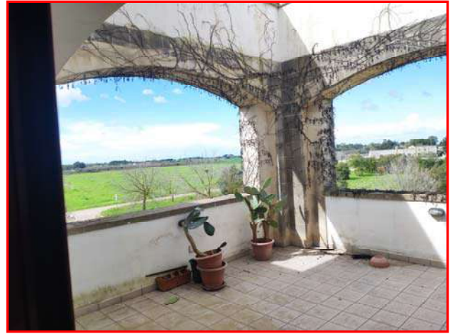
Foto 14 - Lotto 1 – Corpo A – stabilimento vinicolo – piano primo
