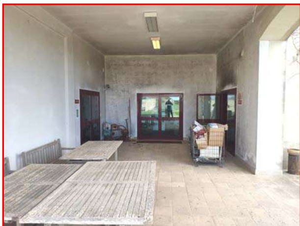
Foto 7 - Lotto 1 – Corpo A – stabilimento vinicolo – piano terra
