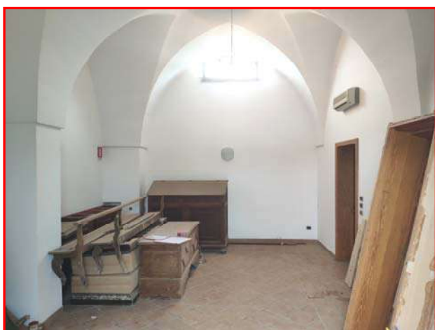
Foto 23 - Lotto 1 – Corpo B - frantoio – ex-uffici
