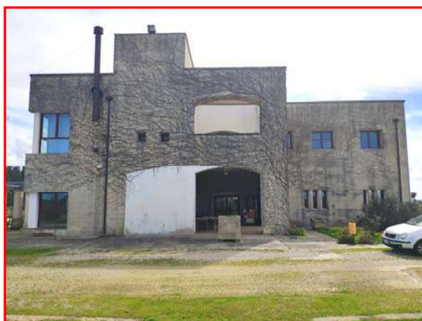
Foto 12 - Lotto 1 – Corpo A – stabilimento vinicolo – ingresso
