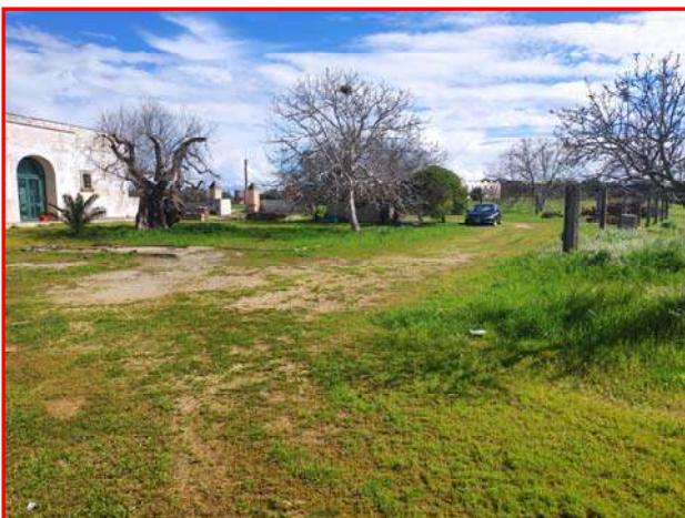
Foto 35 - Lotto 1 – Corpo B – frantoio – scoperto laterale
