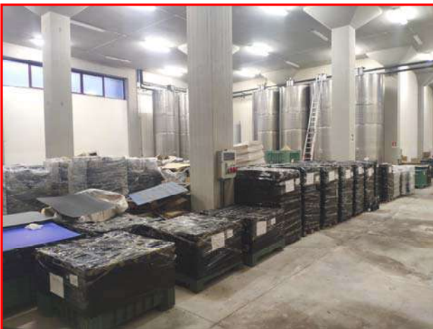
Foto 3 - Lotto 1 – Corpo A – stabilimento vinicolo – 2° p. interrato
