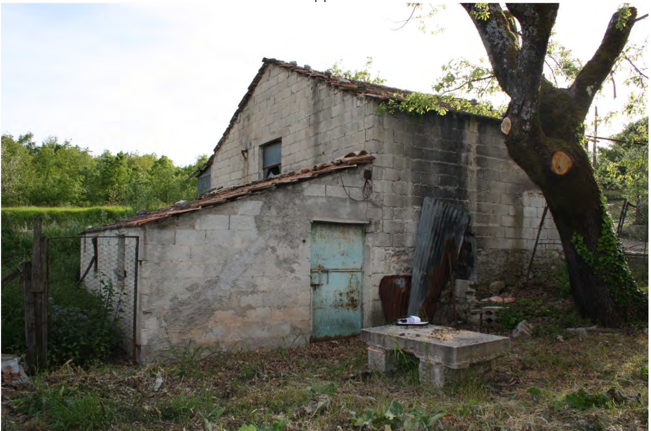
LOTTO E – foto n. 25 fabbricato 5 mappale 772 – esterno
