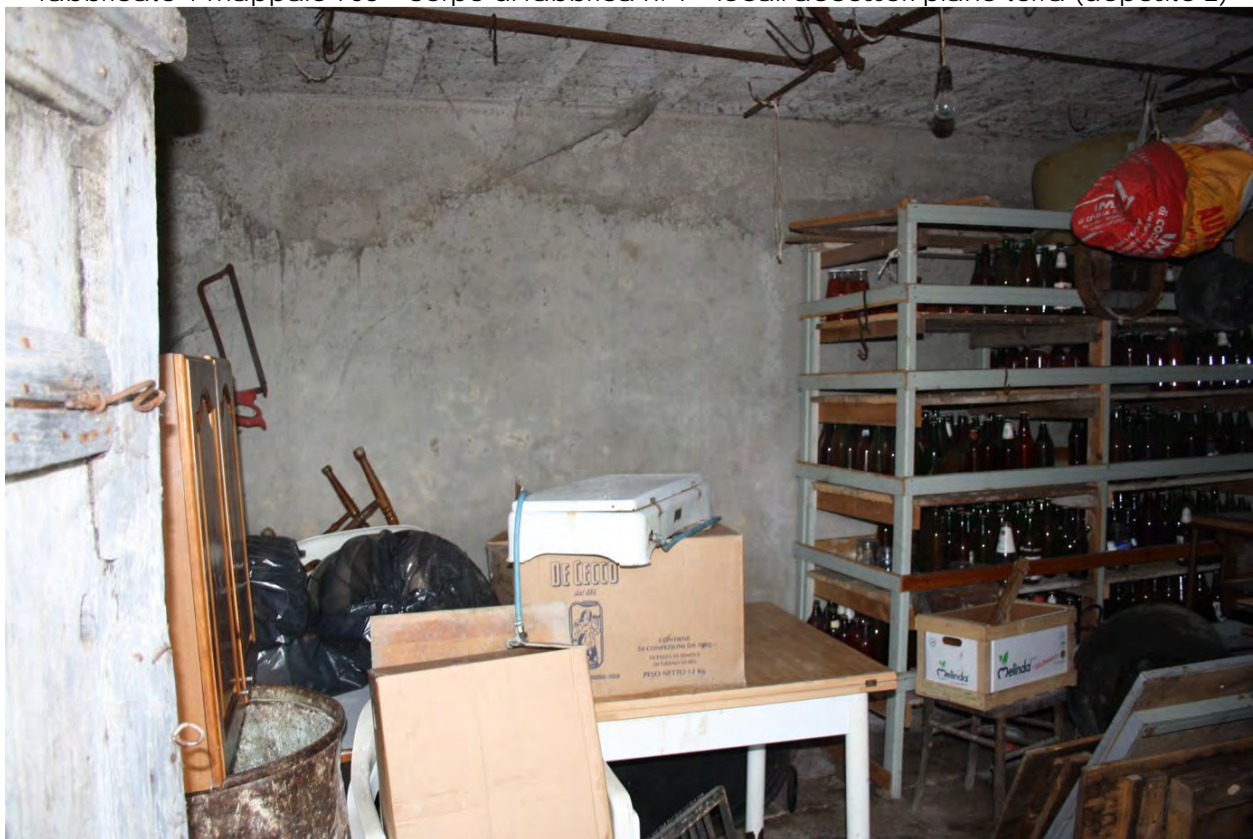
LOTTO E – foto n. 15 fabbricato 1 mappale 768 – corpo di fabbrica n. 1 – locali accessori piano terra (deposito 2)
