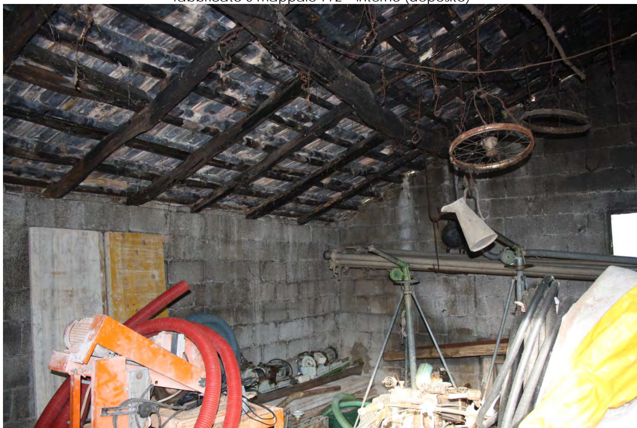
LOTTO E – foto n. 26 fabbricato 5 mappale 772 – interno (deposito)
