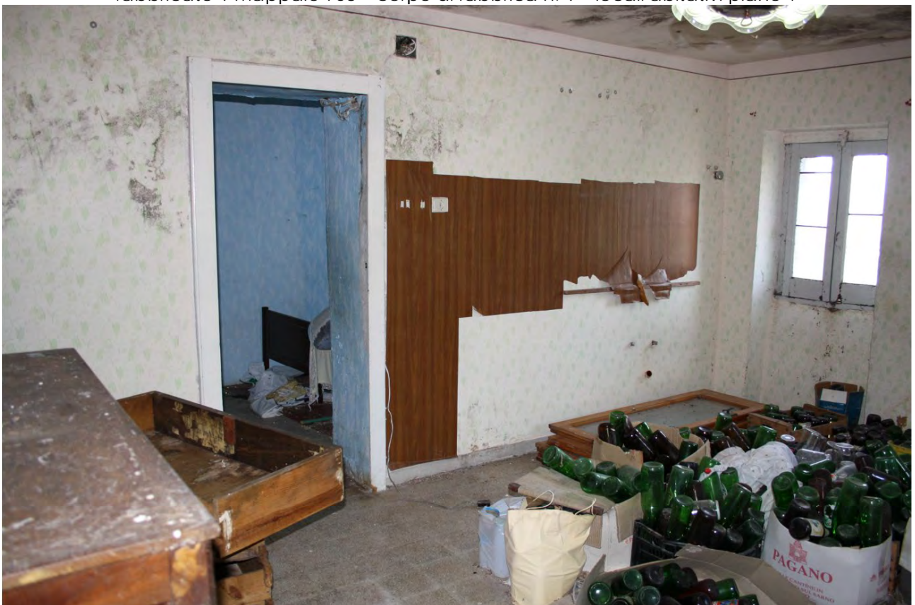
LOTTO E – foto n. 8 fabbricato 1 mappale 768 – corpo di fabbrica n. 1 – locali abitativi piano 1
