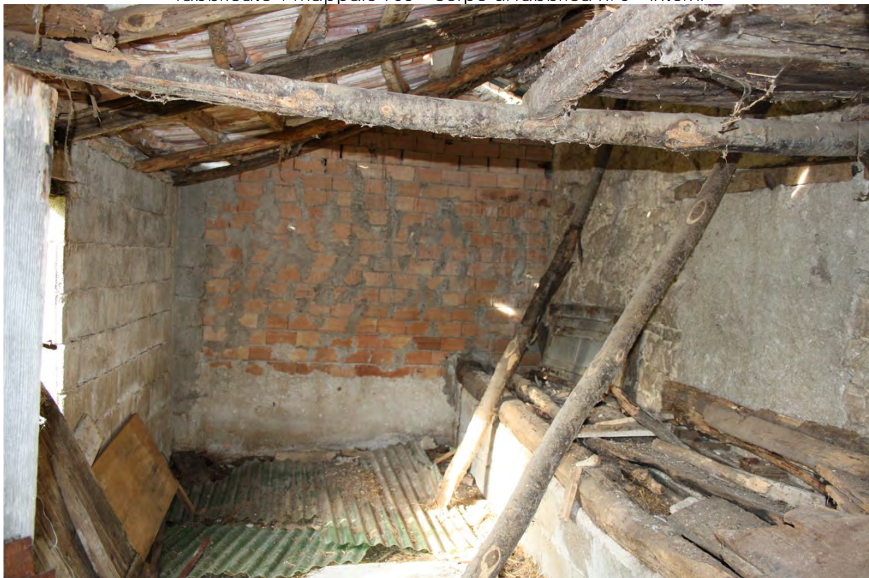
LOTTO E - foto n. 19 fabbricato 1 mappale 768 - corpo di fabbrica n. 3 - interni
