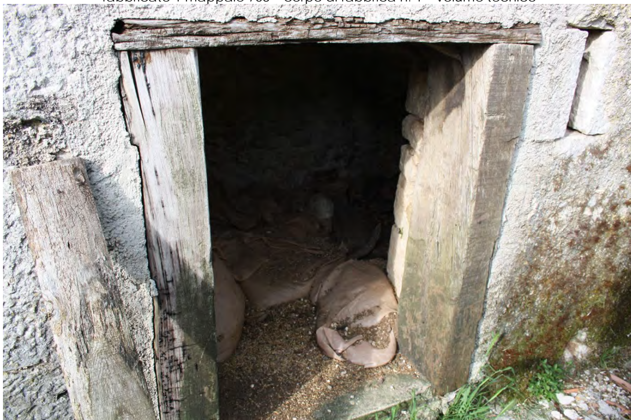
LOTTO E – foto n. 17 fabbricato 1 mappale 768 – corpo di fabbrica n. 1 – volume tecnico
