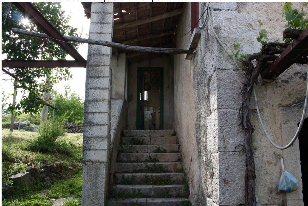
LOTTO E – foto n. 4 fabbricato 1 mappale 768 – corpo di fabbrica n. 1 – scala esterna
