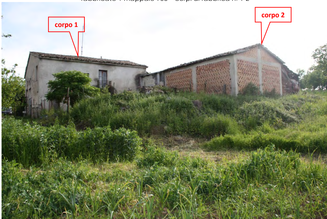
LOTTO E – foto n. 3 – fabbricato 1 mappale 768 – corpi di fabbrica n. 1-2
