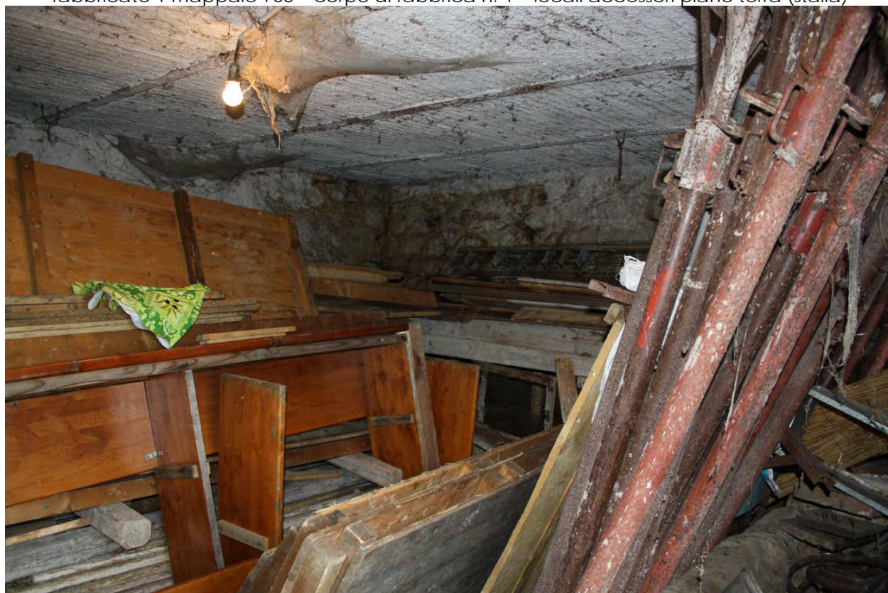
LOTTO E – foto n. 16 fabbricato 1 mappale 768 – corpo di fabbrica n. 1 – locali accessori piano terra (stalla)
