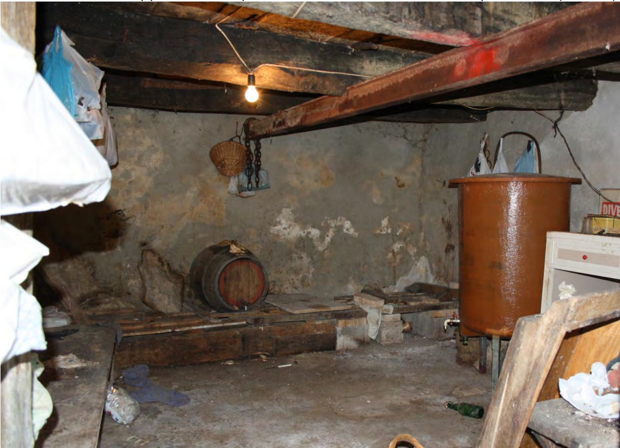
LOTTO E - foto n. 13 fabbricato 1 mappale 768 - corpo di fabbrica n. 1 - locali accessori piano terra (cantina)
