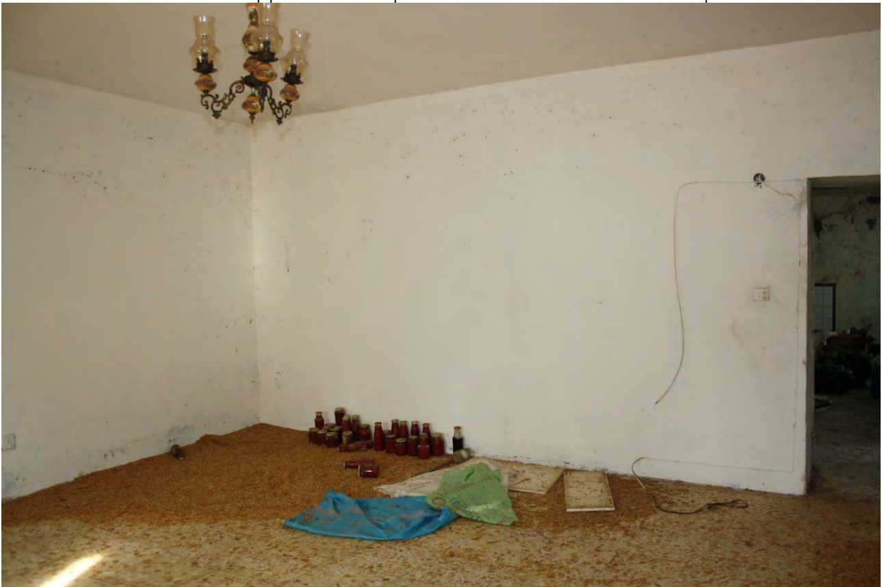
LOTTO E – foto n. 9 fabbricato 1 mappale 768 – corpo di fabbrica n. 1 – locali abitativi piano 1
