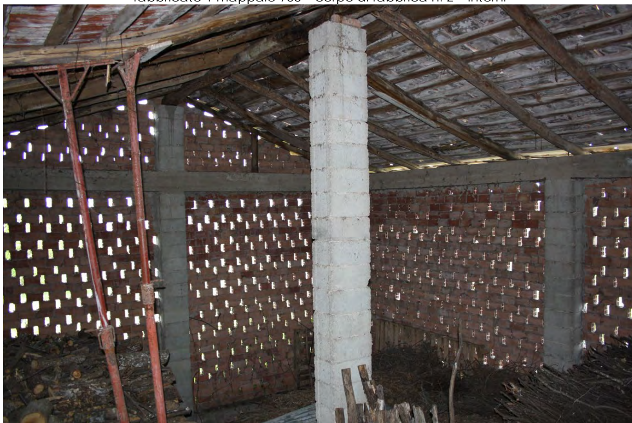
LOTTO E – foto n. 18 fabbricato 1 mappale 768 – corpo di fabbrica n. 2 – interni
