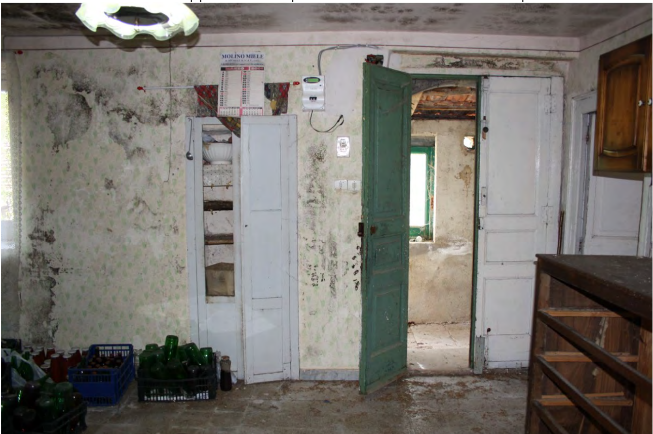
LOTTO E – foto n. 10 fabbricato 1 mappale 768 – corpo di fabbrica n. 1 – locali abitativi piano 1
