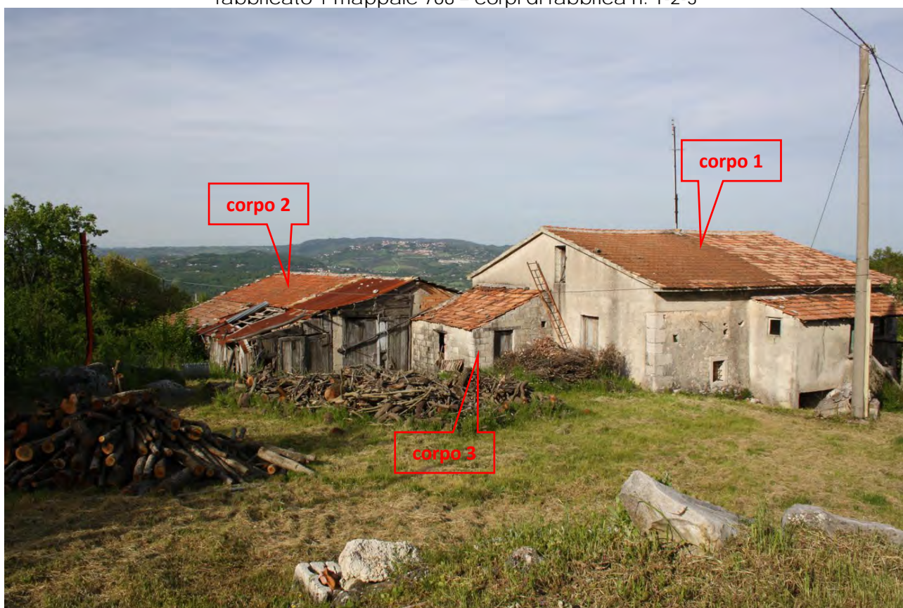
LOTTO E – foto n. 2 – fabbricato 1 mappale 768 – corpi di fabbrica n. 1-2-3
