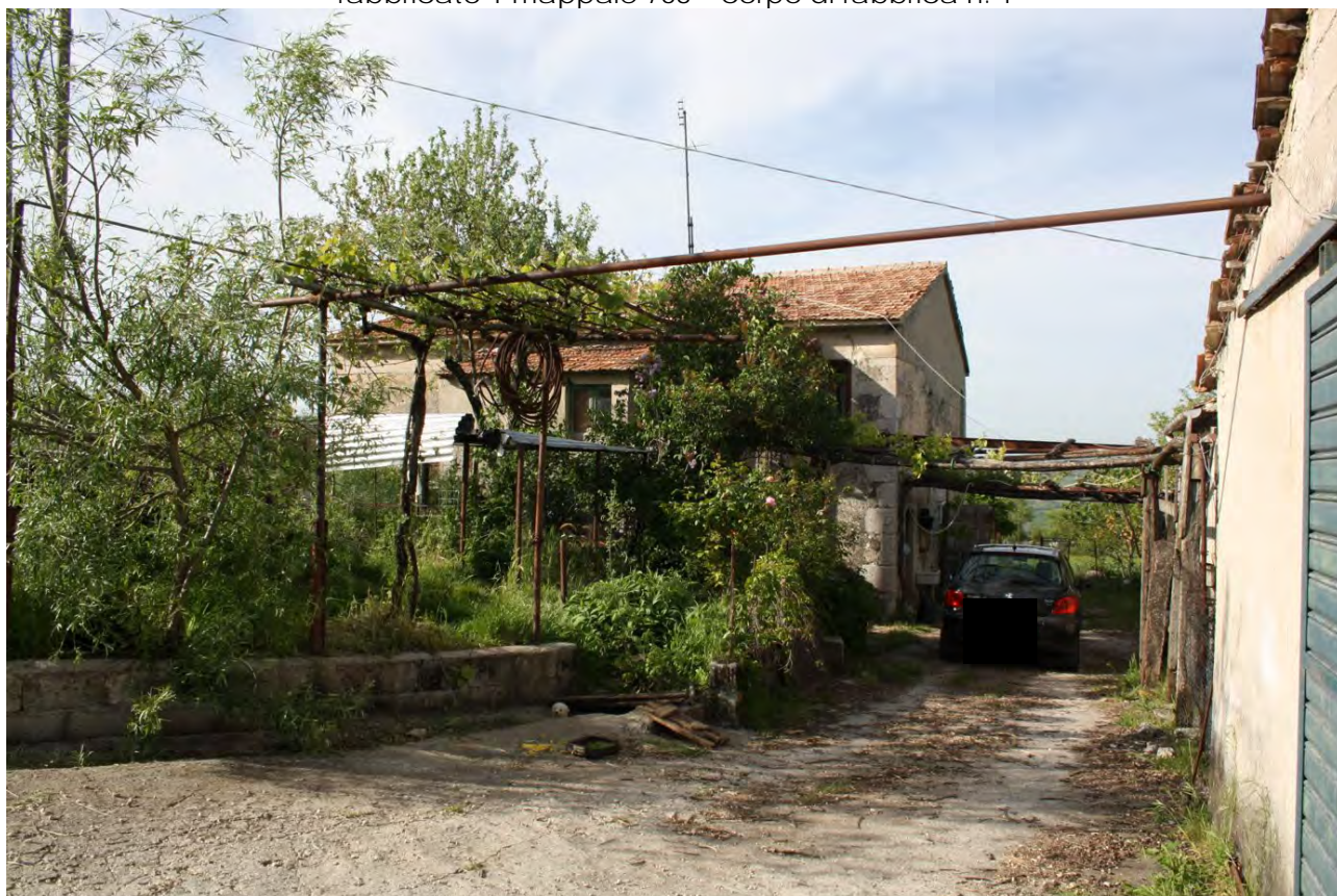
LOTTO E – foto n. 1 – fabbricato 1 mappale 768 – corpo di fabbrica n. 1
