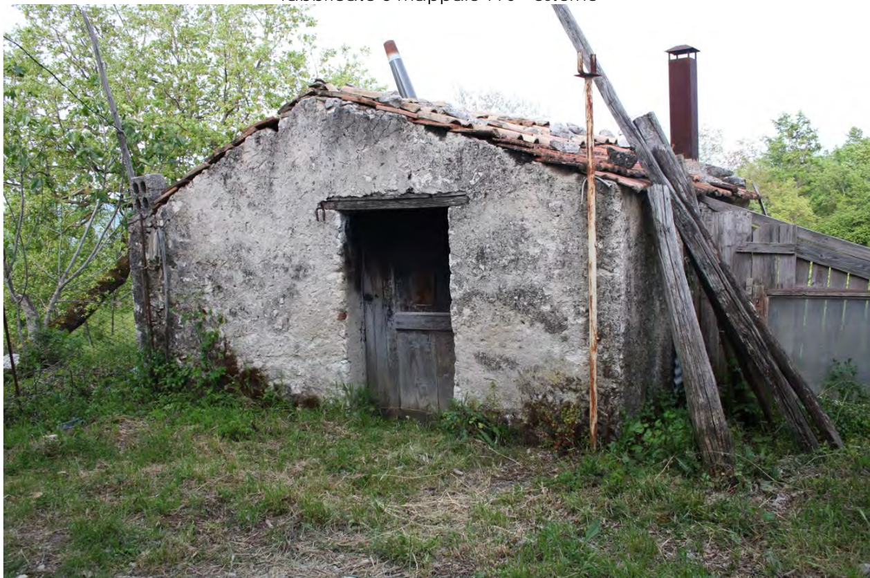
LOTTO E – foto n. 20 fabbricato 3 mappale 770 - esterno
