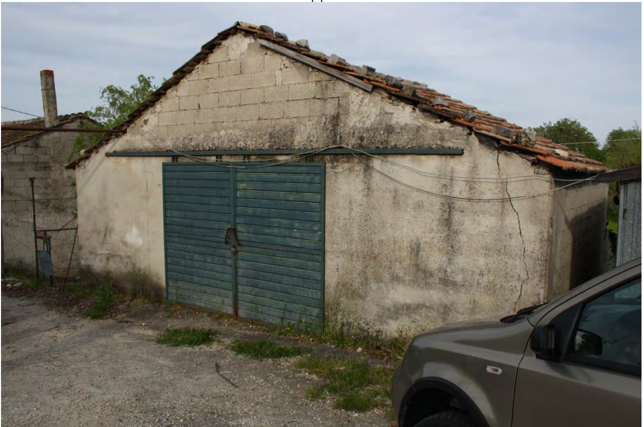
LOTTO E – foto n. 24 fabbricato 5 mappale 772 – esterno
