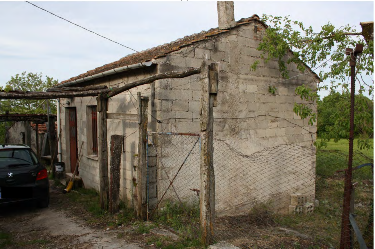
LOTTO E – foto n. 22 fabbricato 4 mappale 771 – esterno
