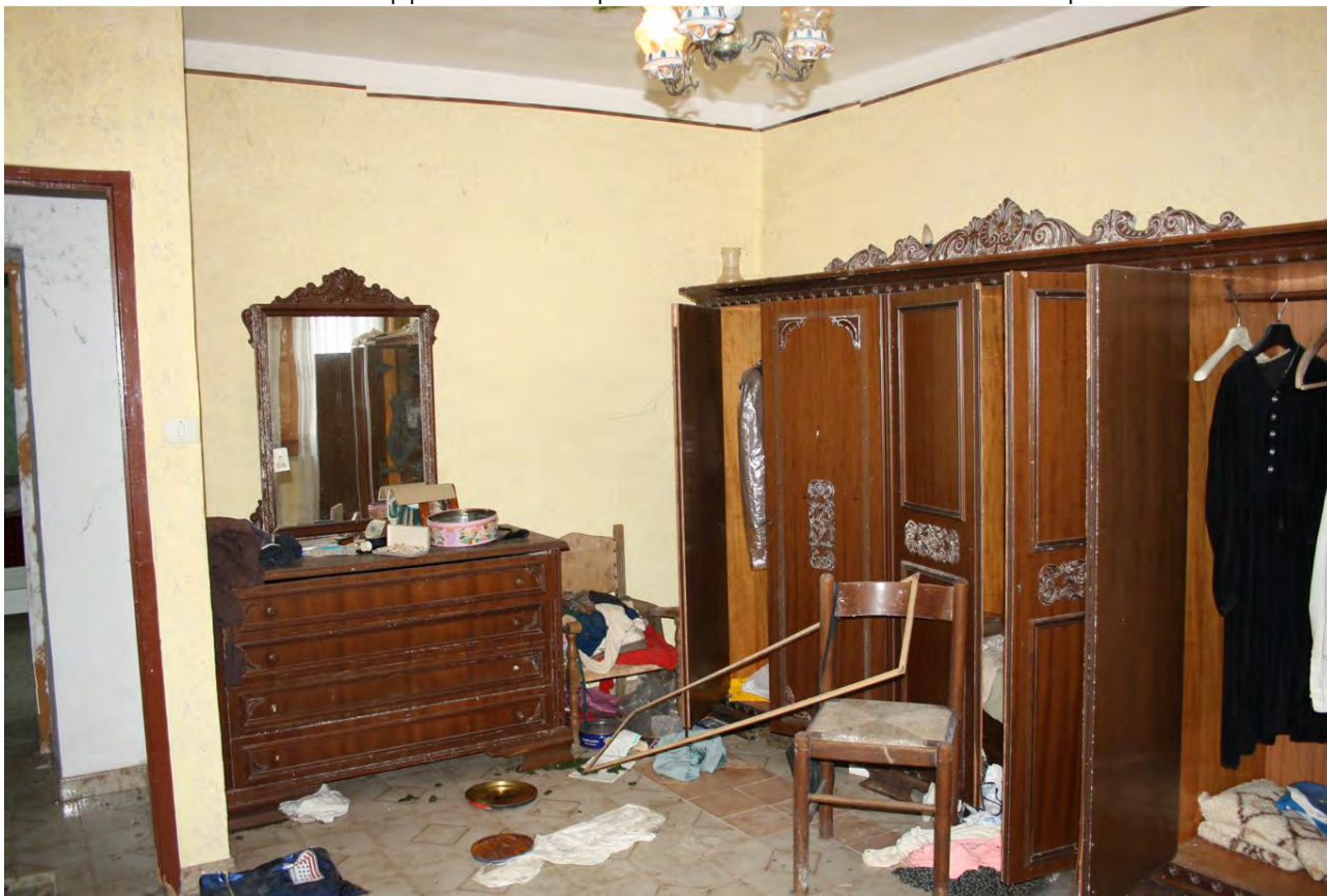
LOTTO E – foto n. 11 fabbricato 1 mappale 768 – corpo di fabbrica n. 1 – locali abitativi piano 1
