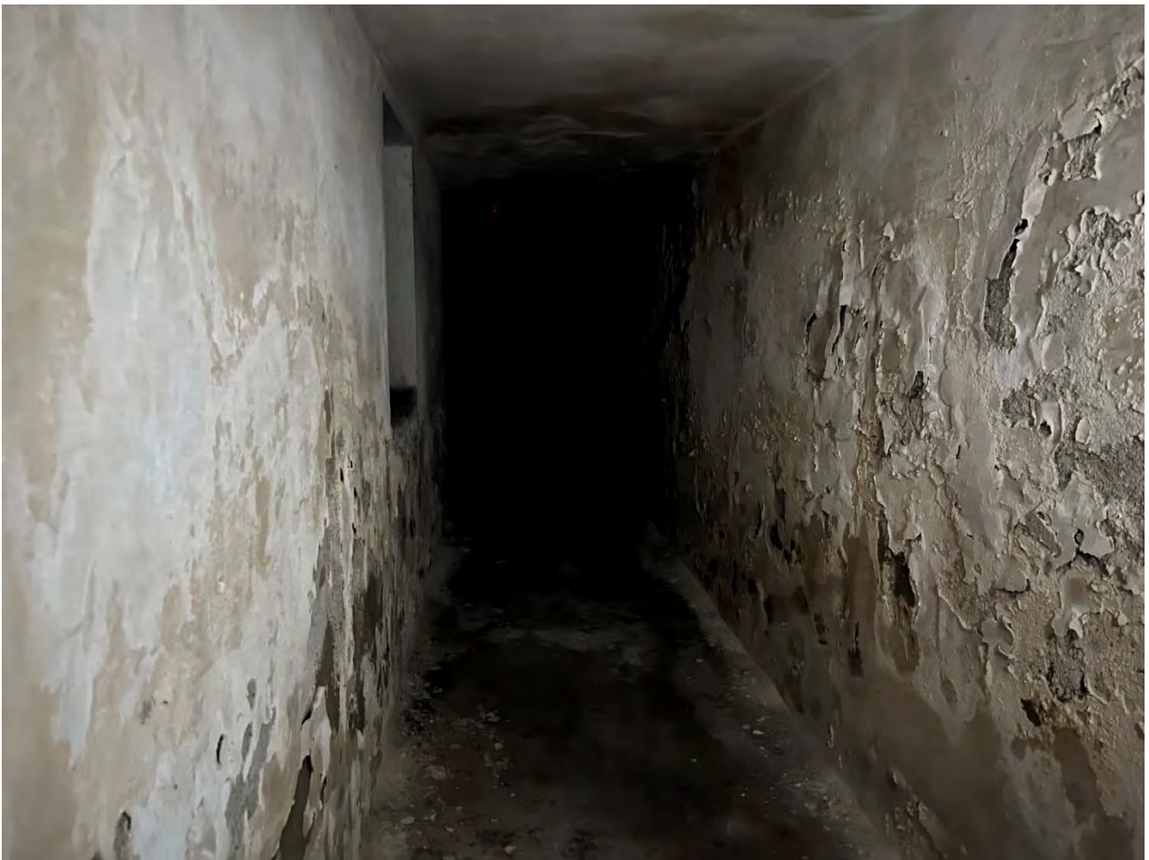
Foto 15 – Vista degli ambienti al piano seminterrato (sub 6)
