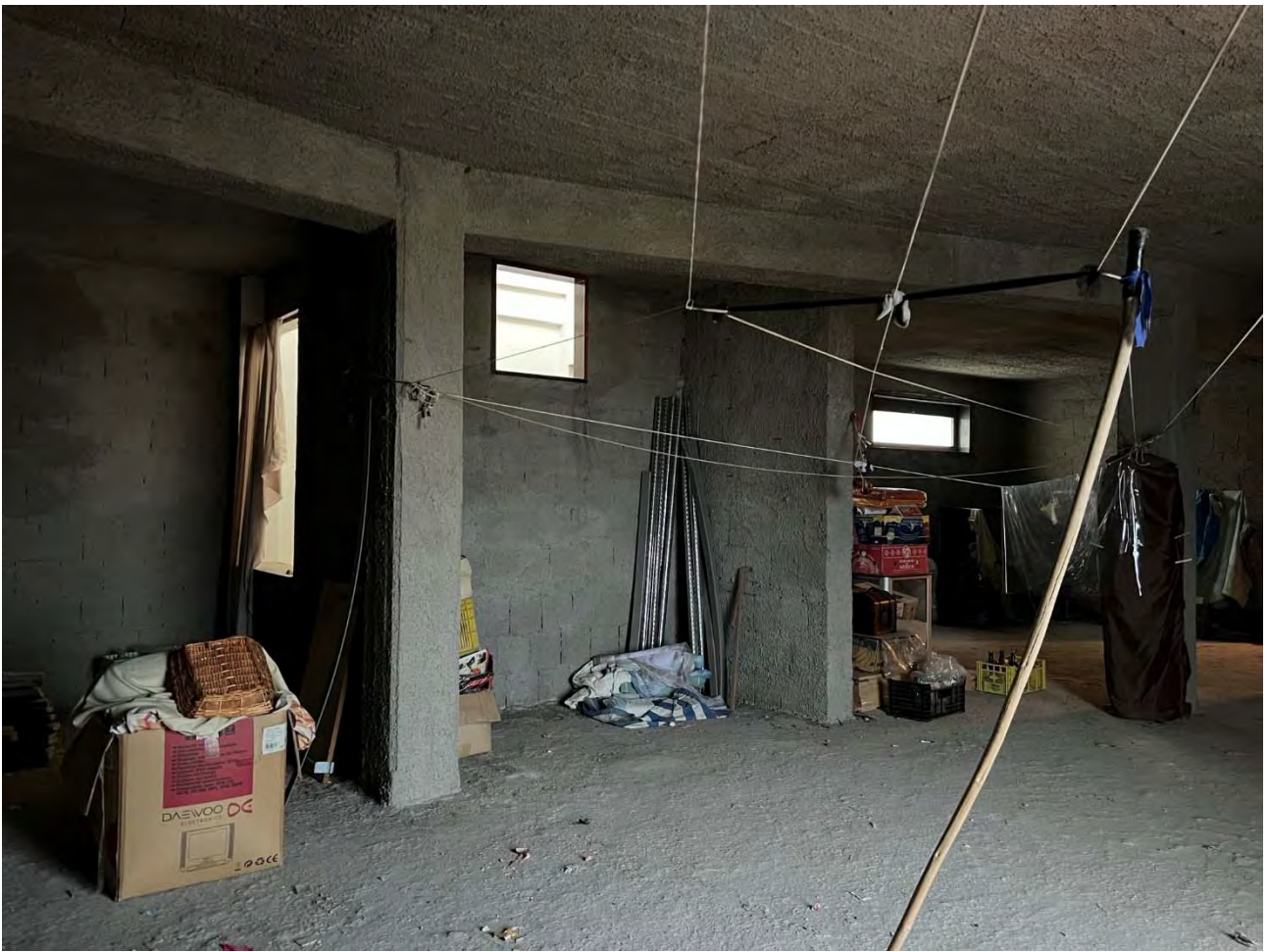
Foto 31 – Vista degli ambienti al piano secondo (sub 5)
