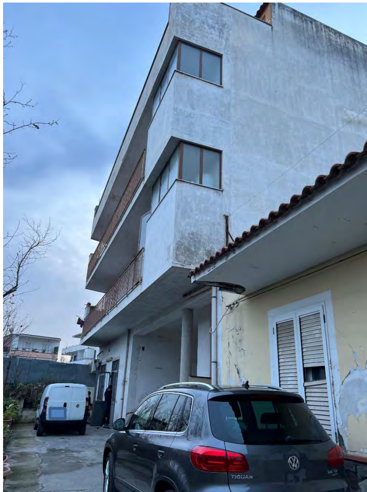
Foto 1 – Vista del piccolo fabbricato di vicolo del Canto n. 27/3, San Giuseppe Vesuviano (Na)
