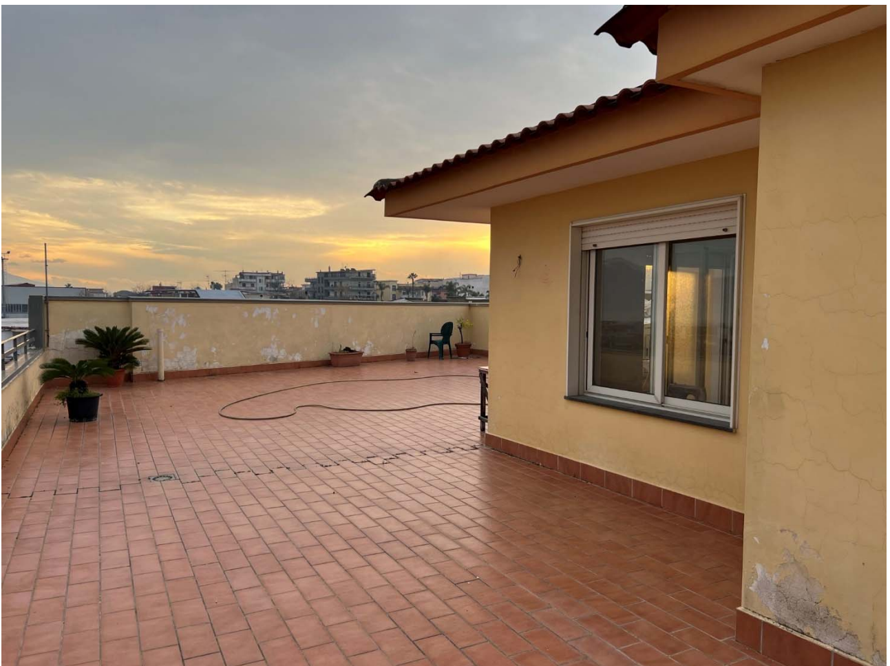
Foto 42 – Vista del terrazzo di copertura
