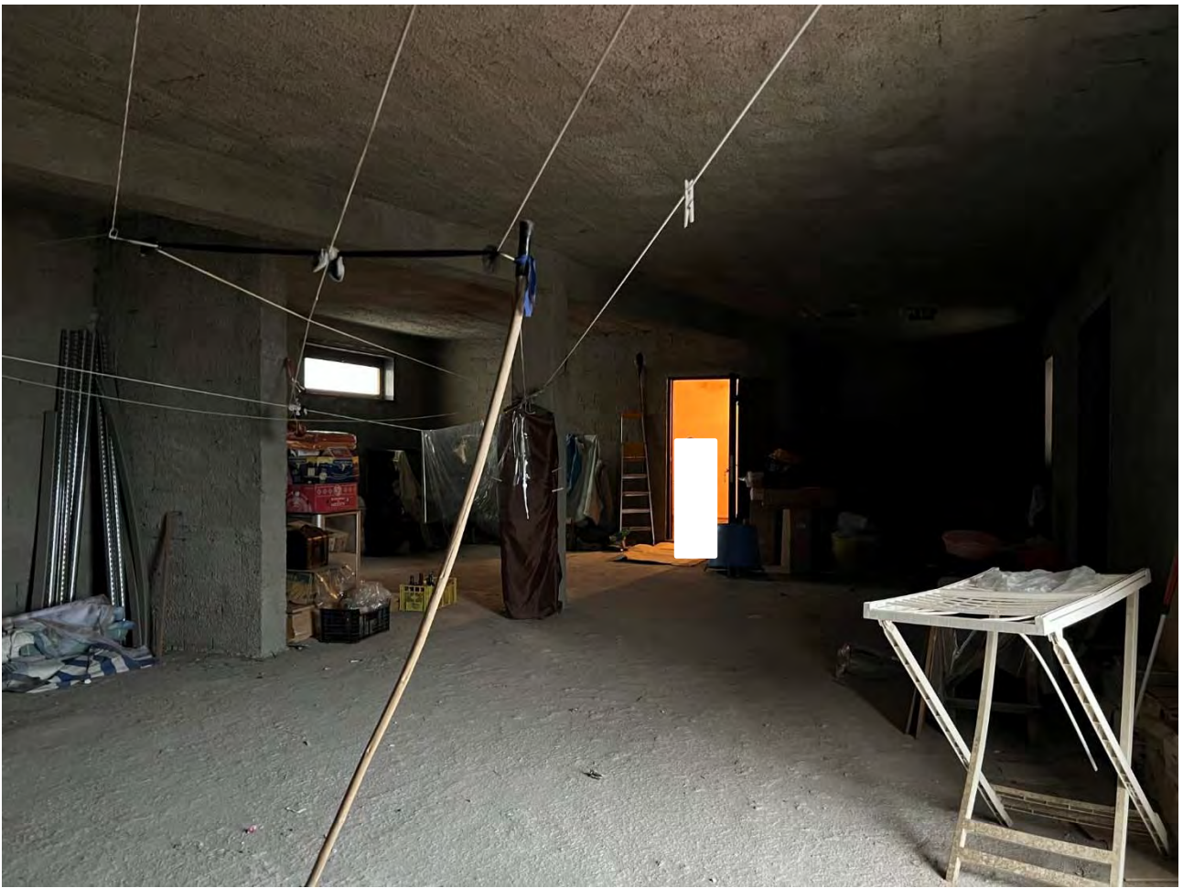
Foto 29 – Vista degli ambienti al piano secondo (sub 5)
