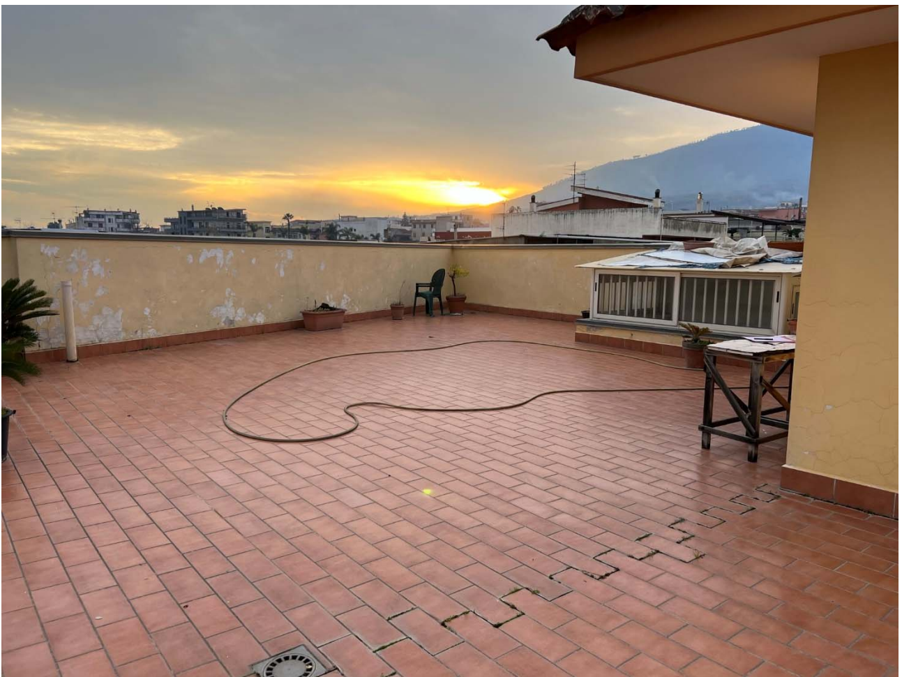
Foto 41 – Vista del terrazzo di copertura
