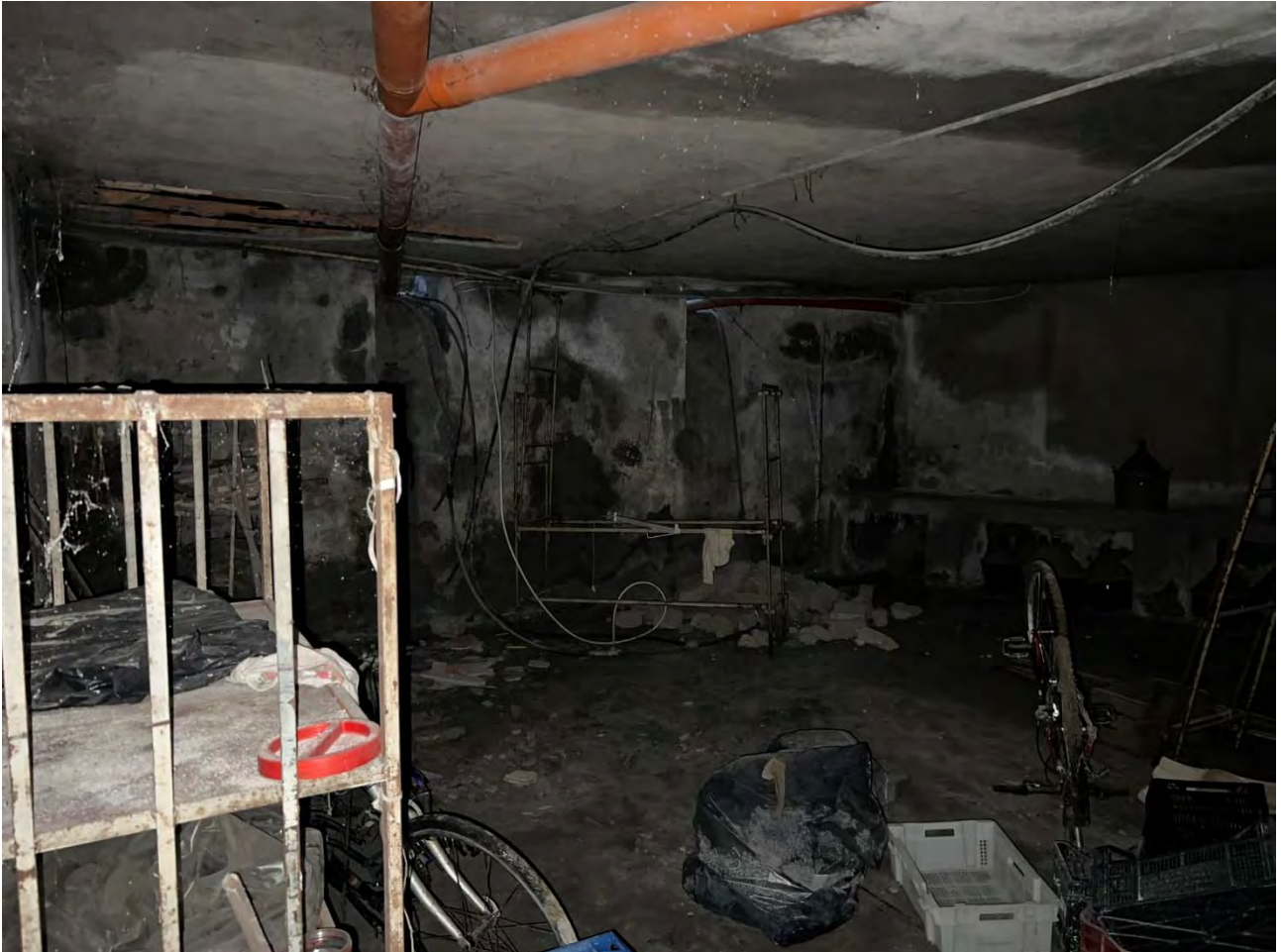
Foto 14 – Vista degli ambienti al piano seminterrato (sub 6)
