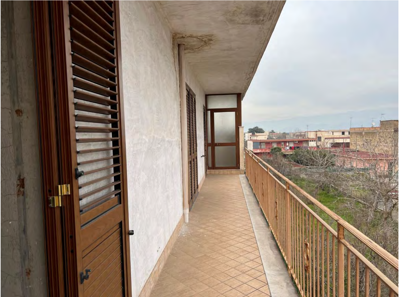
Foto 32 – Vista del balcone annesso all'unità del piano secondo (sub 5)
