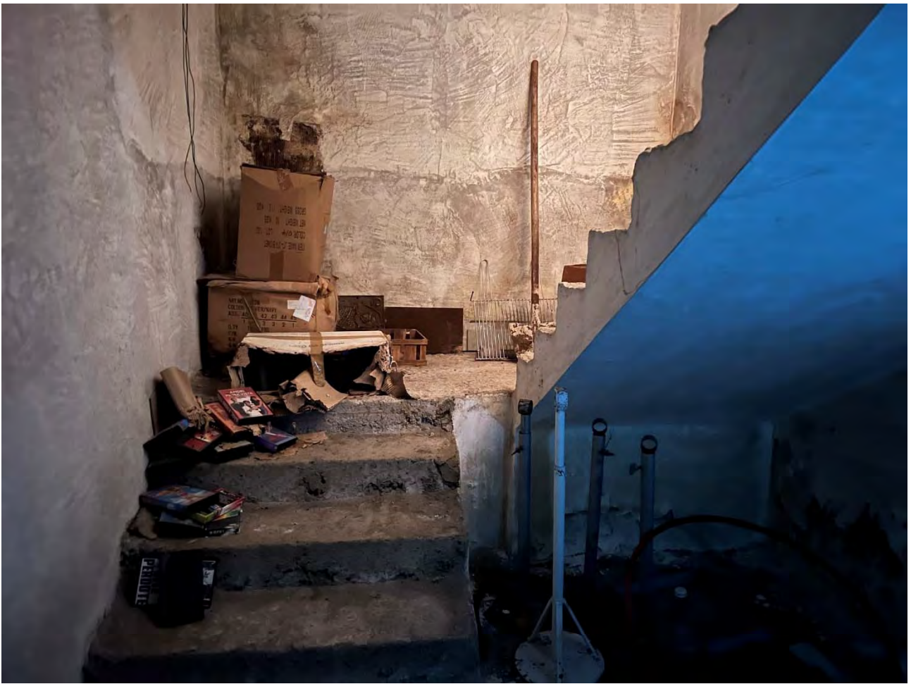
Foto 13 – Vista della scala che porta al piano seminterrato (sub 6)
