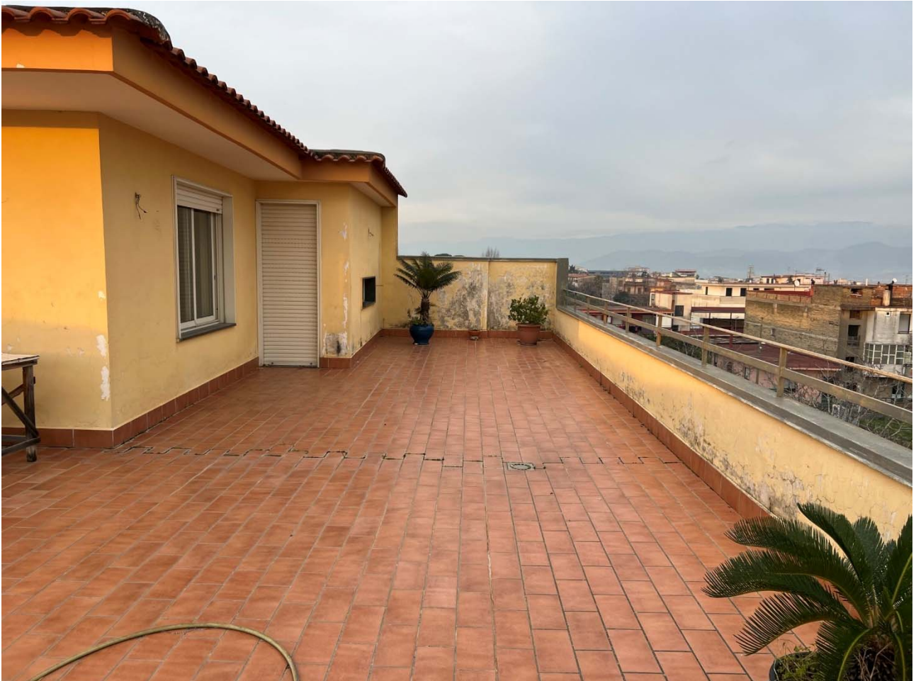
Foto 40 – Vista del terrazzo di copertura
