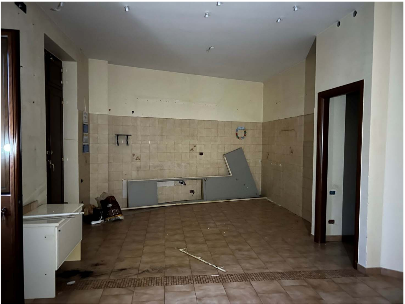
Foto 9 – Vista di uno degli ambienti al piano terra (sub 2)
