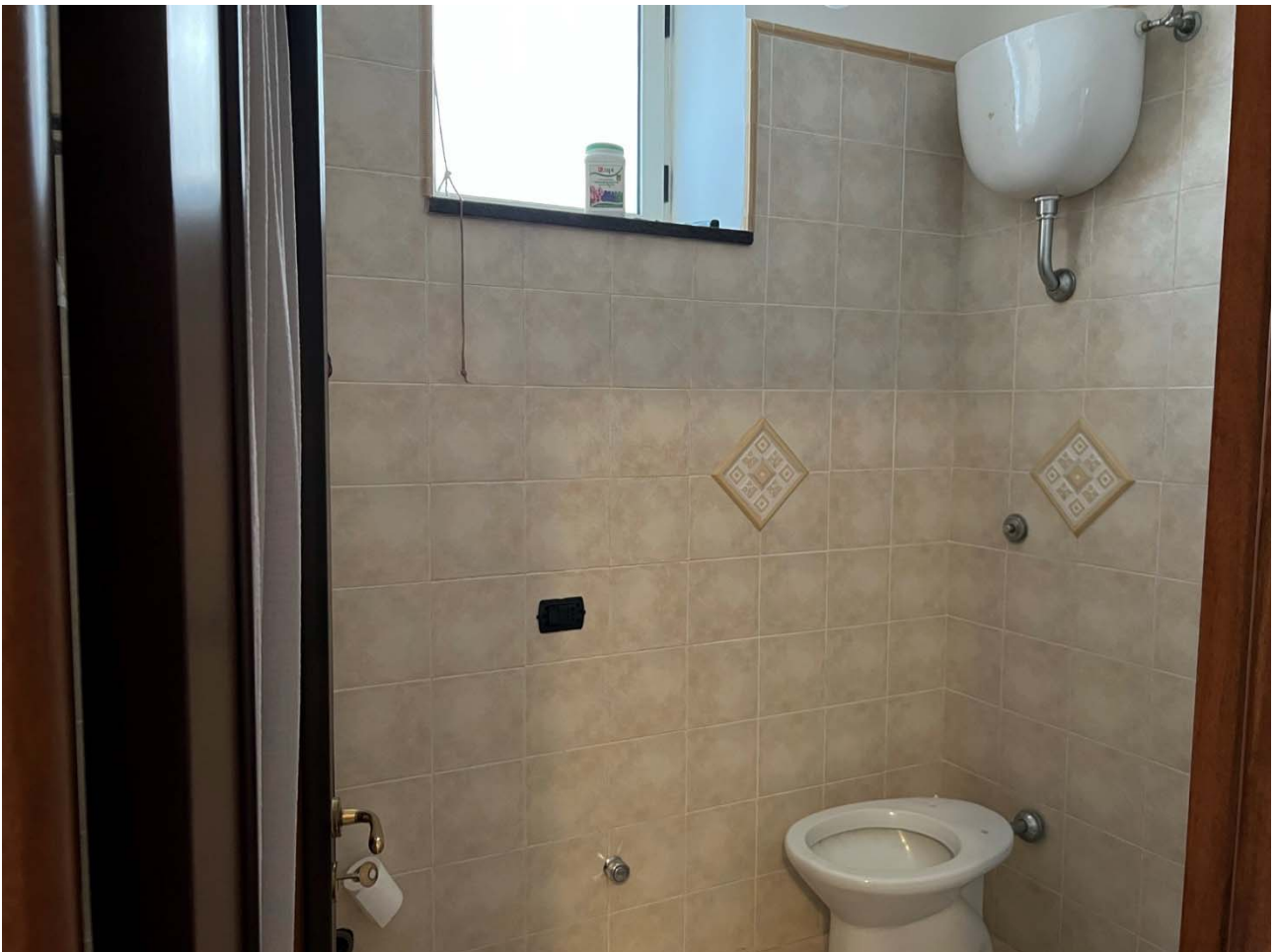
Foto 38 – Vista del bagno dell'unità realizzata in copertura
