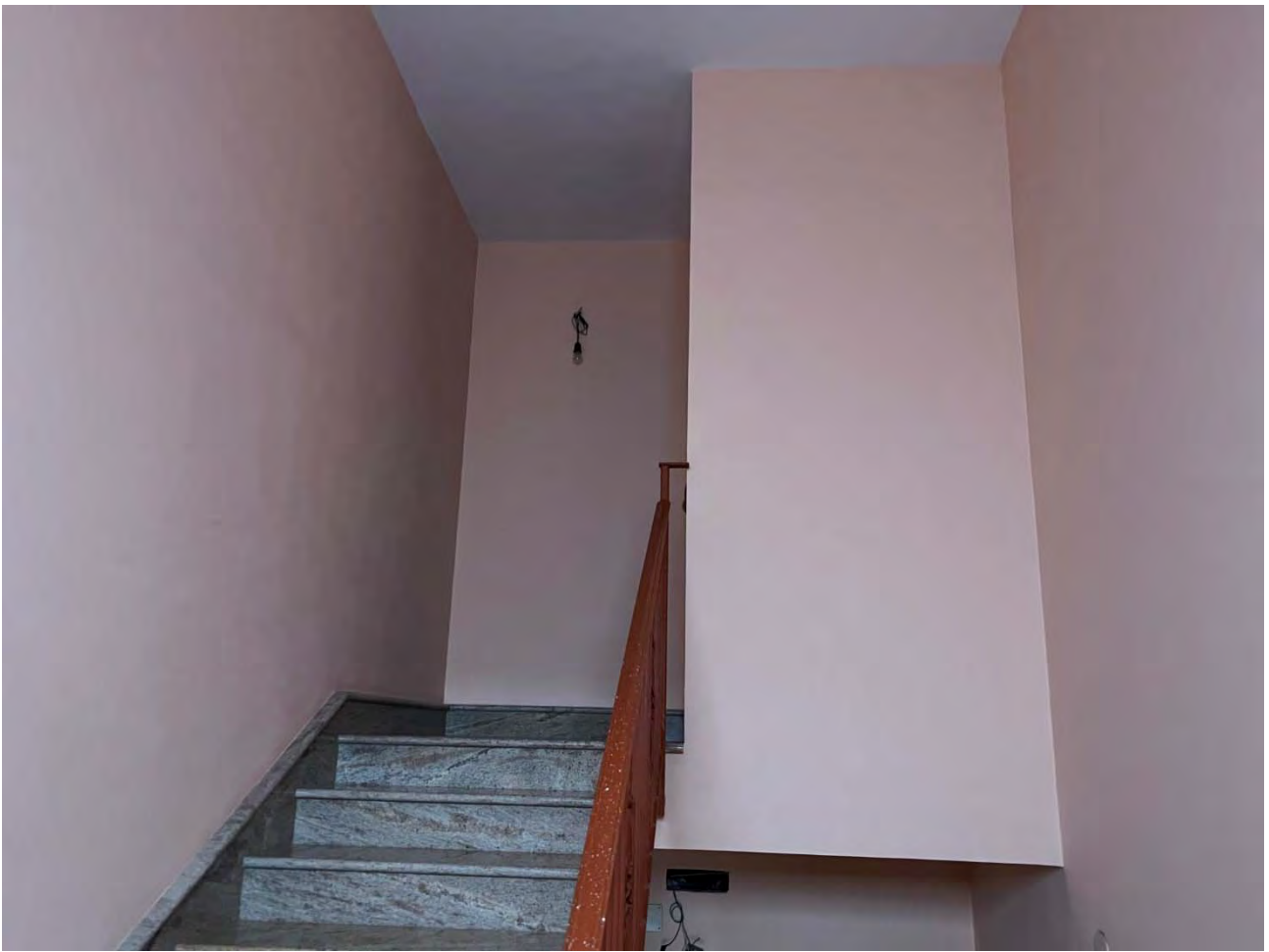
Foto 33 – Vista della scala che porta in copertura
