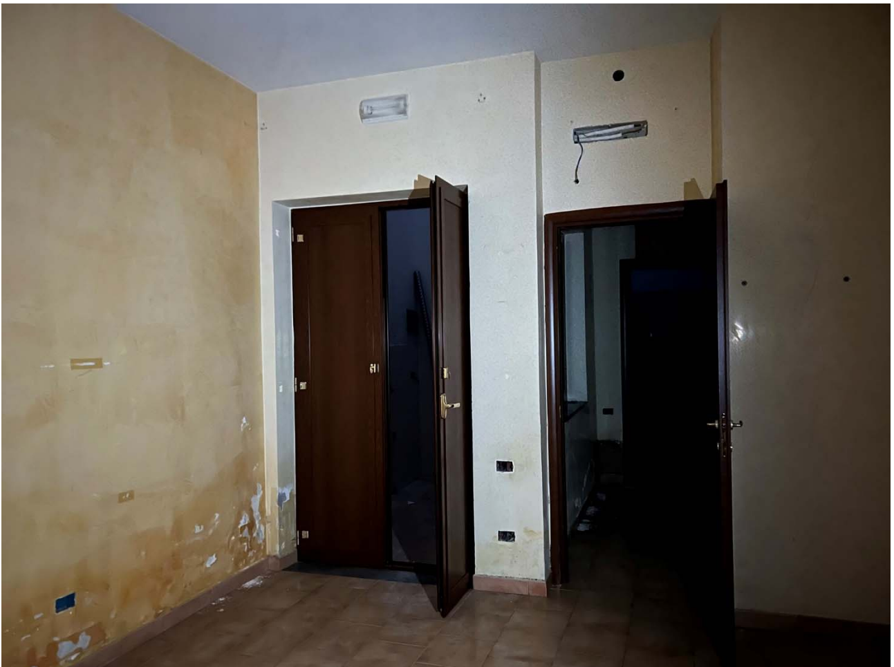
Foto 6 – Vista di uno degli ambienti dell'unità al piano terra (sub 2)
