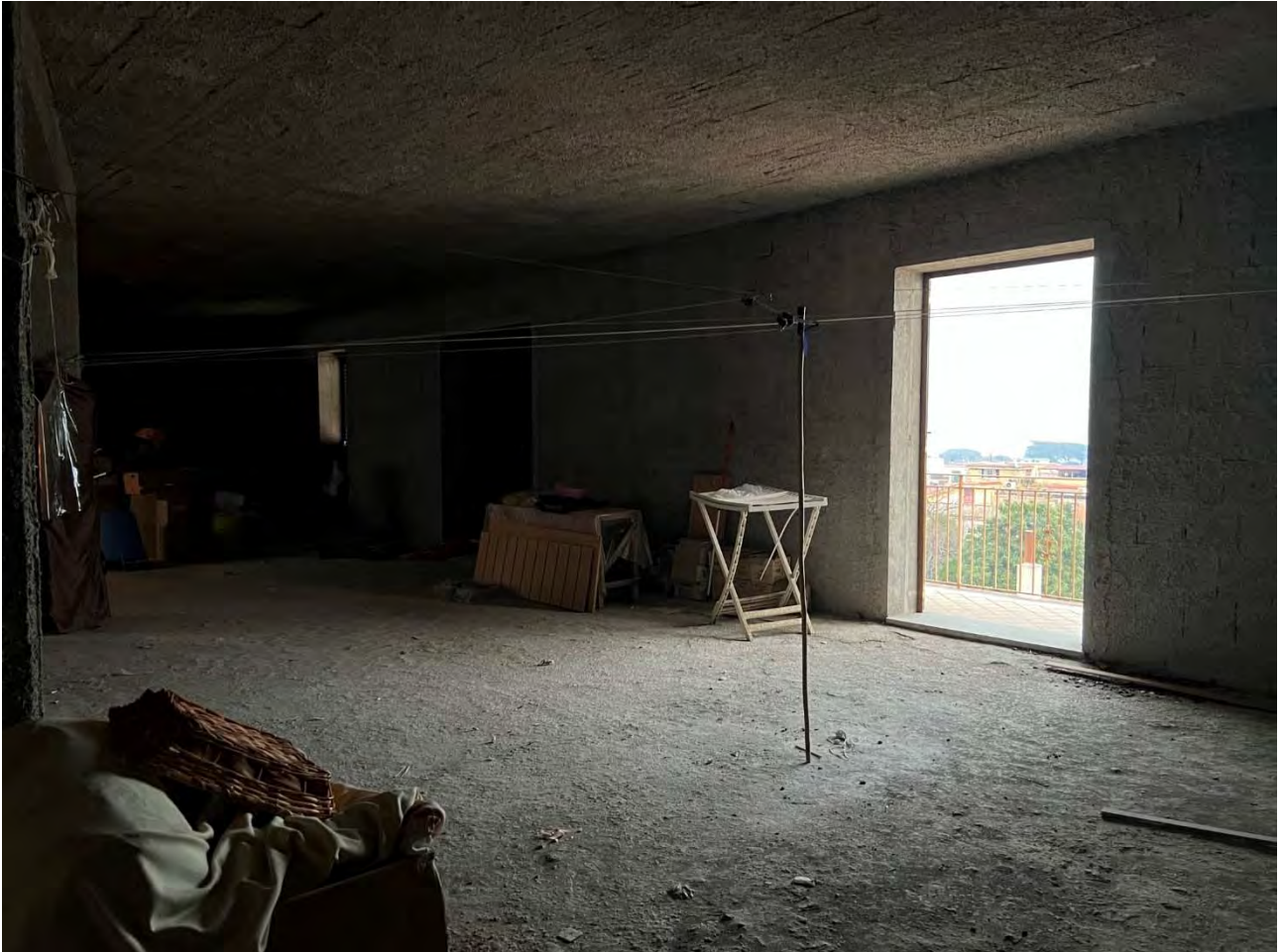
Foto 28 – Vista degli ambienti al piano secondo (sub 5)
