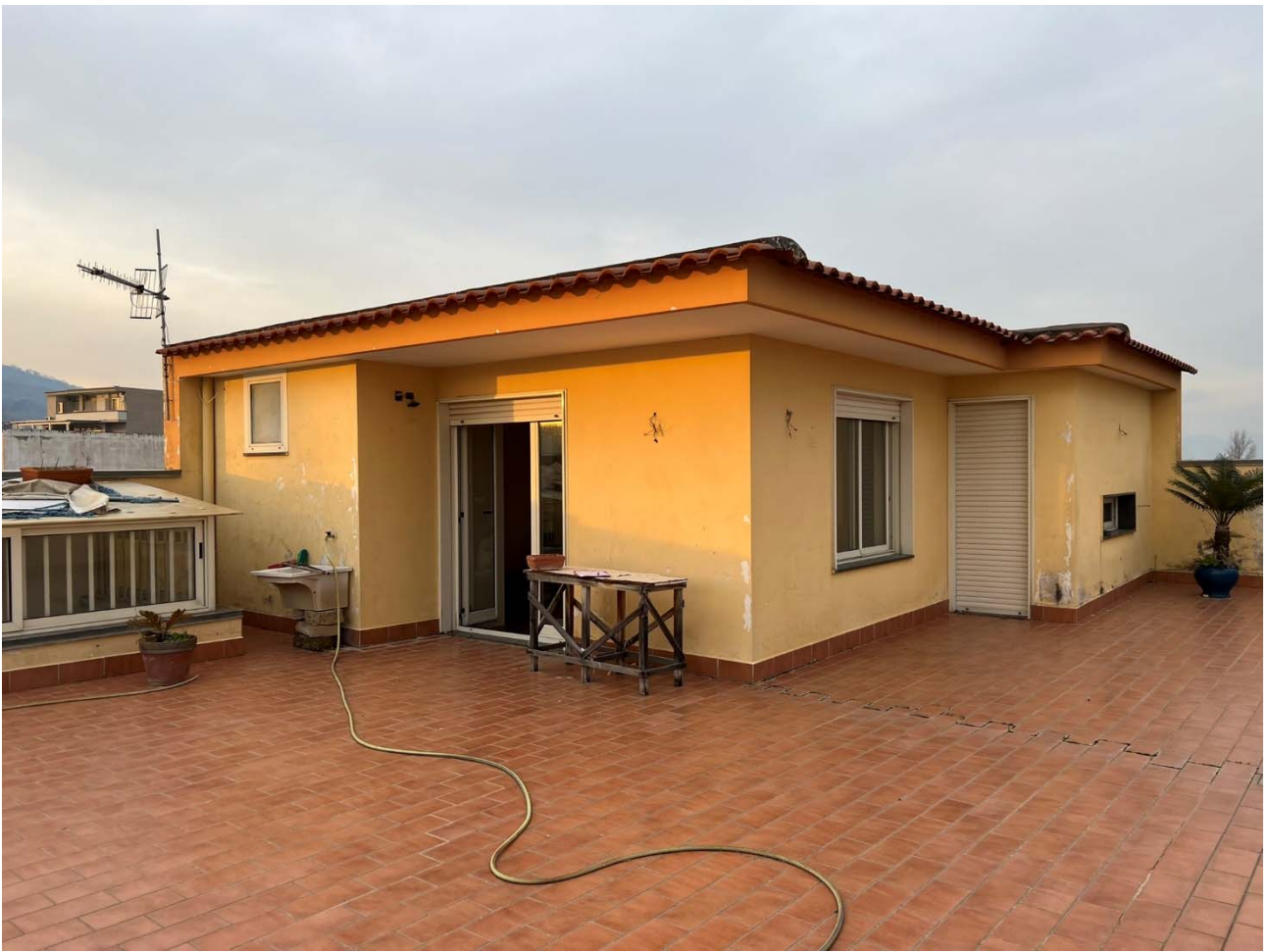
Foto 39 – Vista esterna dell'unità realizzata in copertura
