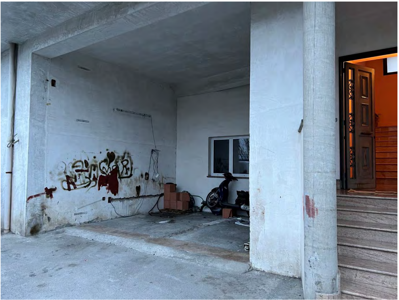
Foto 3 – Particolare del patio anteriore all'unità del piano terra (sub 3 – ex box auto)
