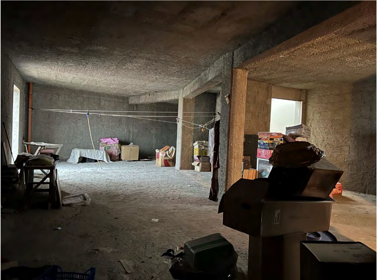
Foto 30 – Vista degli ambienti al piano secondo (sub 5)
