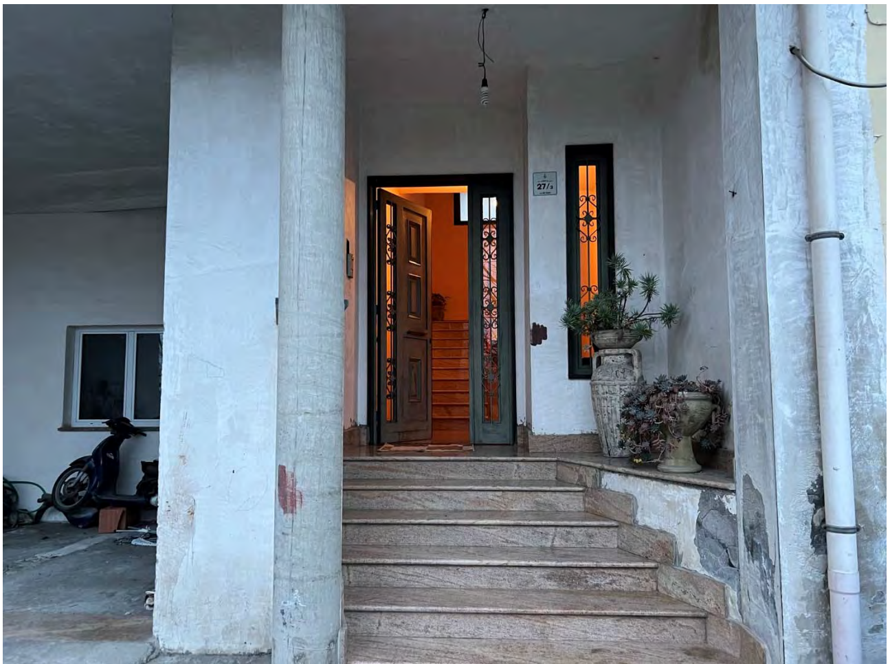
Foto 2 – Vista dell'ingresso principale al fabbricato
