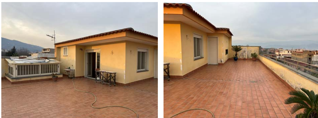
Vista esterna dell'unità al livello copertura (piano terzo) priva di identificativo catastale
