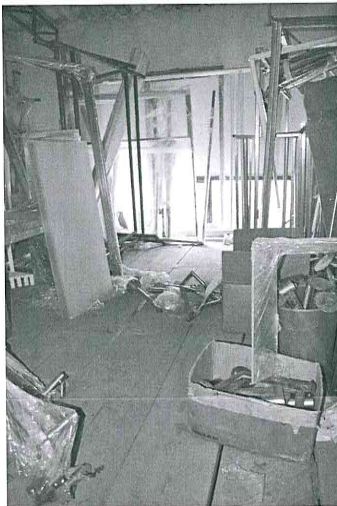
Foto 28 – Via del Vicano n. 15, Pelago (FI) – interno: area magazzino, il secondo soppalco.
