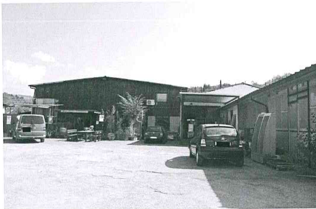
Foto 3 – Via del Vicano n. 15, Pelago (FI) – esterno: piazzale di fronte al capannone.
