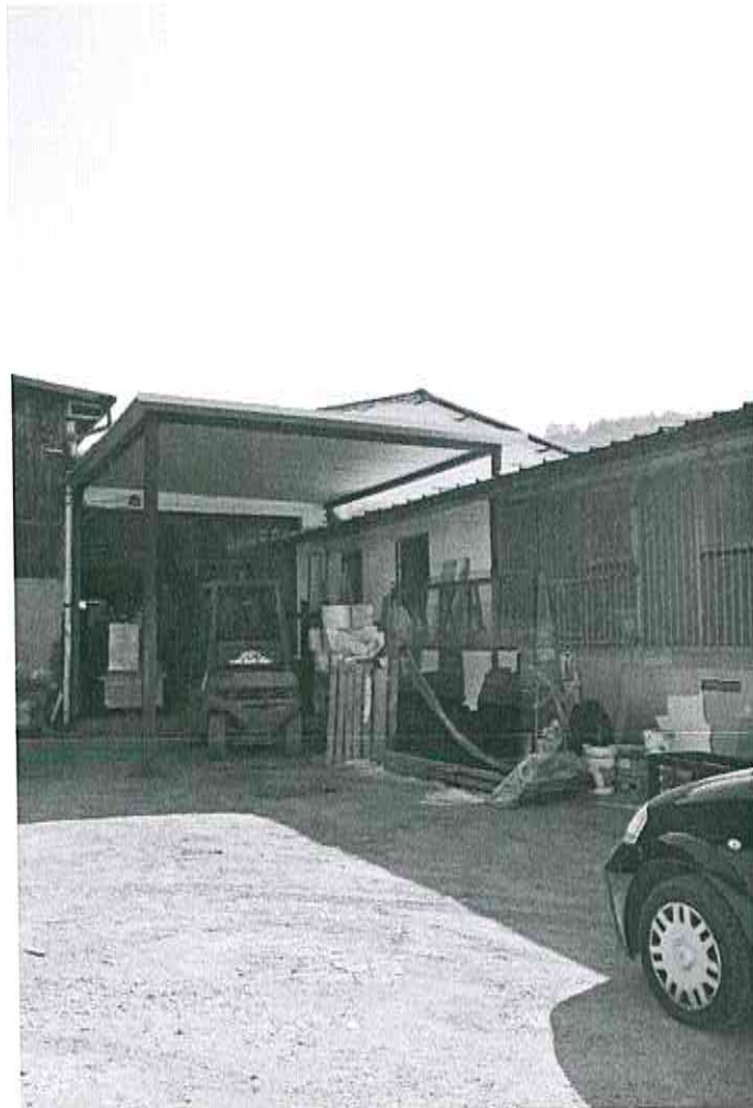
Foto 1 – Via del Vicano n. 15, Pelago (FI) – esterno: ingresso al capannone.
