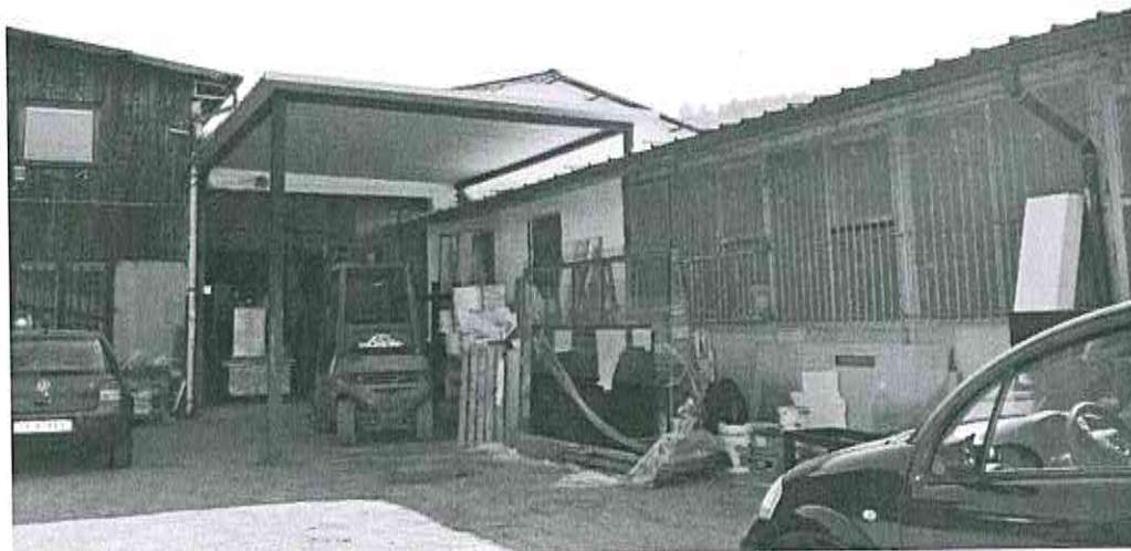
Foto 2 – Via del Vicano n. 15, Pelago (FI) – esterno: ingresso al capannone.
