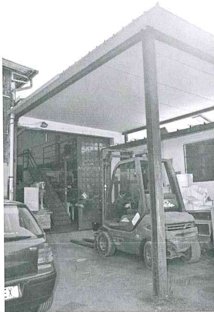
Foto 4 – Via del Vicano n. 15, Pelago (FI) – esterno: tettoia d'ingresso al capannone.
