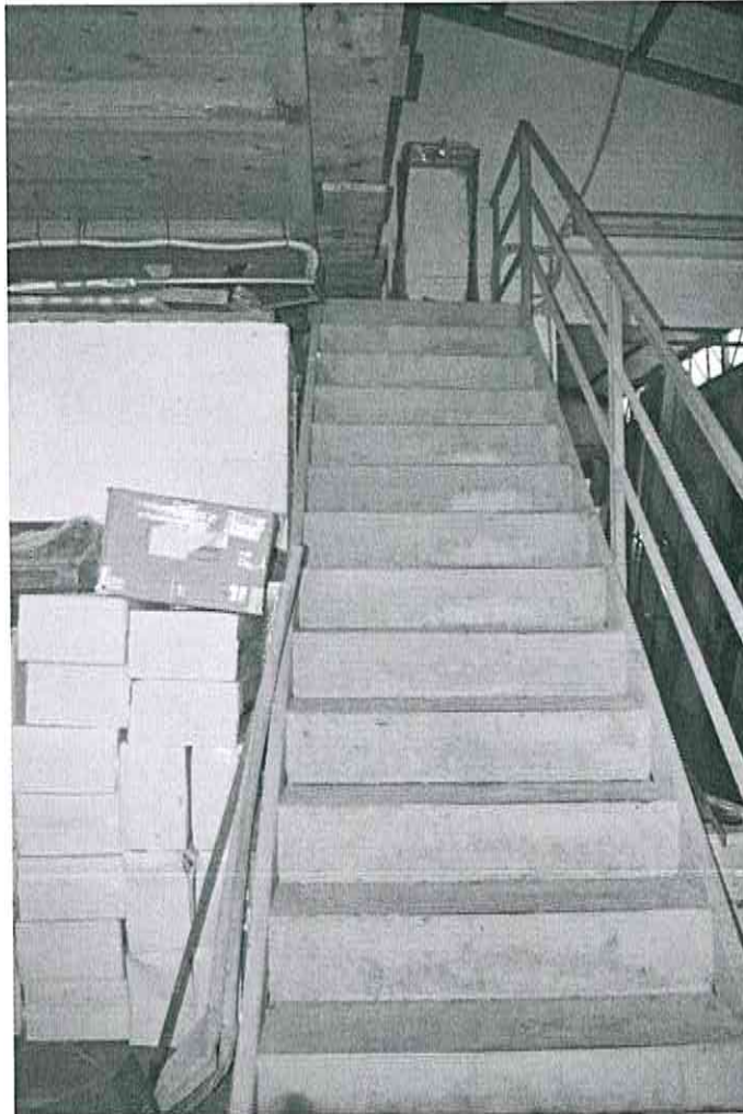
Foto 24 – Via del Vicano n. 15, Pelago (FI) – interno: area magazzino, scala di accesso al secondo soppalco.
