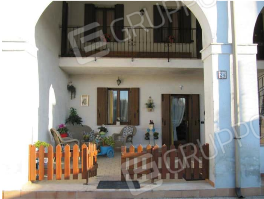
Facciata sud - accesso dal portico
