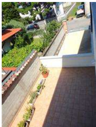
vista terrazzo scoperto piano terra/rialzato
