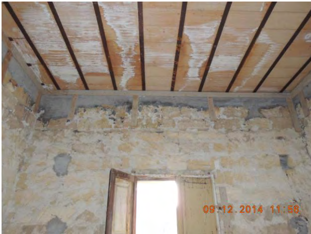
Foto n.13 – Solai e cordolo in c.a.
