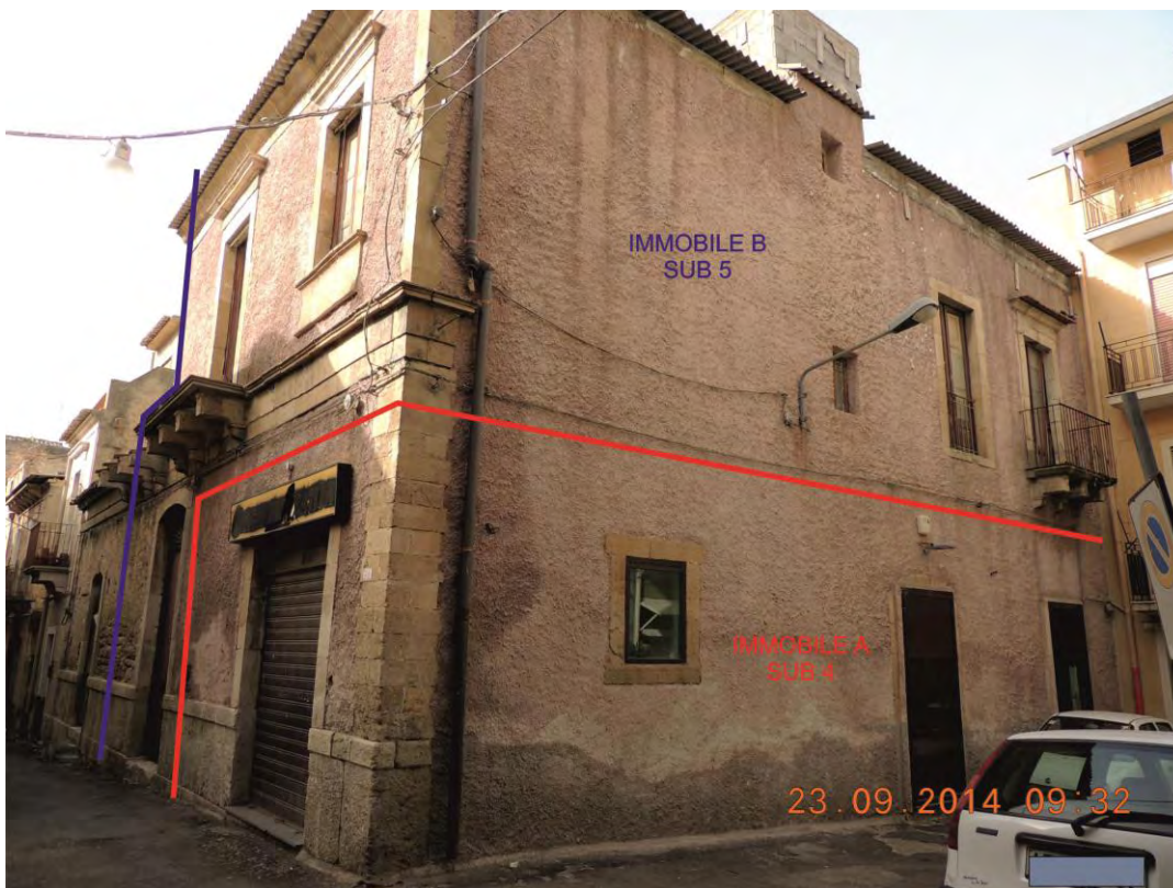
Foto n.1 – Immobile A e Immobile B
