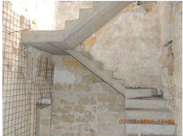
Foto n.14 – Scala in c.a.
