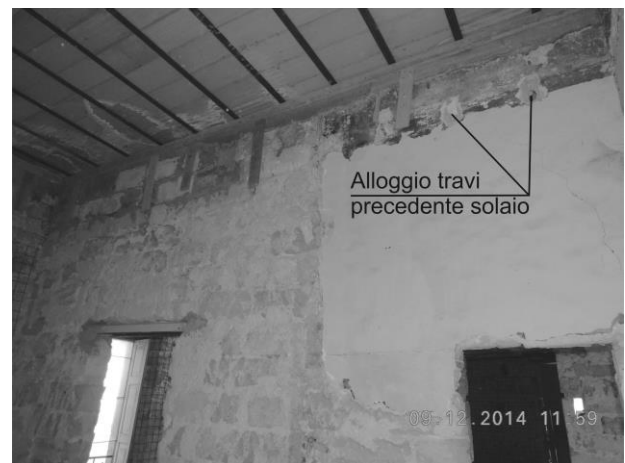
Solai di copertura - 2014
