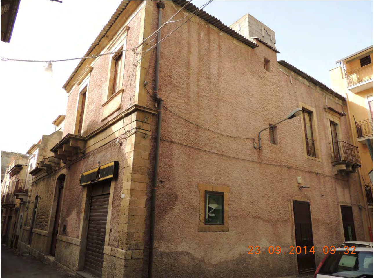
Foto n. 2 – Prospetti su Via Umbria e su Vicolo Cavour
