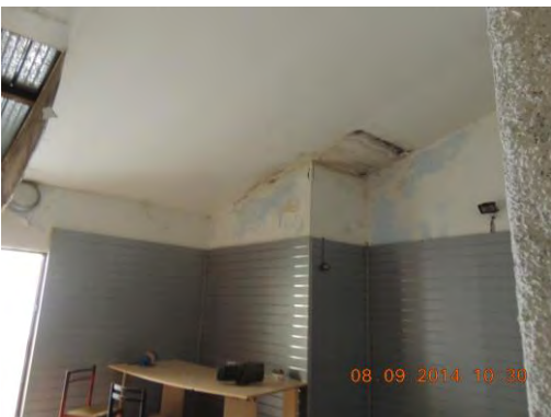
Foto n.8 – Intonaci ammalorati
