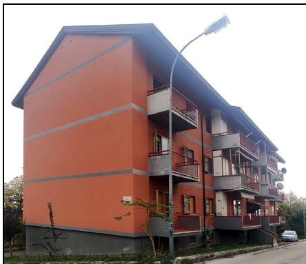
Vista del fabbricato da Via Sandro Pertini
