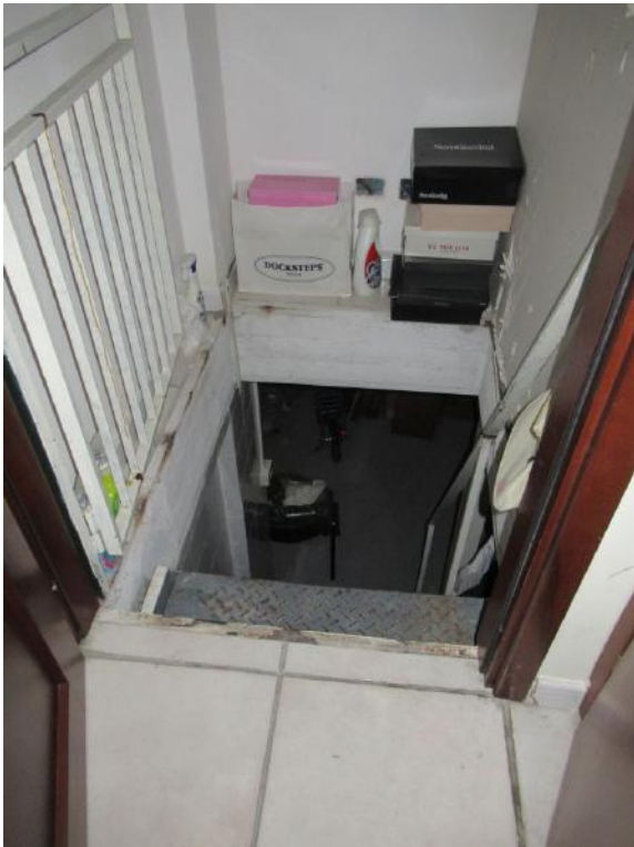
Foto 11 – Botola di accesso al Garage interrato Sub. 48
