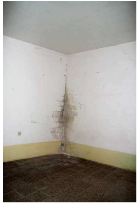
Vista camera piano primo
