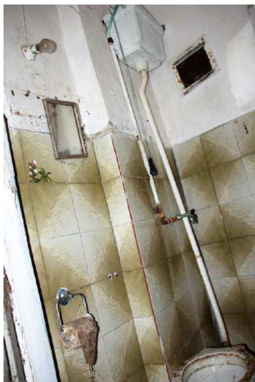
Vista w.c. piano terra
