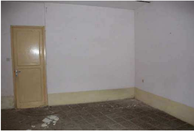
Vista camera piano primo
