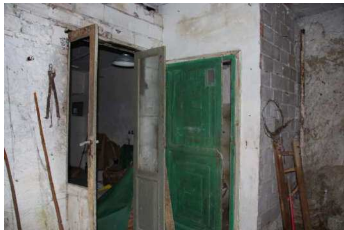
Vista vano interno piano terra
