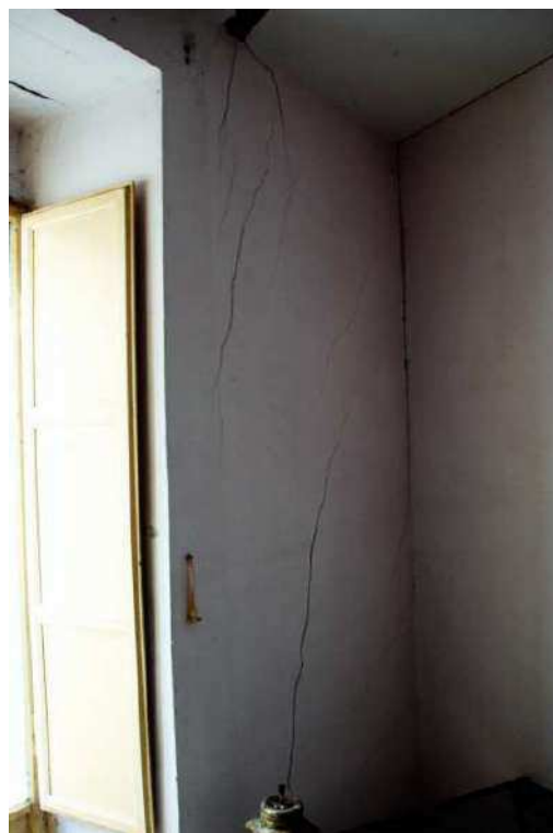
Vista camera piano primo
