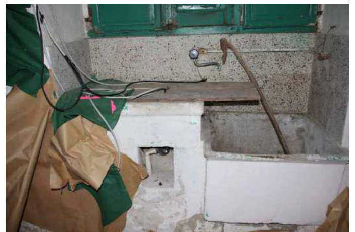
Vista primo vano piano terra-
