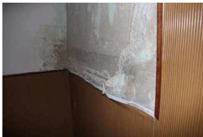
Vista disimpegno piano primo
