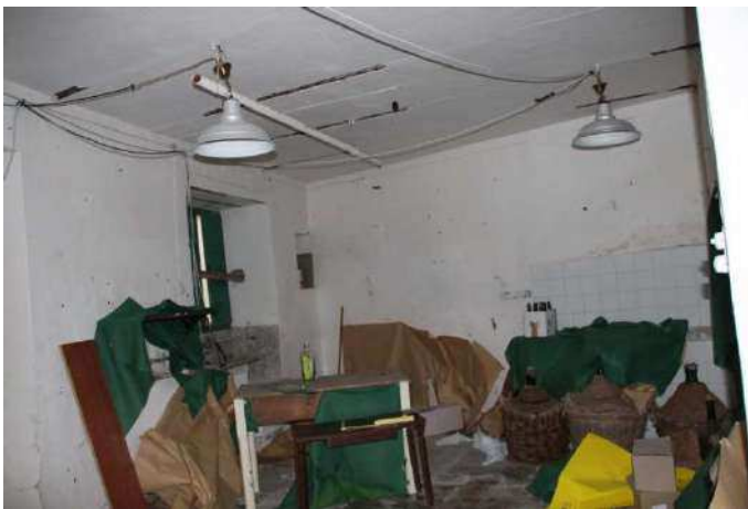
Vista primo vano piano terra
