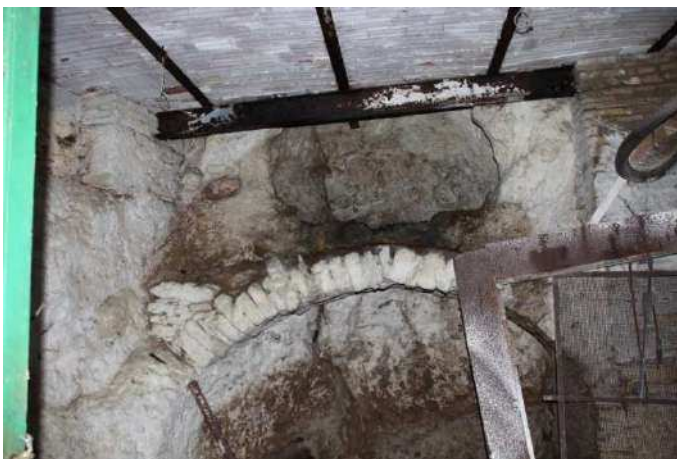
Vista vano interno piano terra
