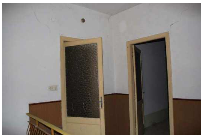
Vista disimpegno piano primo
