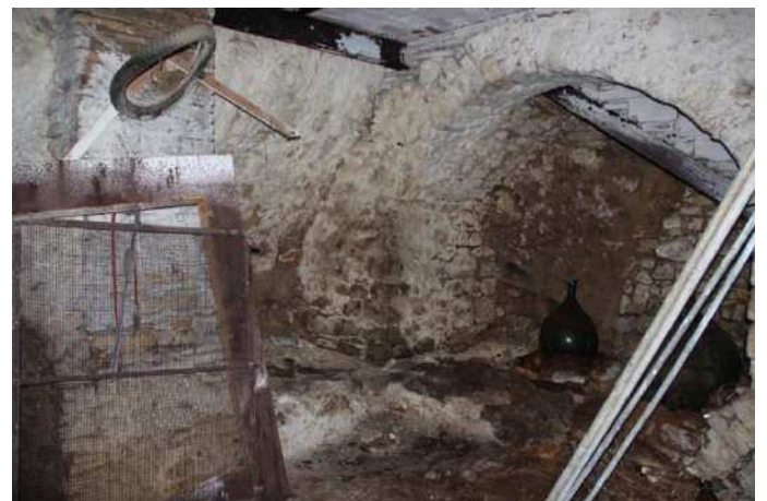
Vista vano interno piano terra
