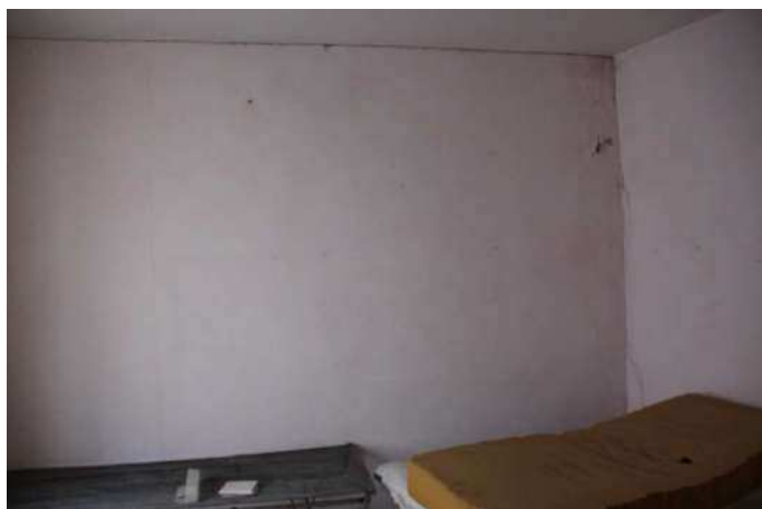
Vista camera piano primo
