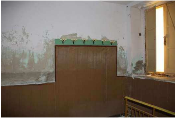
Vista disimpegno piano primo
