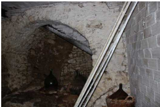
Vista vano interno piano terra
