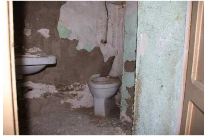
Vista w.c. piano primo
