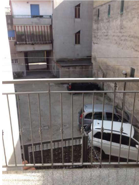
Foto da 9 a 18: Vista balconi ed infissi
