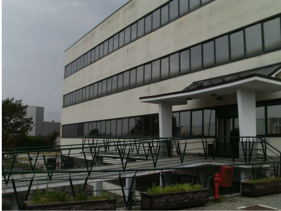
Figura 2 lato E ingresso
