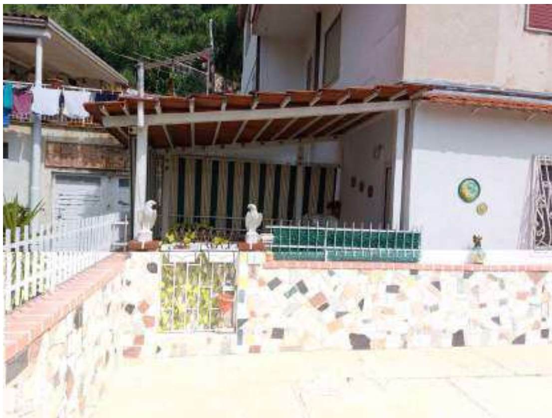
Foto N.4: Terrazzo coperto di pertinenza dell'appartamento oggetto di esecuzione Immobiliare sul prospetto Est.
