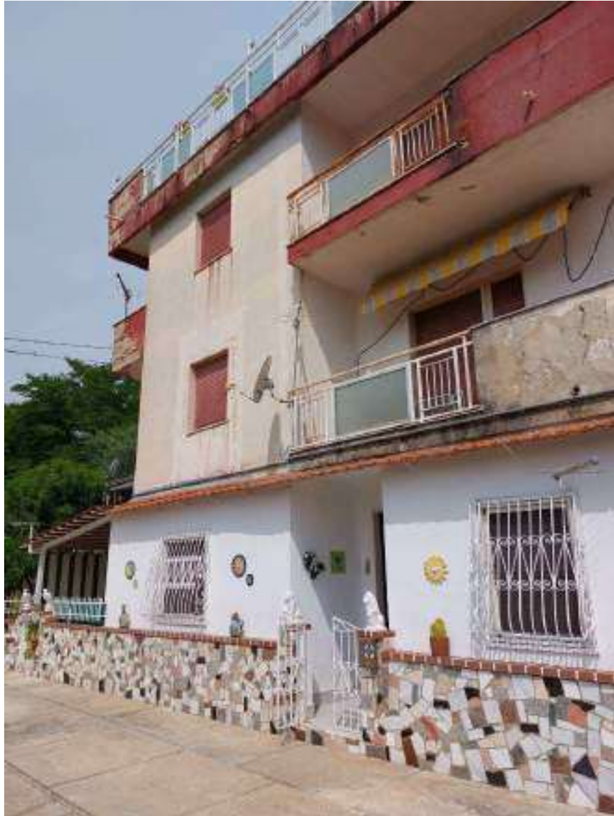
Foto N.2: Prospetto fabbricato Est con ingresso appartamento.
