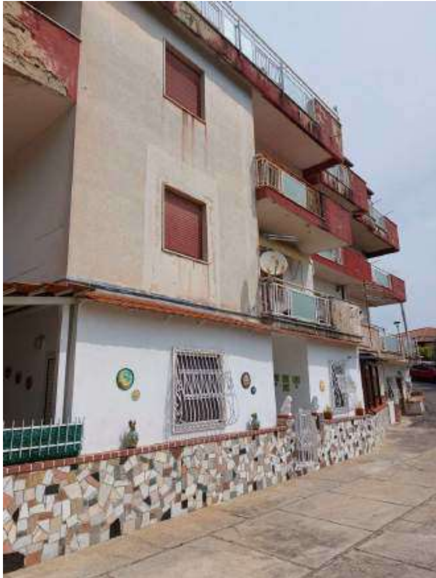
Foto N.1: Prospetto fabbricato Est con spazio esterno condominiale.
