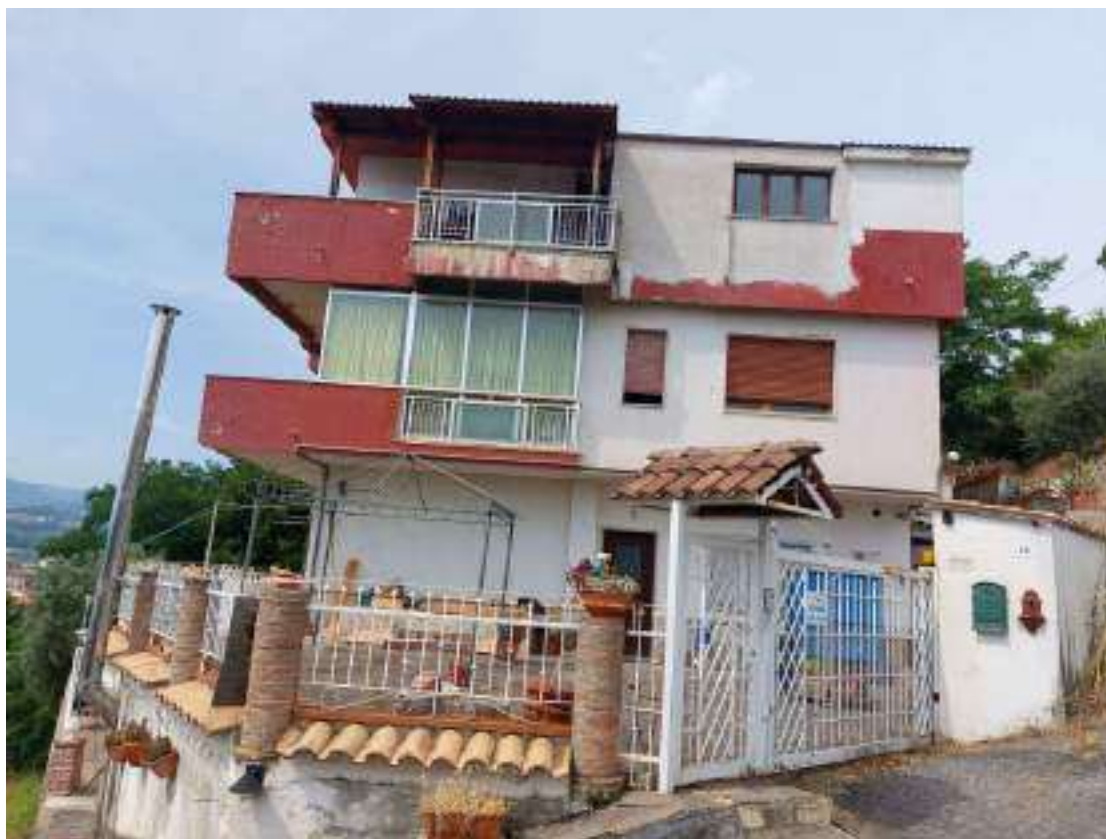
Foto N.3: Prospetto fabbricato Nord
