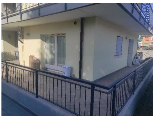
Fronte nord-est – Lastrico solare
