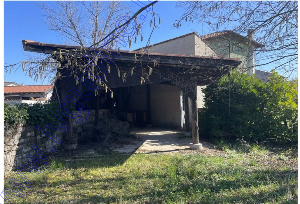
Ripostiglio su ingresso
