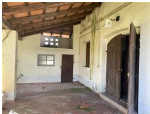
Porticato con deposito
