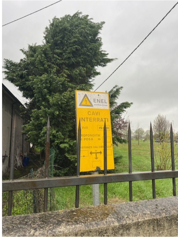
FOTOGRAFIA 7: CARTELLO DI ATTENZIONE PER CAVI INTERRATI NEL LOTTO 1
