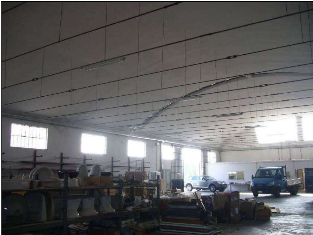
Fotografia 26 – Vista interno magazzino
