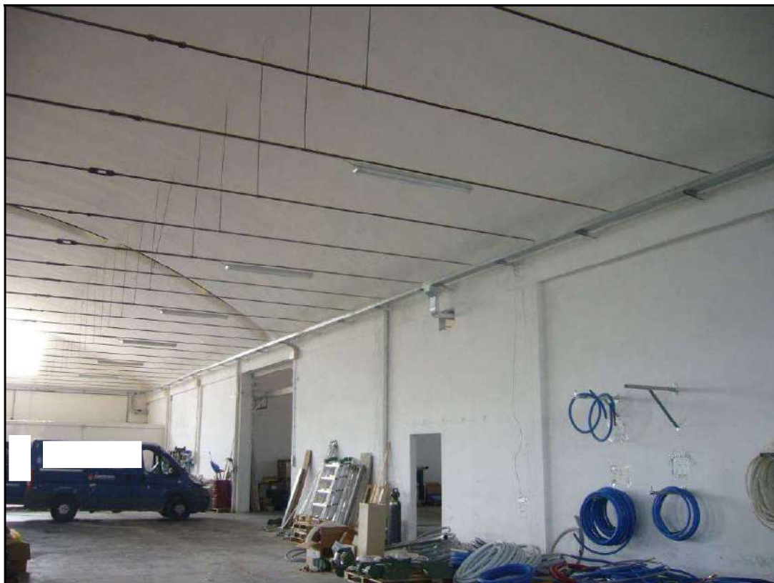
Fotografia 29- Vista interno magazzino
