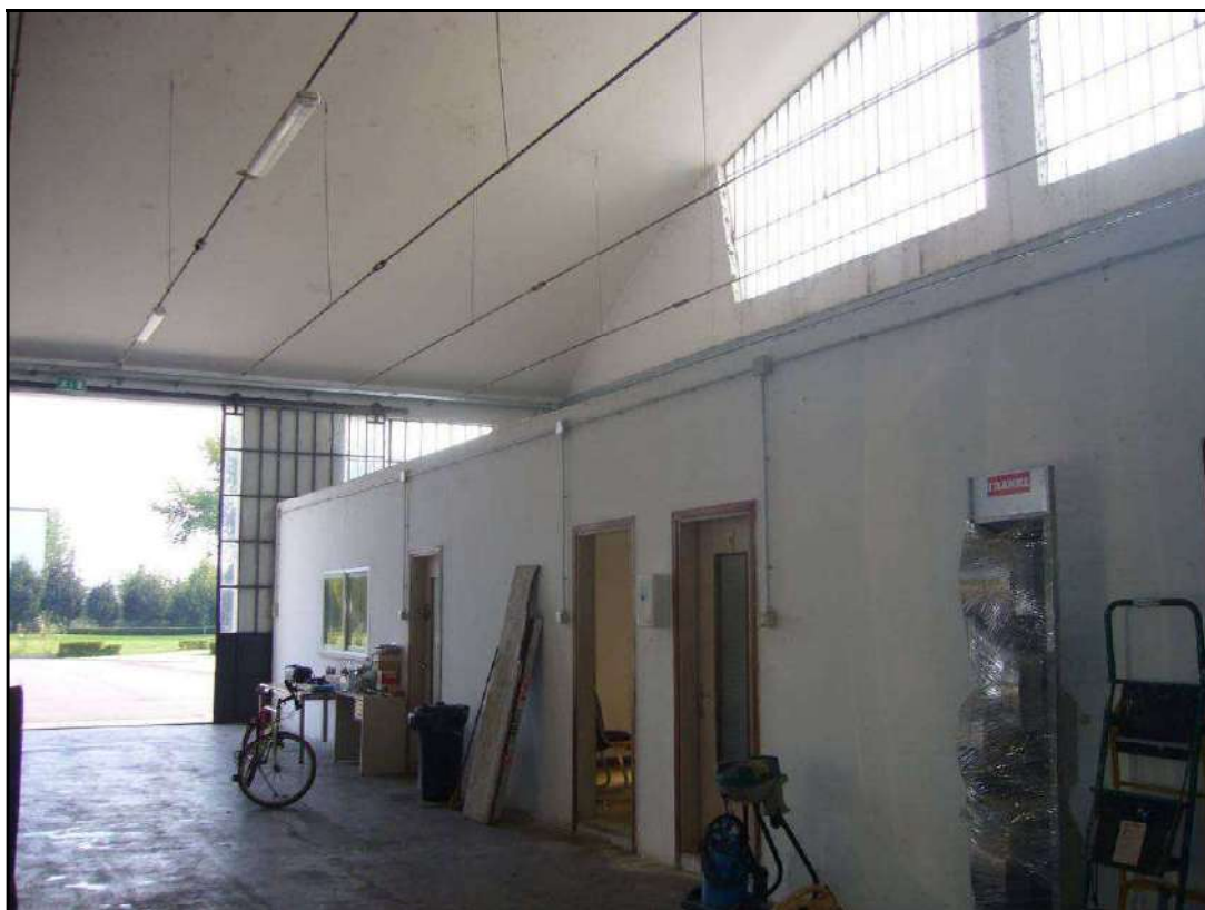
Fotografia 24 – Vista interno magazzino e locali ufficio bagno e ripostiglio
