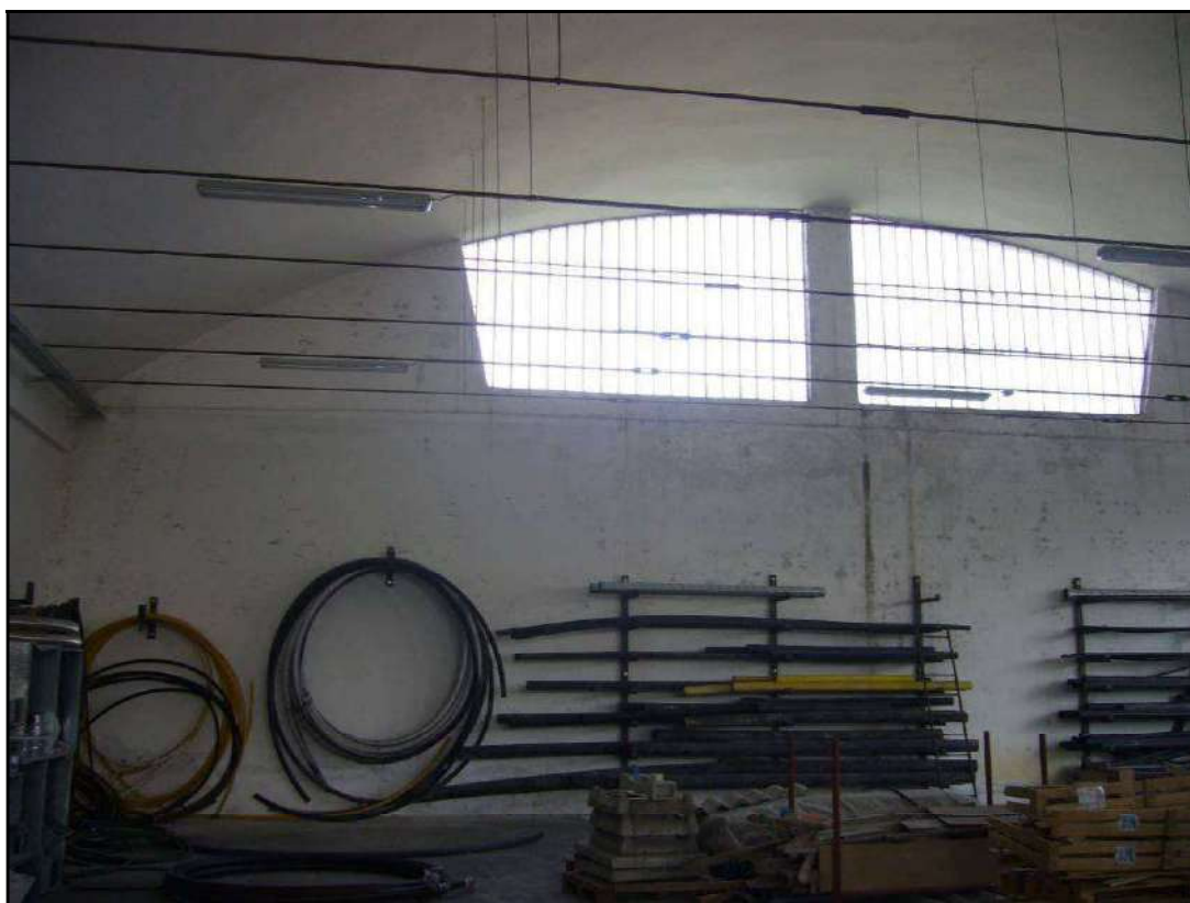
Fotografia 28 – Vista interno magazzino
