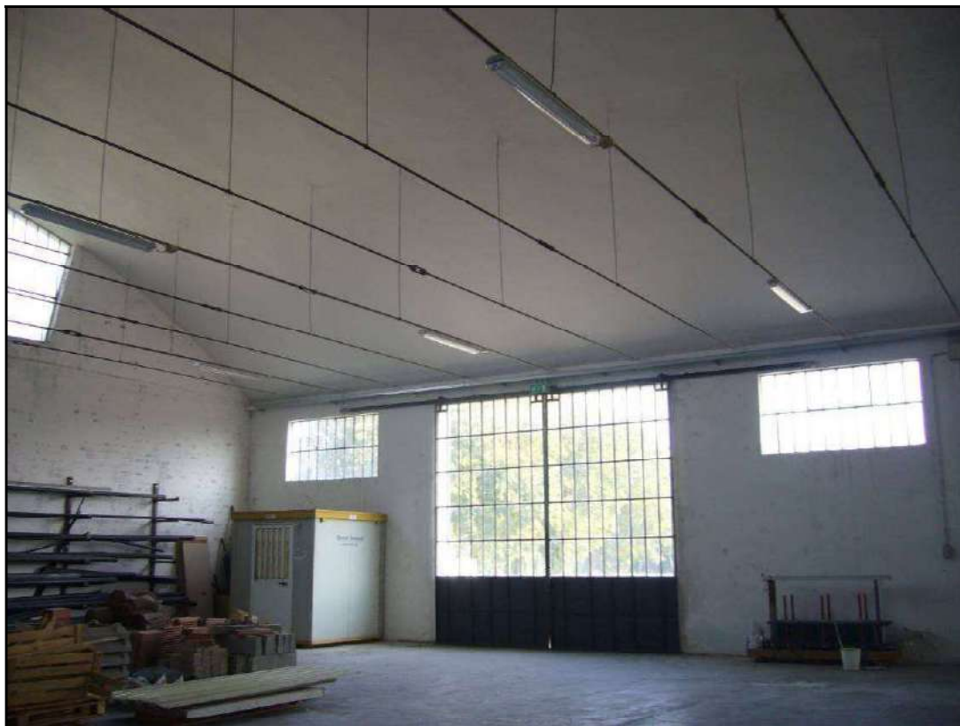
Fotografia 27 – Vista interno magazzino
