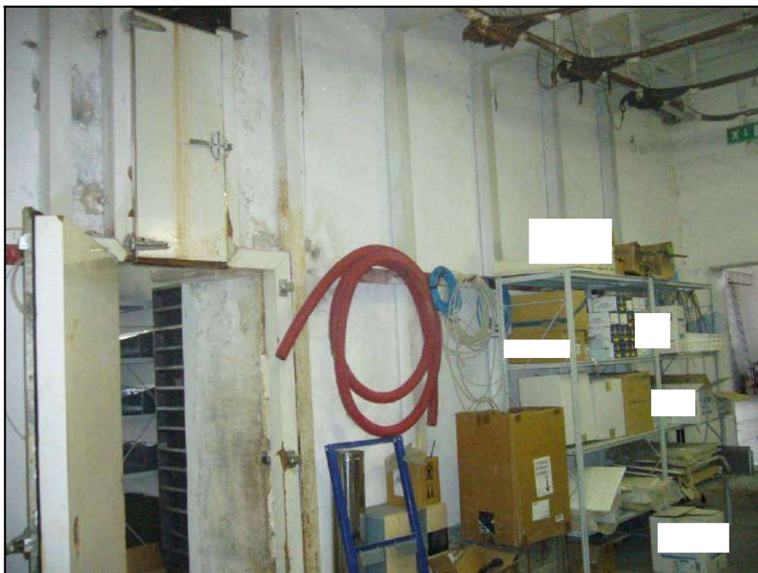
Fotografia 36- Vista magazzino ex locale cella
