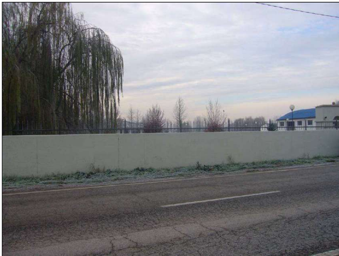
Fotografia 2 – Fronte esterno proprietà dalla pubblica via Parolara
