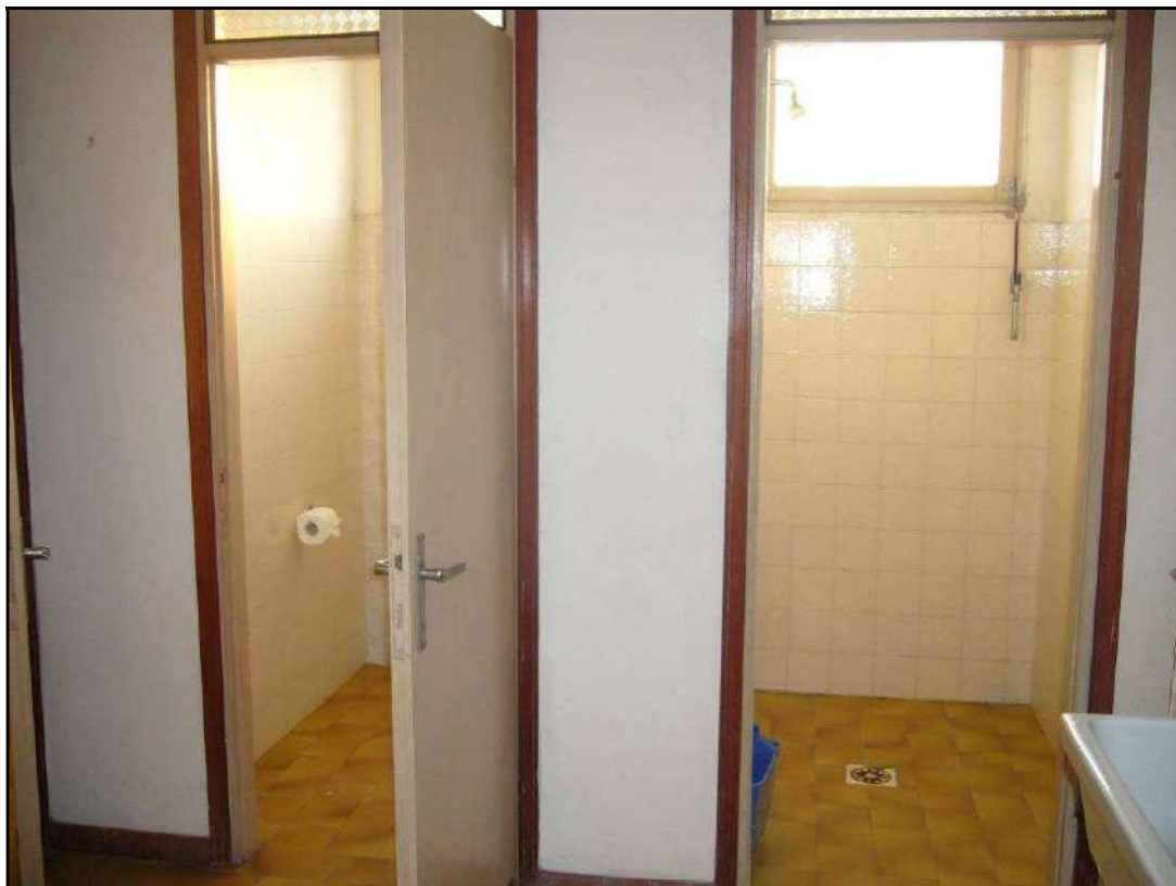
Fotografia 47- Vista bagno uomini
