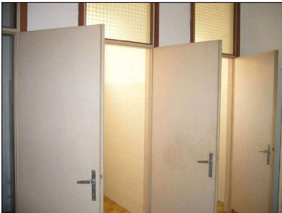
Fotografia 48- Vista locale bagno donne
