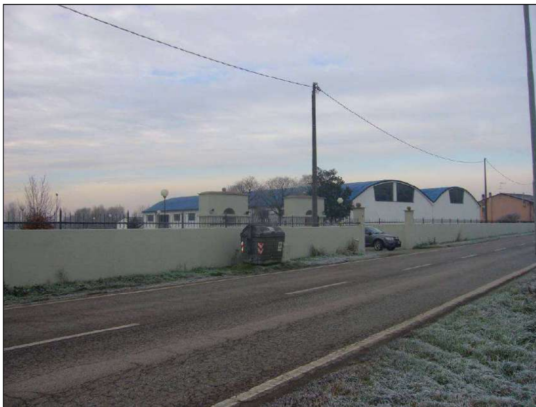
Fotografia 1 – Fronte esterno proprietà dalla pubblica via Parolara
