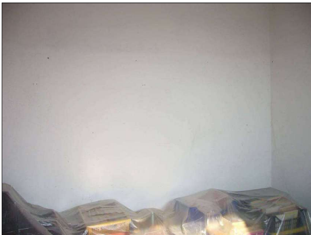
Fotografia 46- Vista ripostiglio ex locale tripperia
