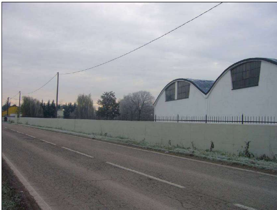
Fotografia 3 – Fronte esterno proprietà dalla pubblica via Parolara
