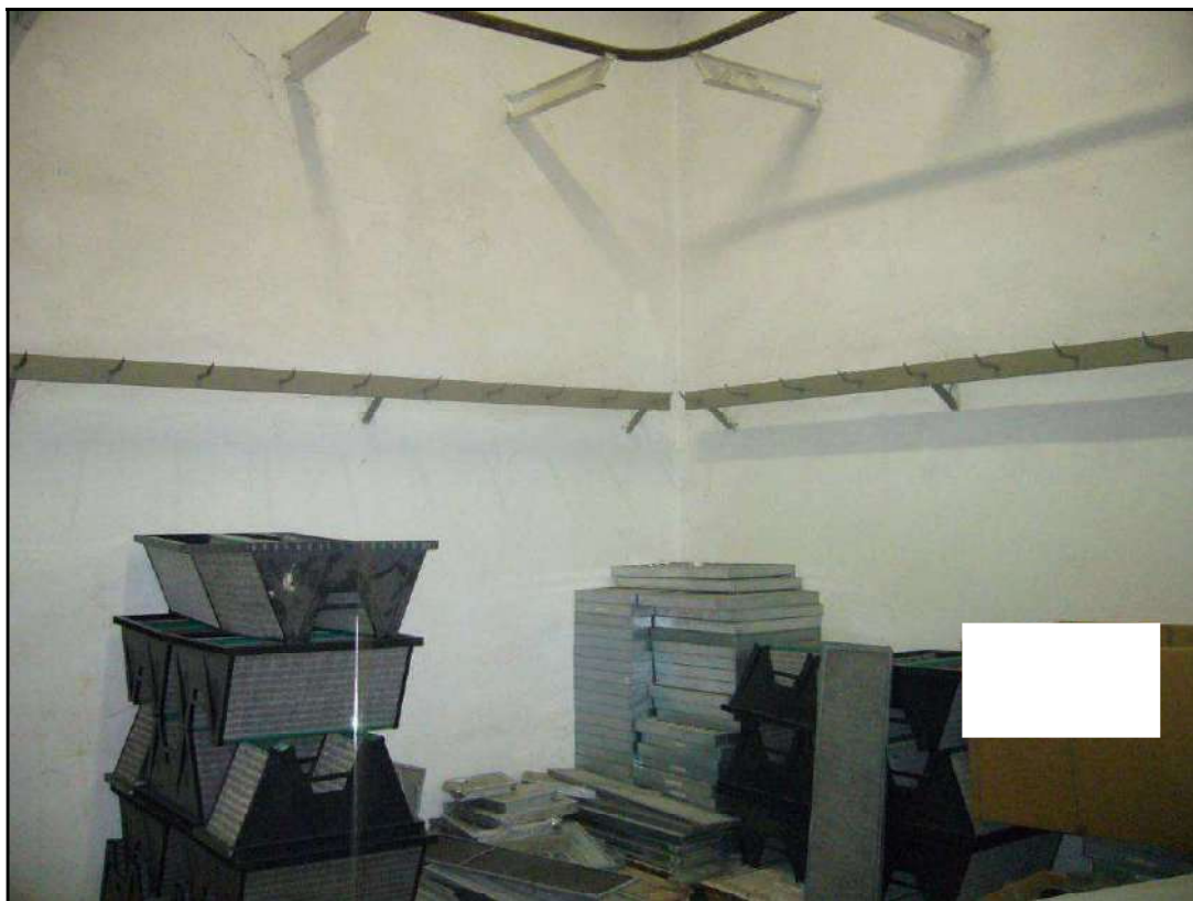
Fotografia 35- Vista locale ex soggiorno piano secondo
