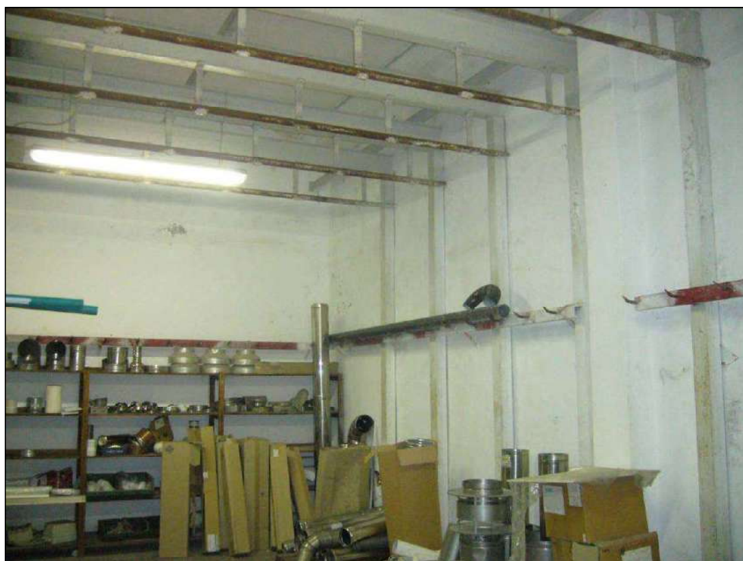
Fotografia 38- Vista magazzino ex locale cella
