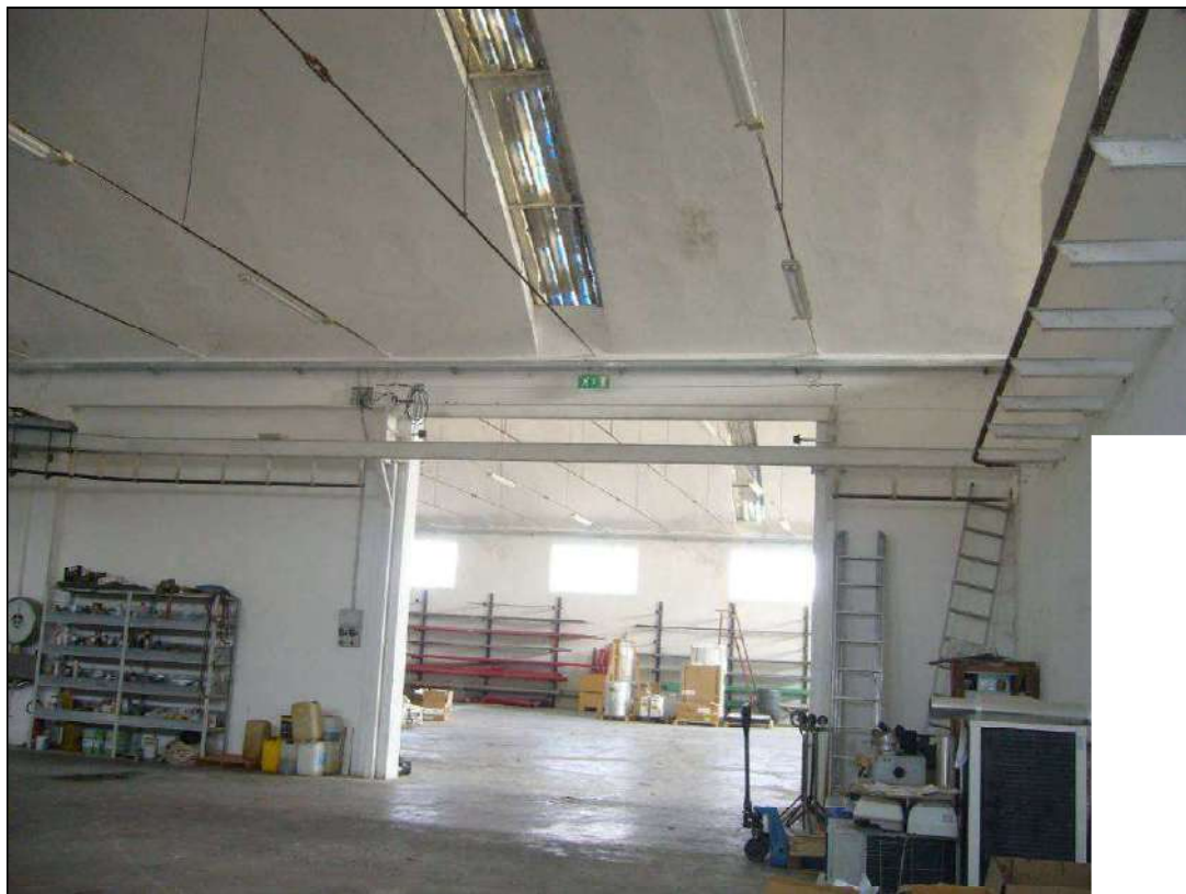
Fotografia 41- Vista magazzino ex locale strancio
