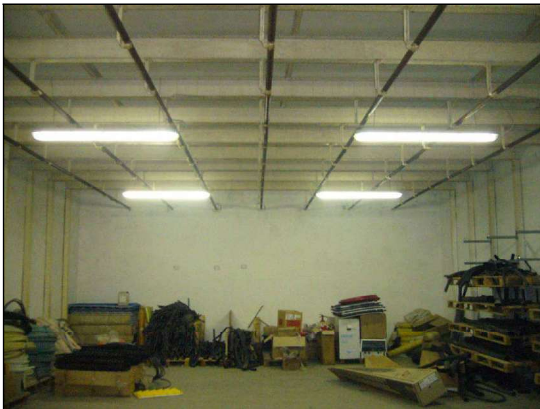
Fotografia 32 – Vista magazzino ex locale cella
