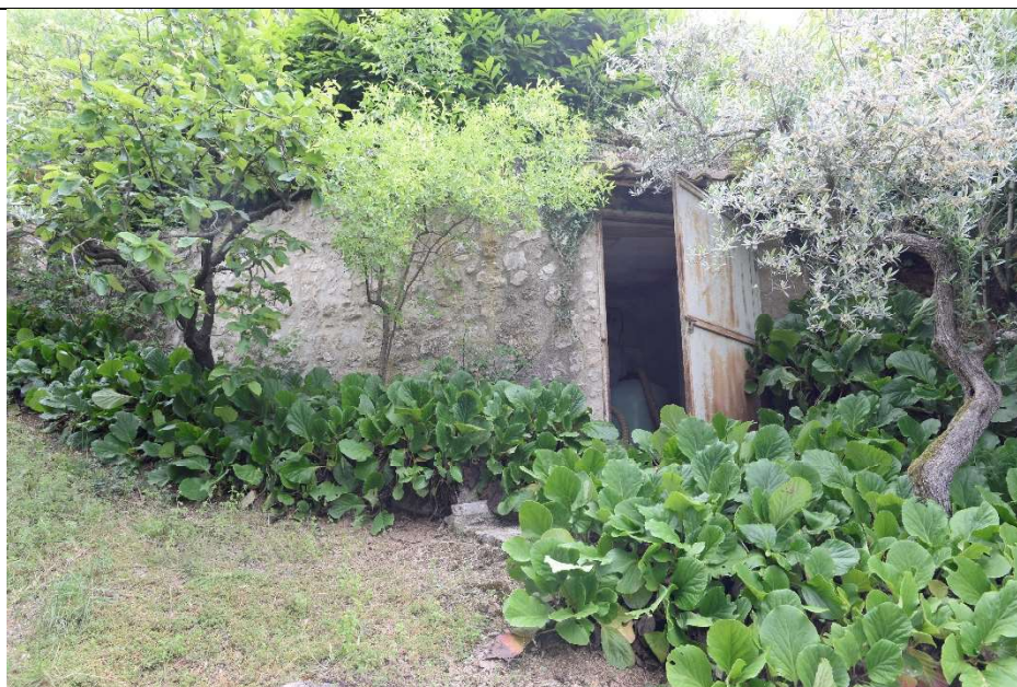
Esterno locale tecnico
