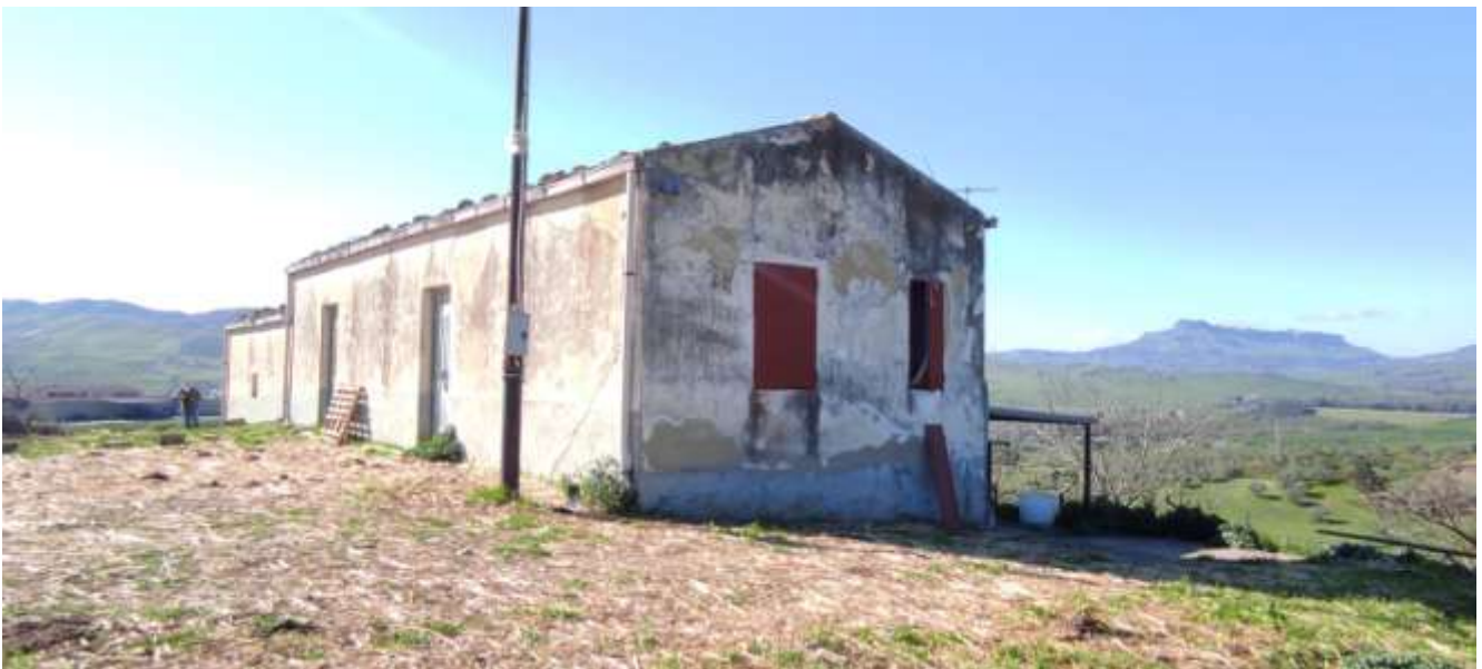
foto n.8 - fabbricato (foglio 51, mappale 90)
