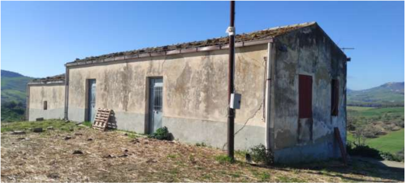
foto n.7 - fabbricato (foglio 51, mappale 90)
