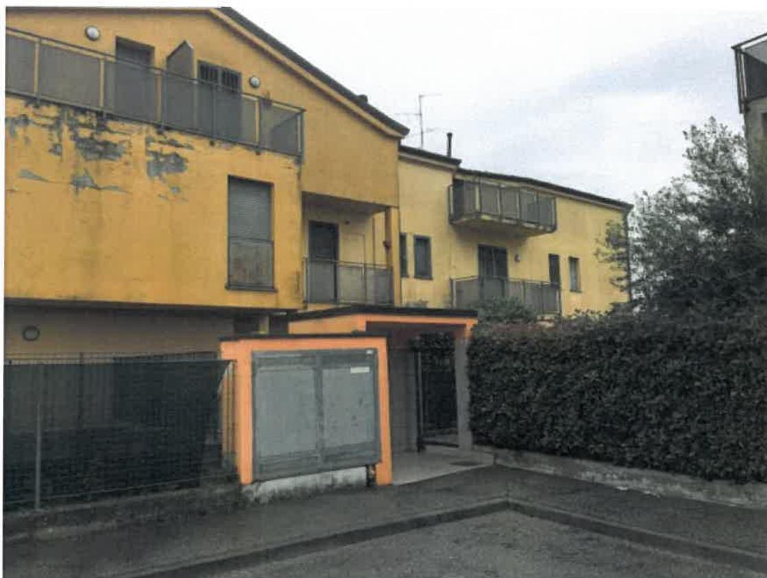
Foto 05 - Accesso al fabbricato dal civico 12 di via Sondrio
