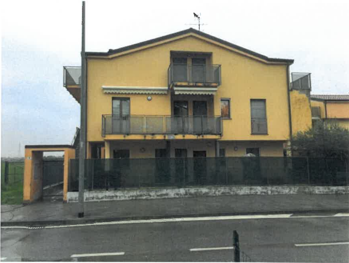
Foto 01 - Il fabbricato su via Sondrio
