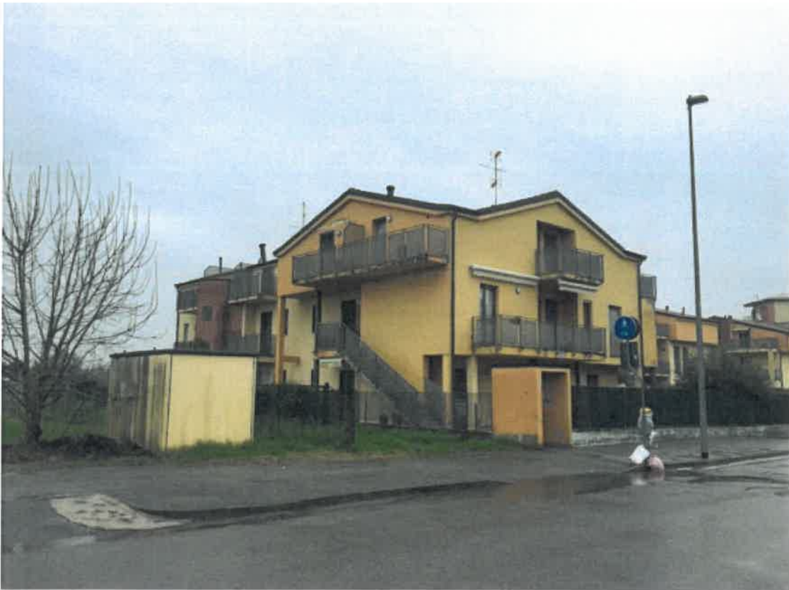
Foto 02 - Il fabbricato su via Sondrio
