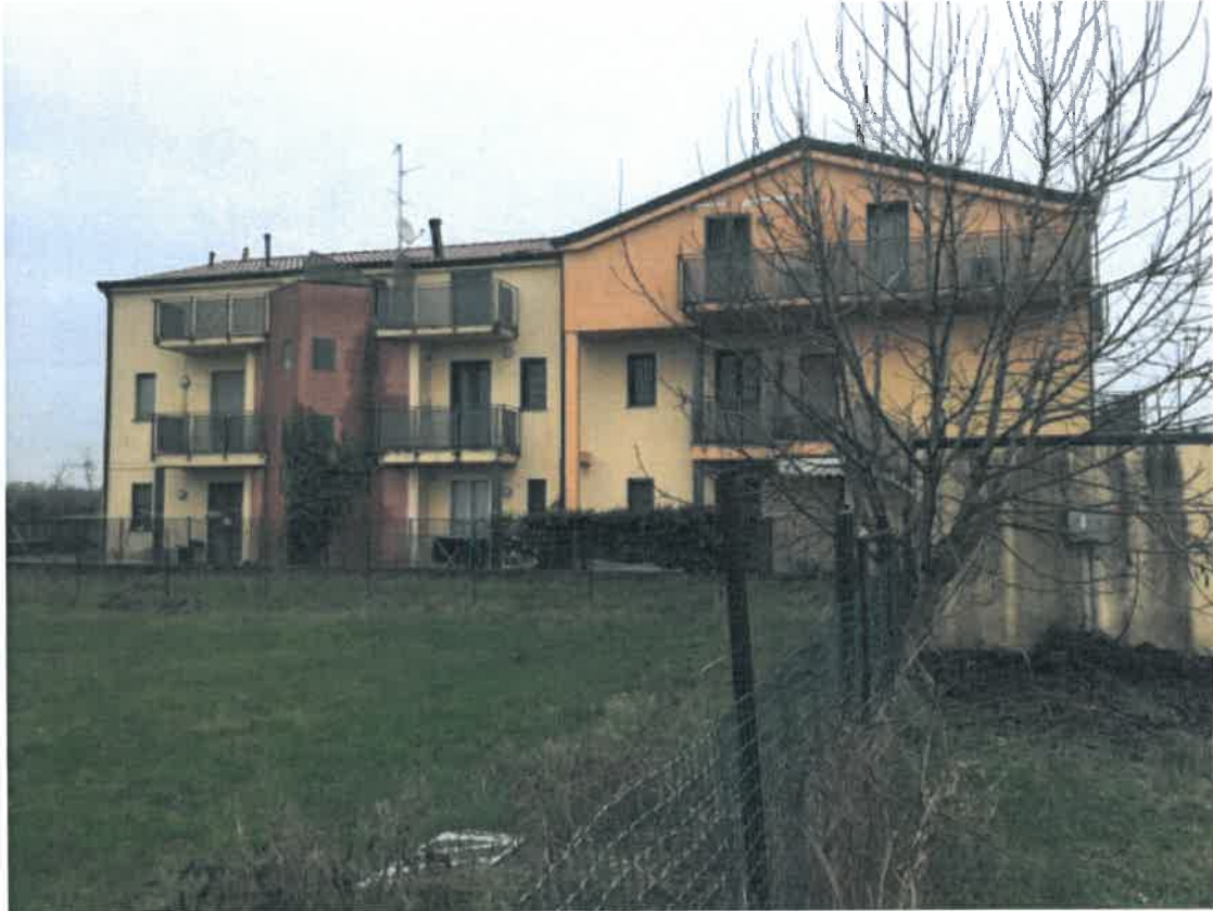
Foto 03 - Il fabbricato sul retro
