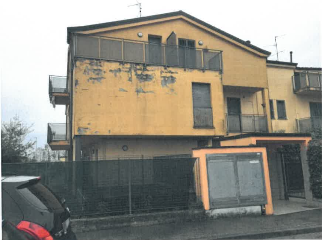
Foto 04 - Il fabbricato su via Sondrio 12
