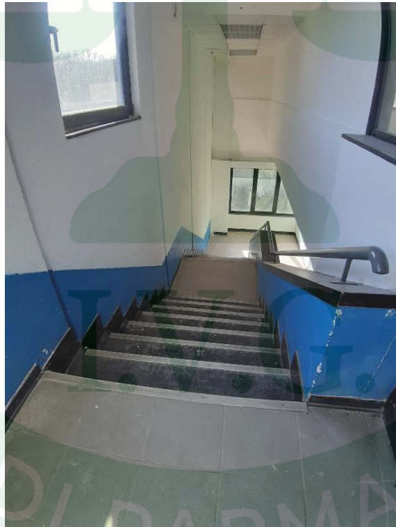
FOTO 18 (Piano primo - vista scale accesso al piano Primo)
