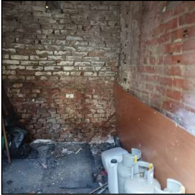
Foto 14 - ripostiglio esterno l'abitazione
