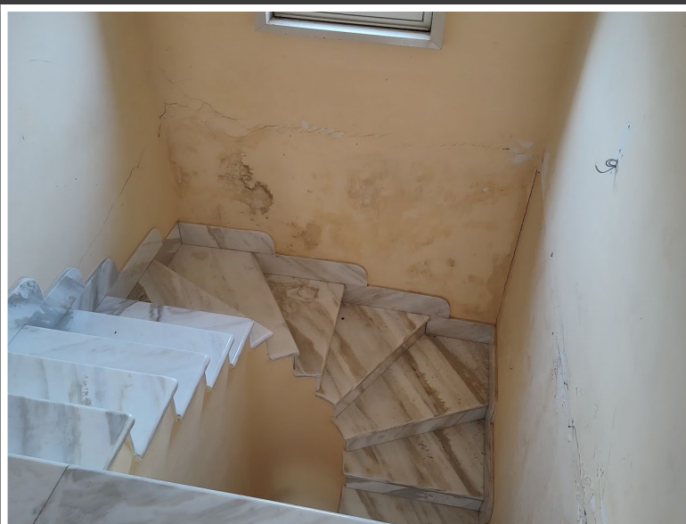
Foto n. 6 – scala di accesso piano superiore
