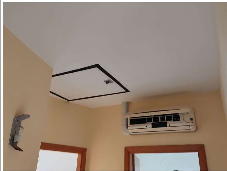
Foto n. 11 – botola accesso vano tecnico
