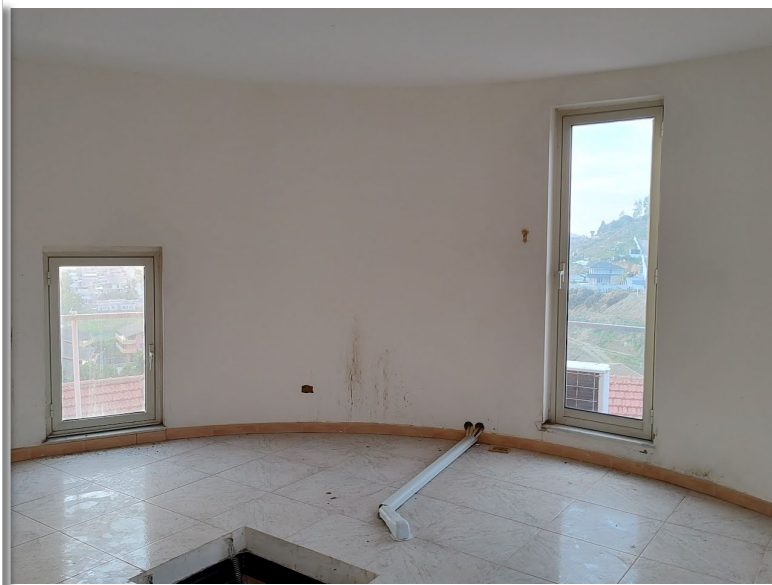
Foto n. 12 – vano tecnico soprastante
