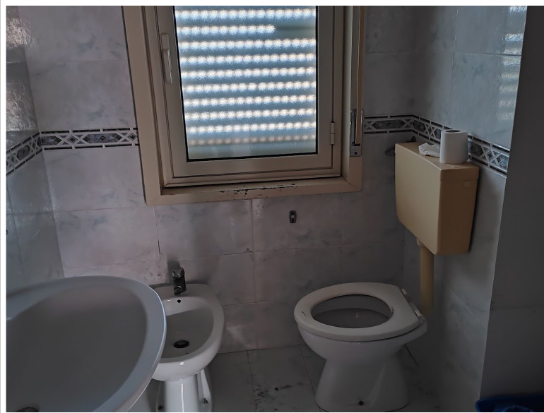
Foto n. 4 – bagno al piano
