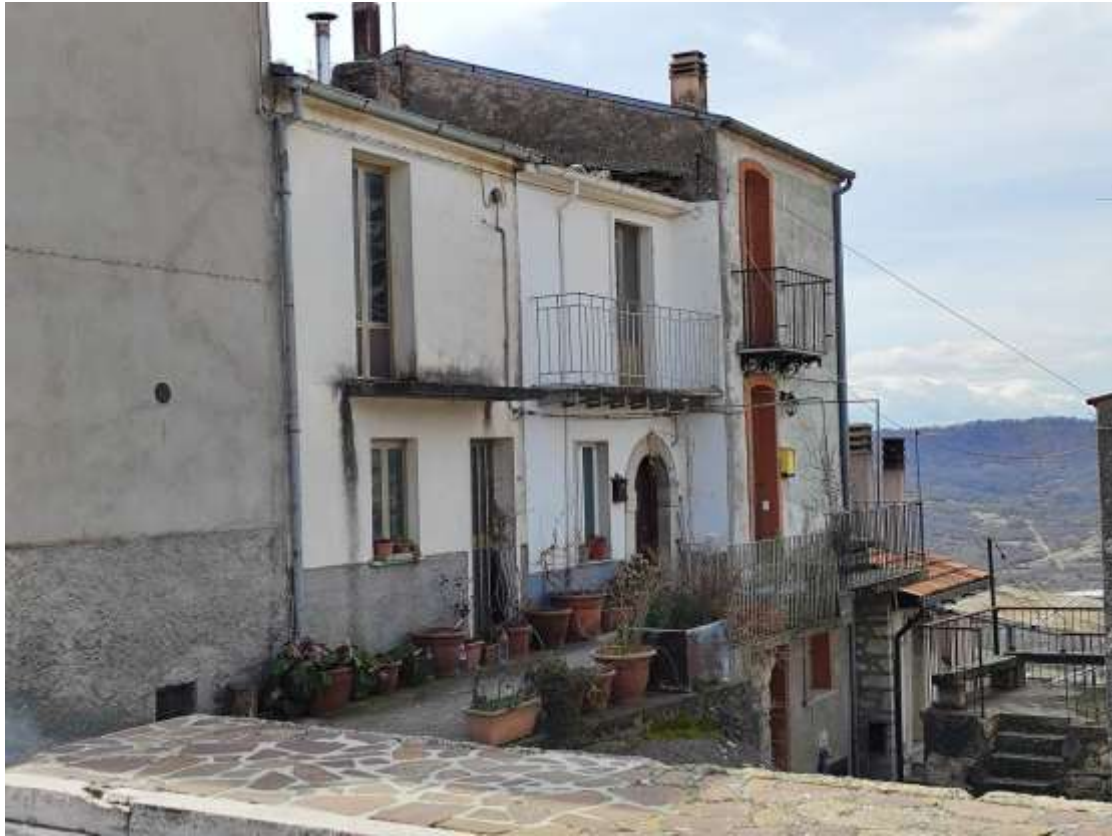
Foto 3 - Fabbricato Foglio 38 P.Ila 647 visto da Via della Madonna
