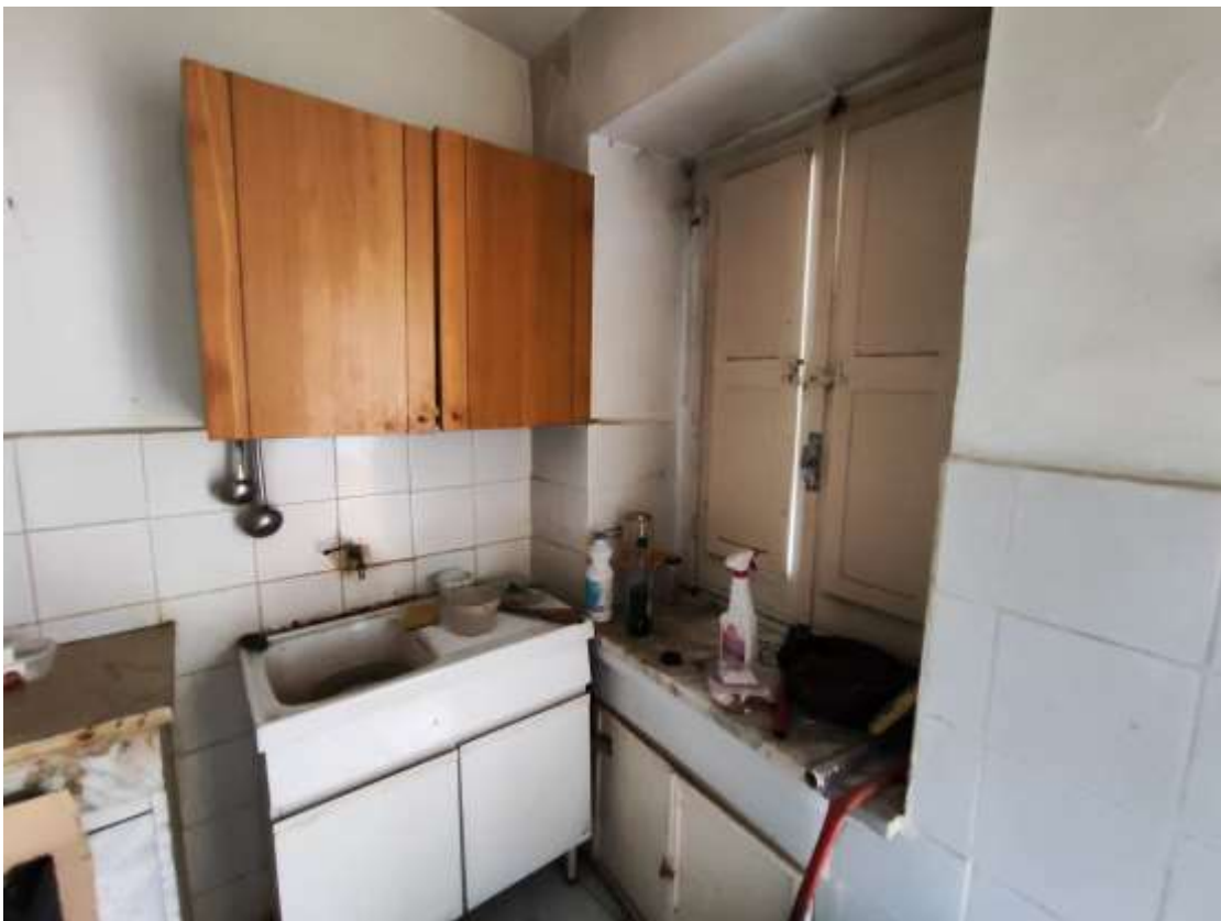
Foto 21 - Fabbricato Foglio 38 P.IIa 647, interni, piano terra
