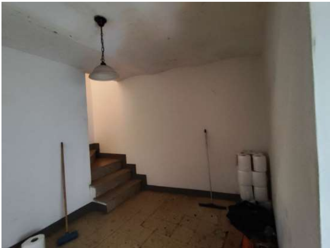
Foto 137 - Fabbricato Foglio 38 P.Ila 647, interni, piano primo
