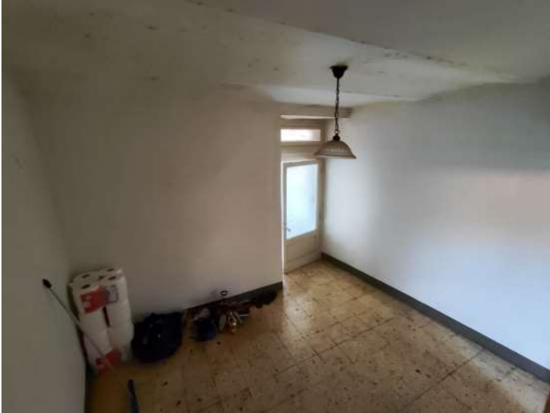
Foto 148 - Fabbricato Foglio 38 P.Ila 647, interni, piano primo
