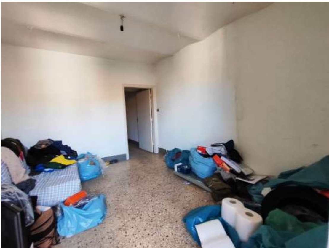
Foto 93 - Fabbricato Foglio 38 P.Ila 647, interni, piano primo
