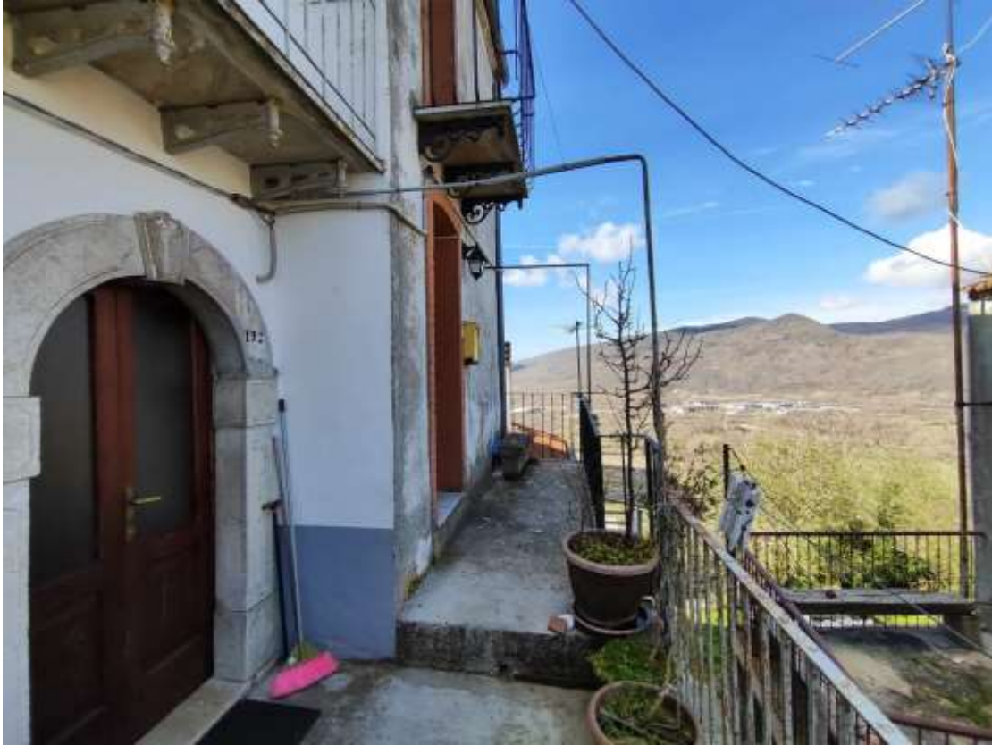
Foto 6 - Fabbricato Foglio 38 P.Ila 647, esterni, piano primo
