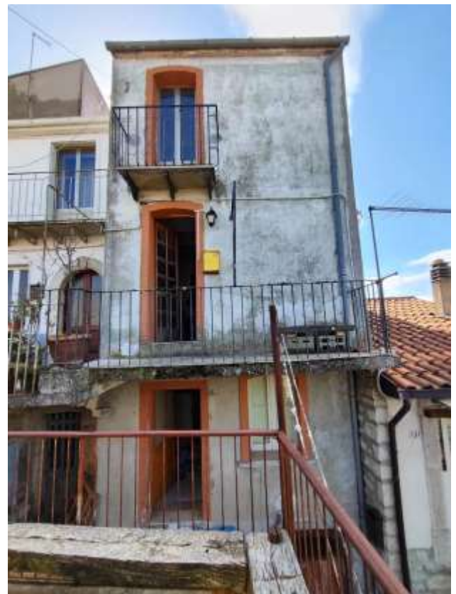
Foto 5 - Fabbricato Foglio 38 P.Ila 647, esterni
