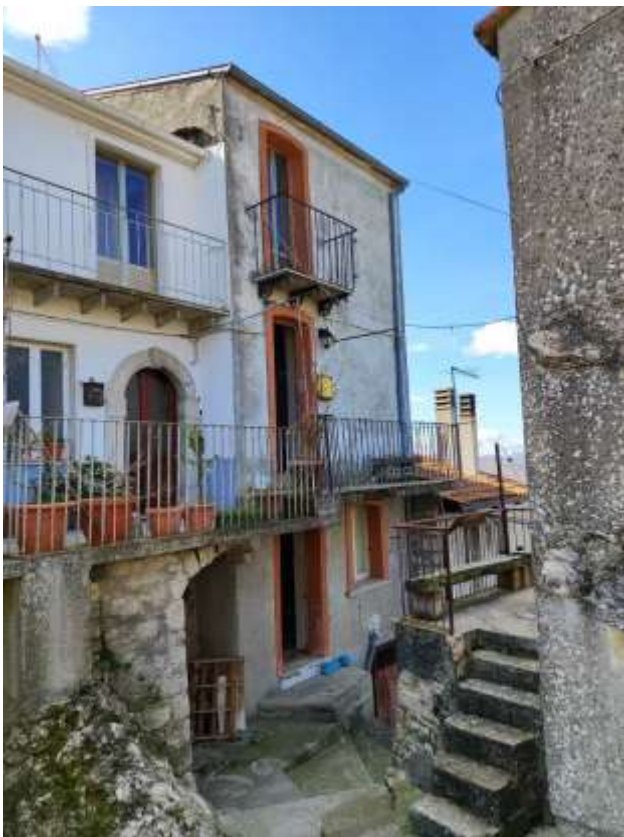
Foto 4 - Fabbricato Foglio 38 P.Ila 647, esterni
