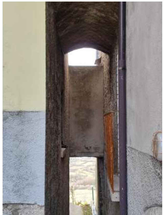
Foto 12 - Veduta wc piano primo da Via della Madonna
