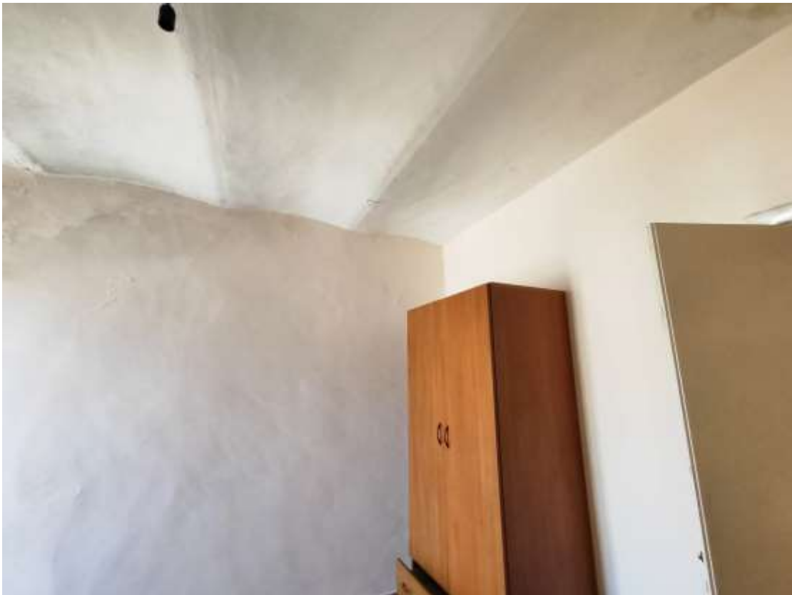
Foto 31 - Fabbricato Foglio 38 P.Ila 647, interni, piano secondo
