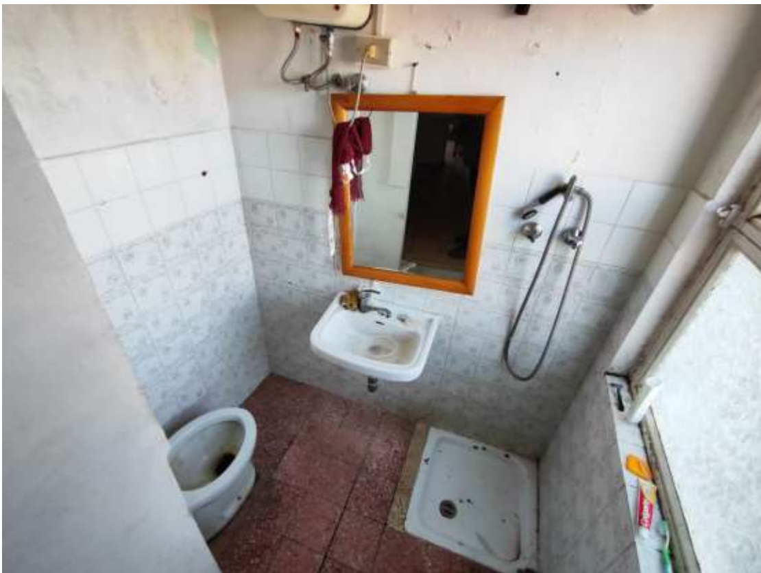
Foto 115 - Fabbricato Foglio 38 P.Ila 647, interni, wc piano primo
