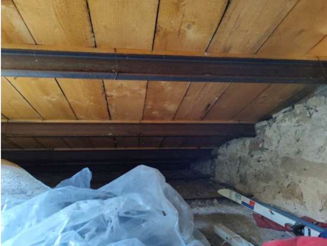
Foto 42 - Fabbricato Foglio 38 P.Ila 647, interni, dettaglio copertura
