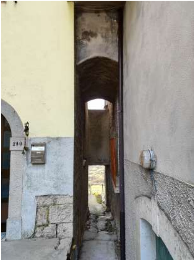
Foto 13 - Veduta wc piano primo da Via della Madonna
