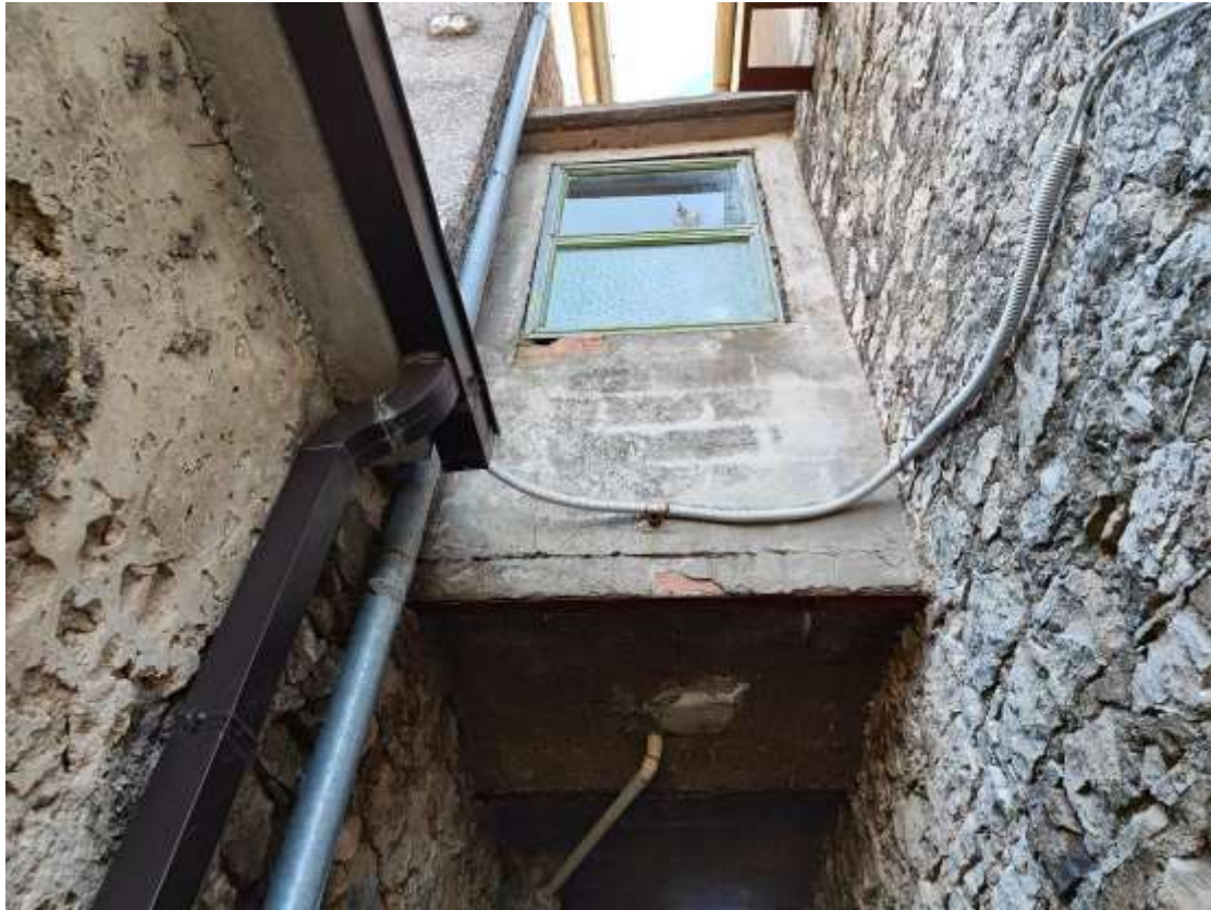
Foto 10 - Fabbricato Foglio 38 P.Ila 647, esterni, veduta posteriore wc piano primo
