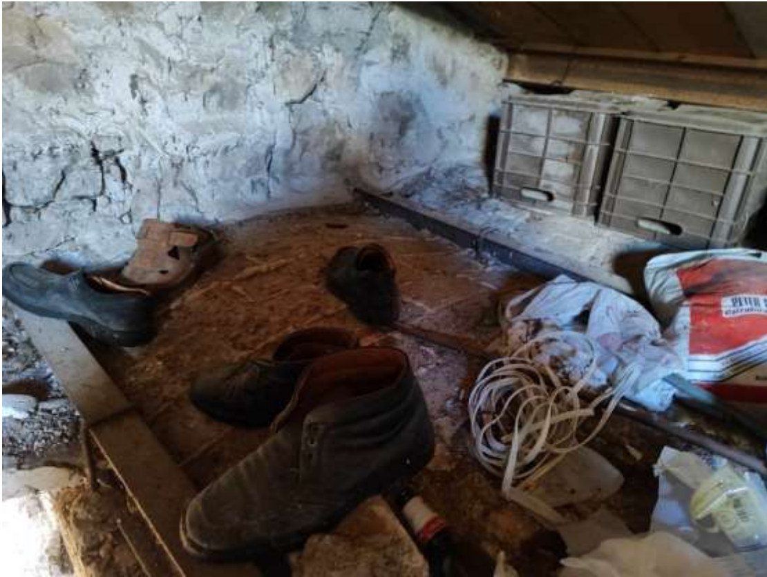
Foto 40 - Fabbricato Foglio 38 P.Ila 647, interni, sottotetto
