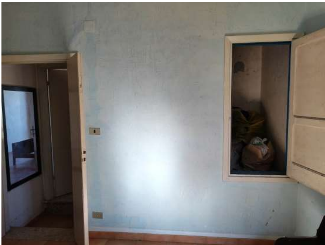
Foto 197 - Fabbricato Foglio 38 P.Ila 647, interni, piano secondo
