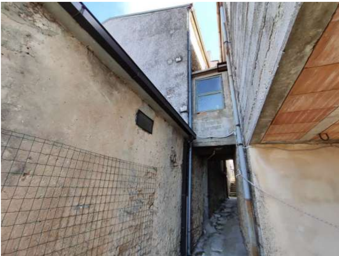
Foto 9 - Fabbricato Foglio 38 P.Ila 647, esterni, veduta posteriore wc piano primo
