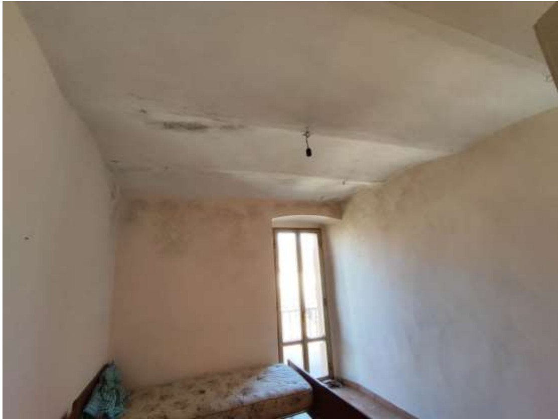
Foto 32 - Fabbricato Foglio 38 P.Ila 647, interni, piano secondo
