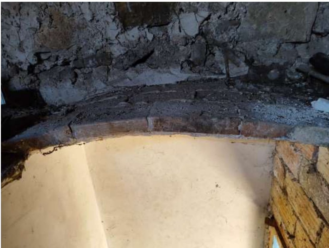
Foto 219 - Fabbricato Foglio 38 P.Ila 647, interni, sottotetto
