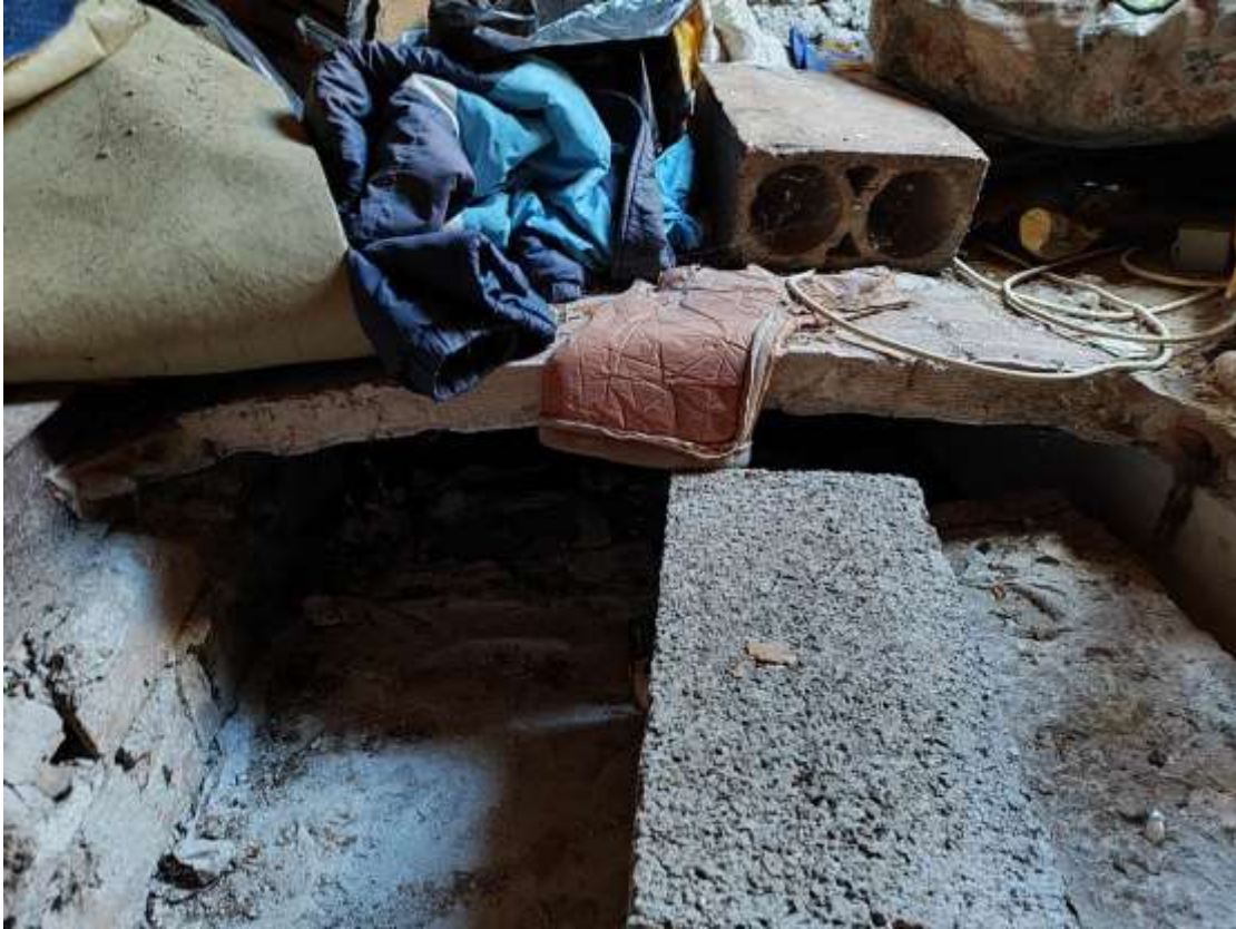
Foto 208 - Fabbricato Foglio 38 P.Ila 647, interni, sottotetto
