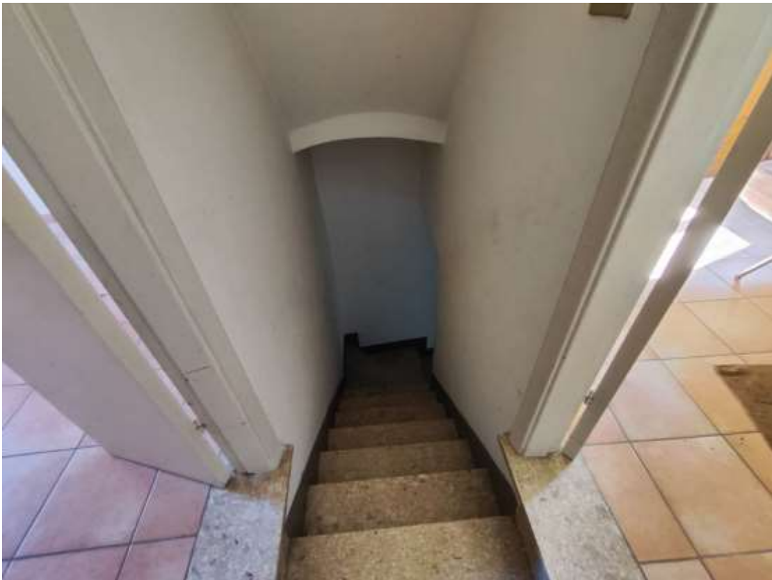
Foto 29 - Fabbricato Foglio 38 P.Ila 647, interni, scala di collegamento piano primo – piano secondo
