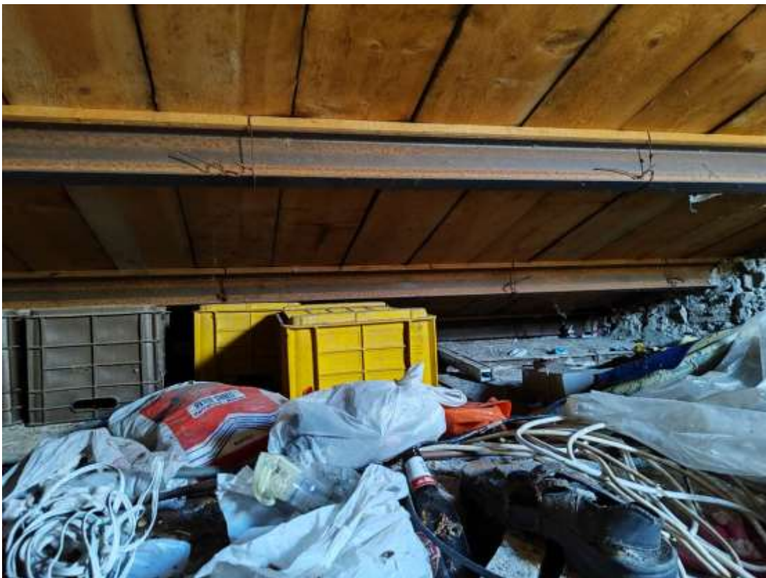
Foto 223 - Fabbricato Foglio 38 P.Ila 647, interni, dettaglio copertura
