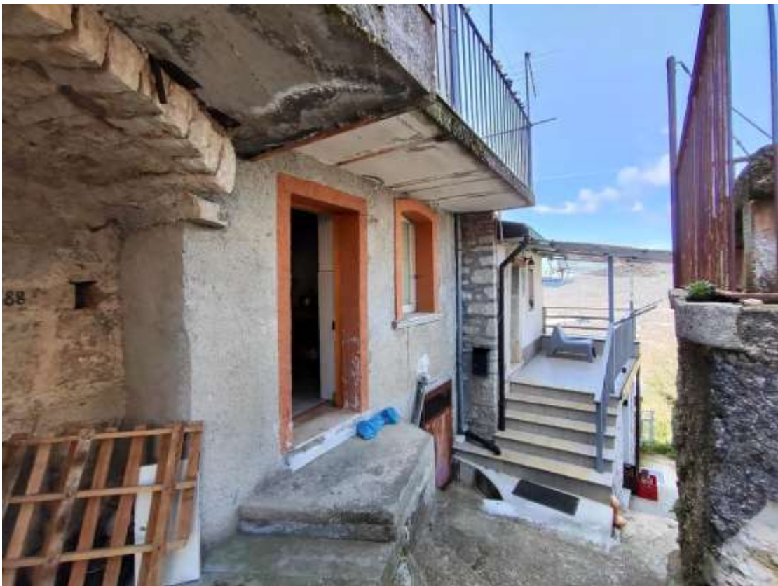
Foto 7 - Fabbricato Foglio 38 P.Ila 647, esterni, piano terra
