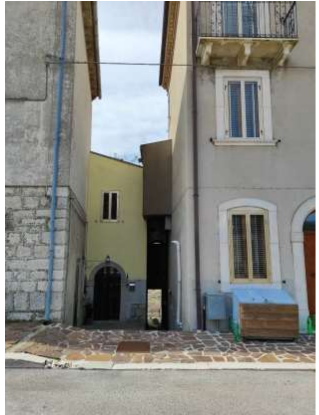
Foto 14 - Veduta wc piano primo da Via della Madonna
