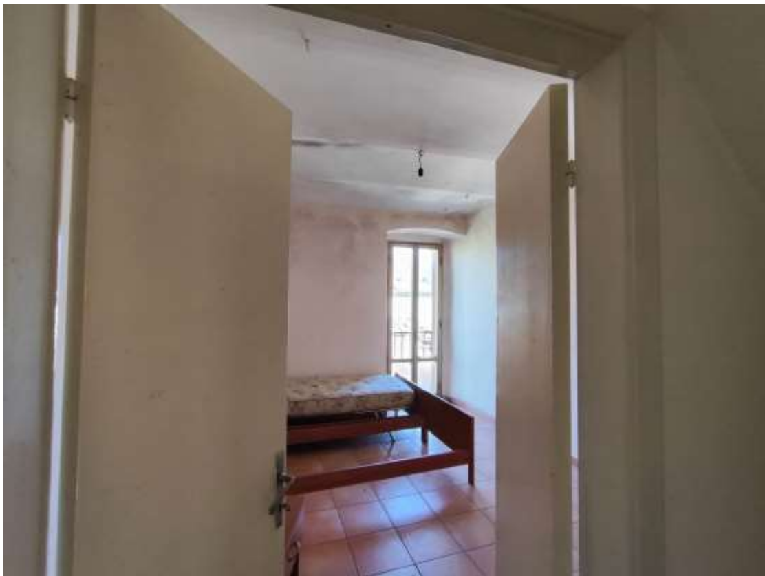
Foto 153 - Fabbricato Foglio 38 P.Ila 647, interni, piano secondo
