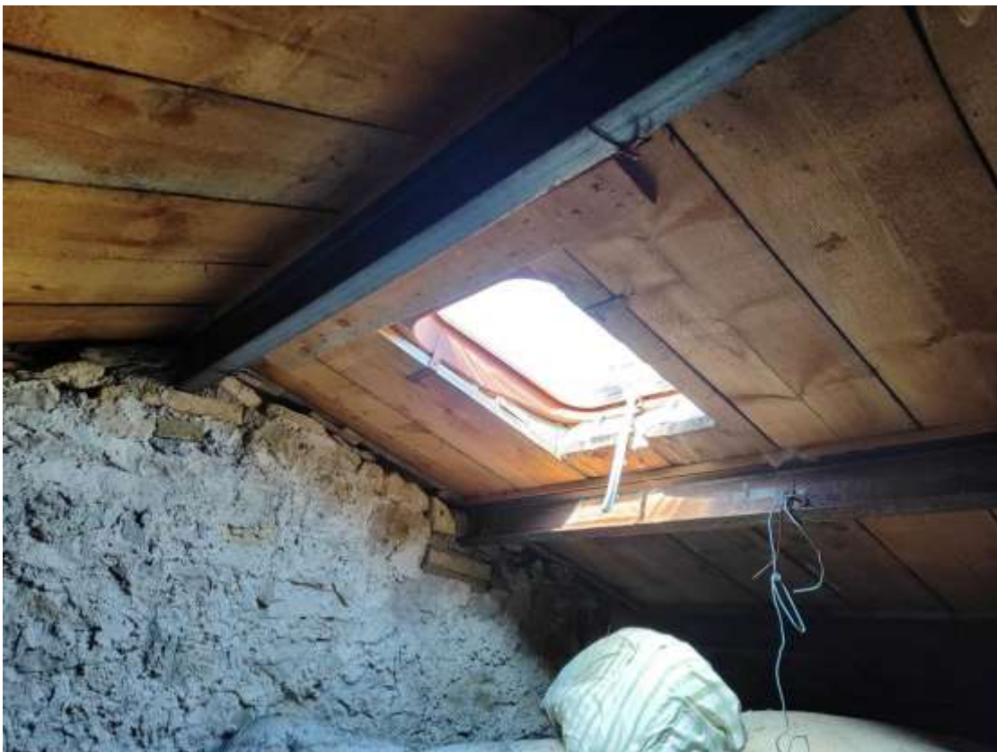
Foto 41 - Fabbricato Foglio 38 P.Ila 647, interni, dettaglio copertura
