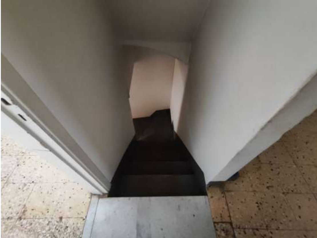
Foto 22 - Fabbricato Foglio 38 P.Ila 647, interni, scala di collegamento piano terra – piano primo
