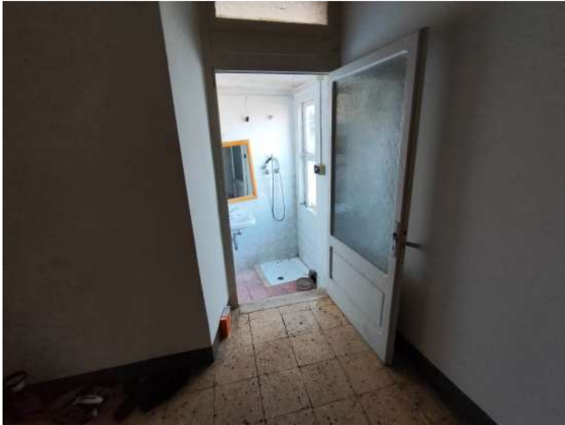
Foto 126 - Fabbricato Foglio 38 P.Ila 647, interni, wc piano primo
