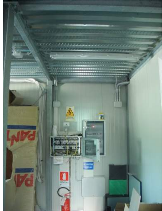
FOTO 41 – struttura prefabbricata uso uffici
