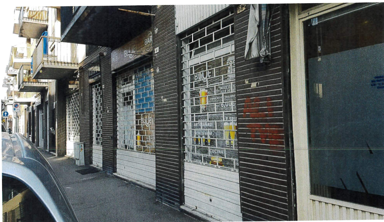
Vista dall'esterno sulla strada
