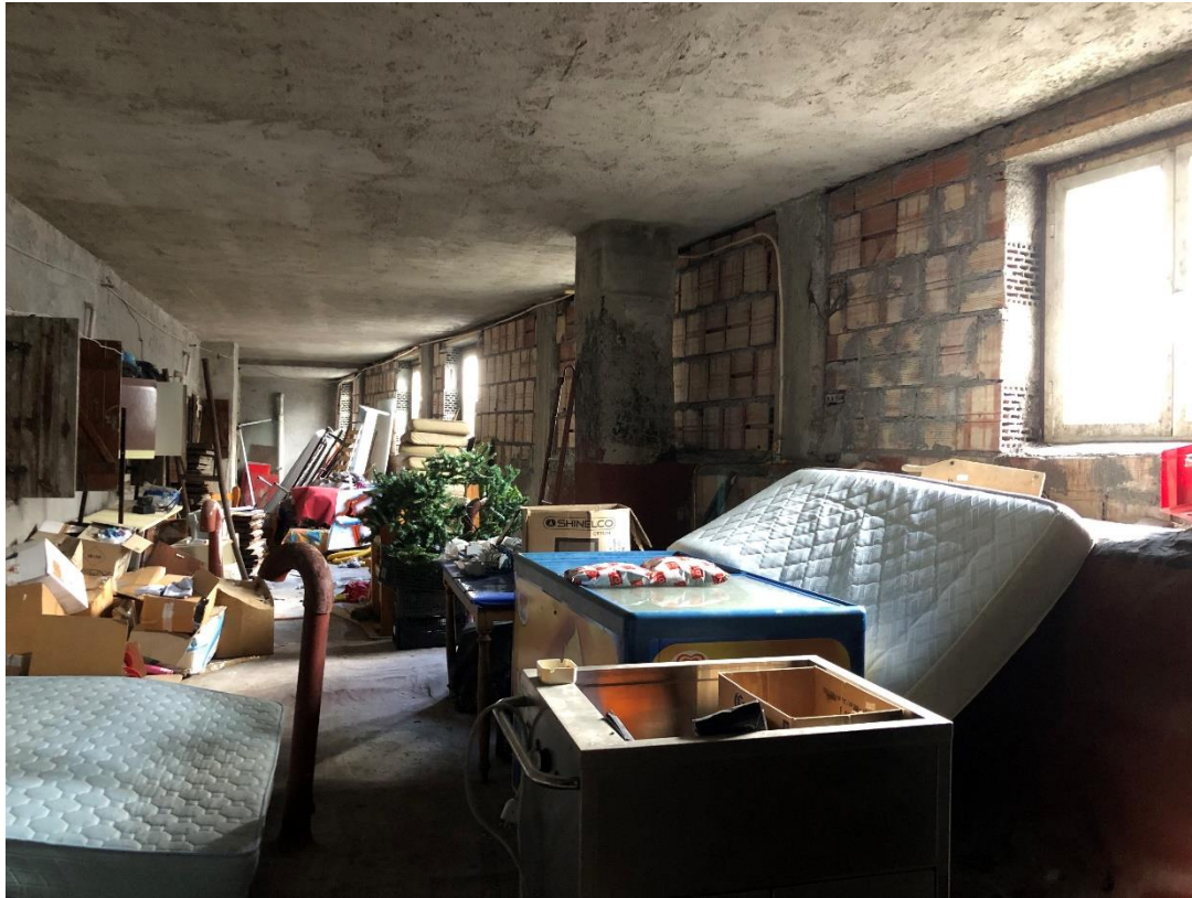
EX PORTICO DA RIPRISTINARE (Piano primo) LOTTO UNICO: Comune di Guarcino - Fg. 8, part. 36, sub. 3
