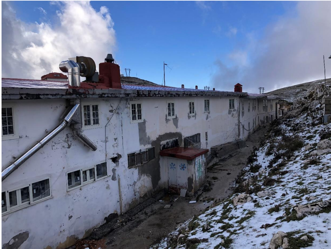
VISTA ESTERNA DEL FABBRICATO – RETRO FABBRICATO LOTTO UNICO: Comune di Guarcino - Fg. 8, part. 36, sub. 3
