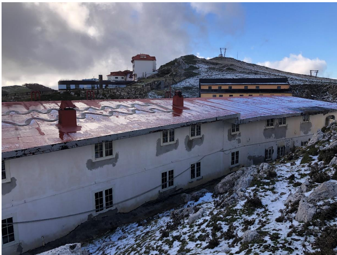
VISTA ESTERNA DEL FABBRICATO – COPERTURA LOTTO UNICO: Comune di Guarcino - Fg. 8, part. 36, sub. 3
