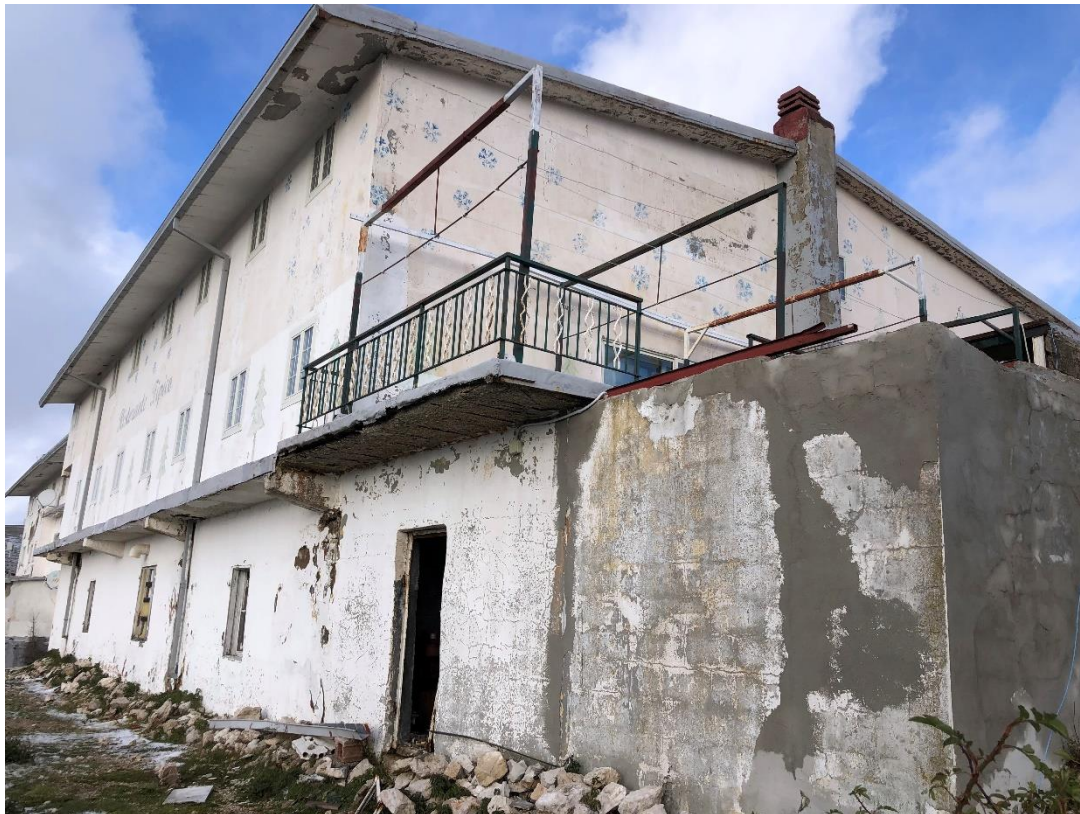
VISTA ESTERNA DEL FABBRICATO – LOCALE TECNICO LOTTO UNICO: Comune di Guarcino - Fg. 8, part. 36, sub. 3
