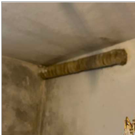
32. La tubazione collegata alla cantina del subalterno 4
