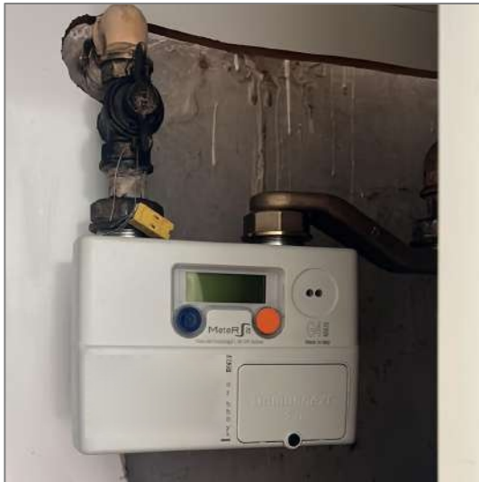
27. Contatore gas metano
