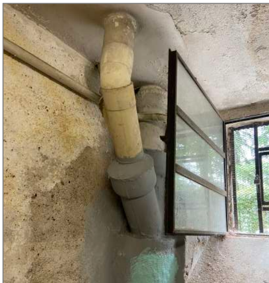
36. Colonna di scarico nella cantina in uso all'Esecutato
