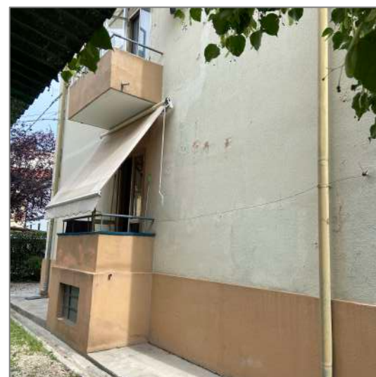
4. Il fronte Sud
