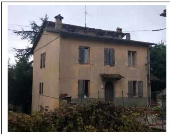
all'1 settembre 1967 ed attualmente in scadenti condizioni manutentive, è in muratura portante con solai in latero-cemento e copertura a capanna costituita da due falde, sfalsate tramite cartella, e realizzate con travi in calcestruzzo tipo "Varese", sovrastanti tavelloni e manto in tegole marsigliesi. L'edificio, inoltre, presenta: tutte le facciate intonacate e tinteggiate, ad eccezione di una piccola
