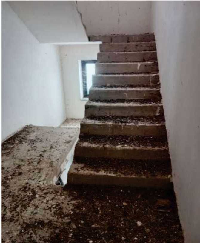
FOTO 31 RAMPA DI ACCESSO AL PIANO SOTTOTETTO
