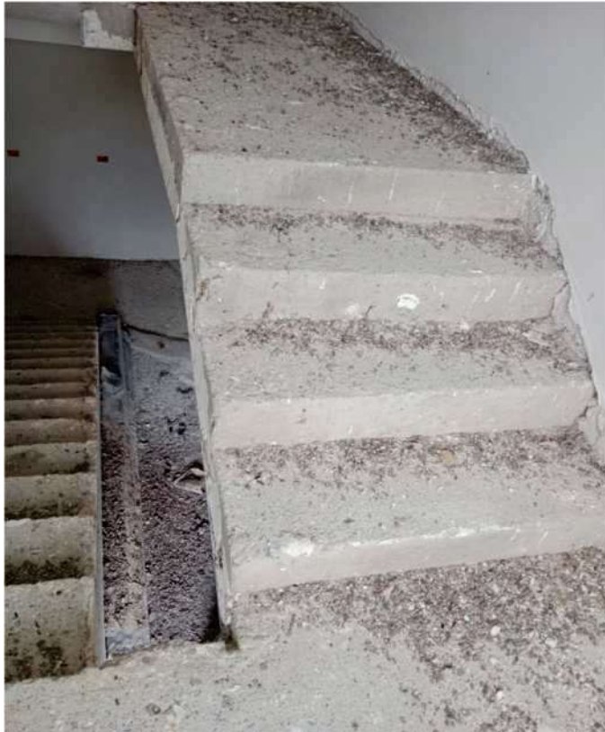
FOTO 17 ACCESSO AL PRIMO PIANO
