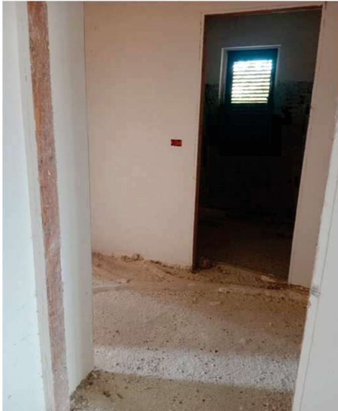
FOTO 13 INGRESSO UNITA' B
