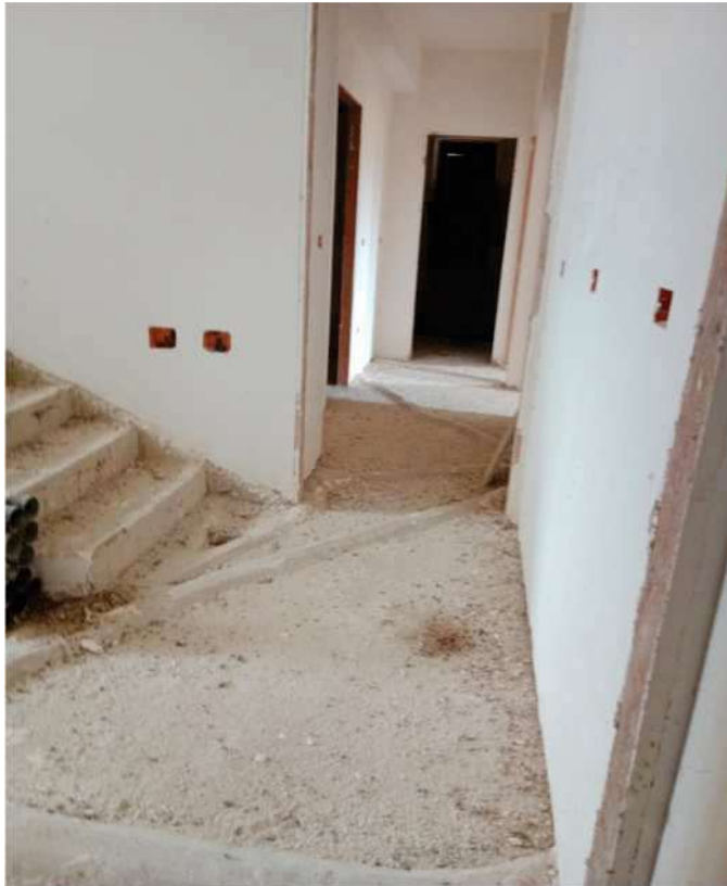
FOTO 7 INGRESSO UNITA' A PIANO TERRA
