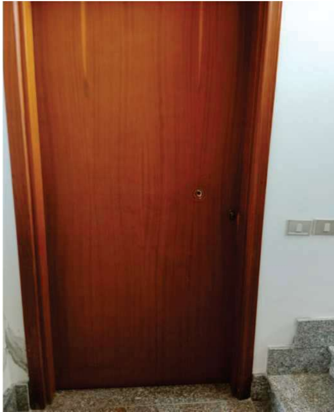
FOTO 9 PORTONE DI INGRESSO SUB 14
