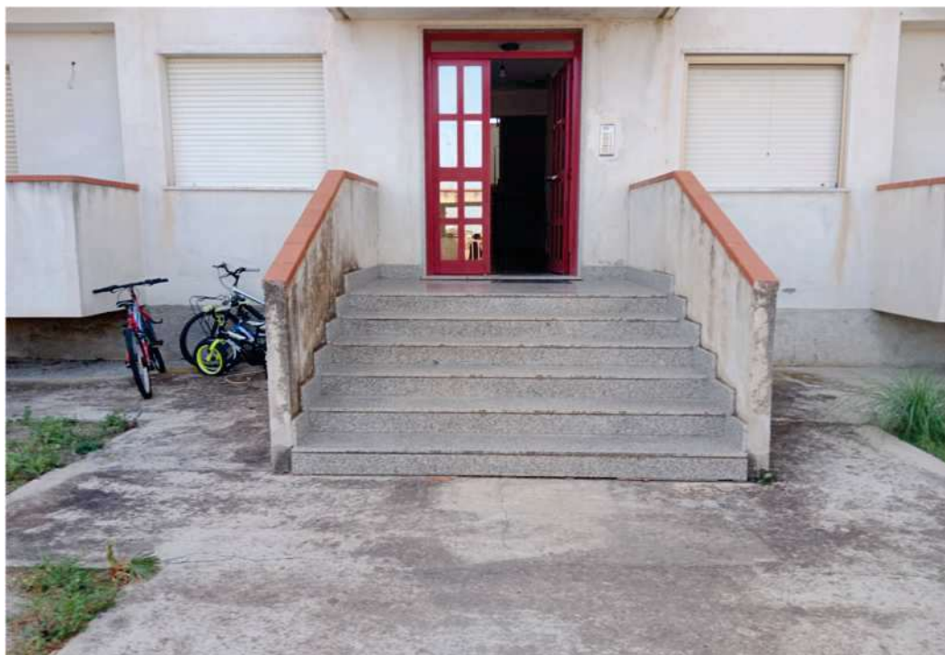
FOTO 4 INGRESSO COMUNE FABBRICATO PLURIFAMILIARE
