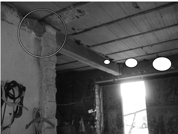
PATOLOGIE EDILIZIA cattiva esecuzione dell'appoggio della trave in c.a.
