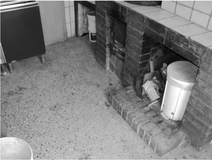
PAVIMENTAZIONE locale cucina
