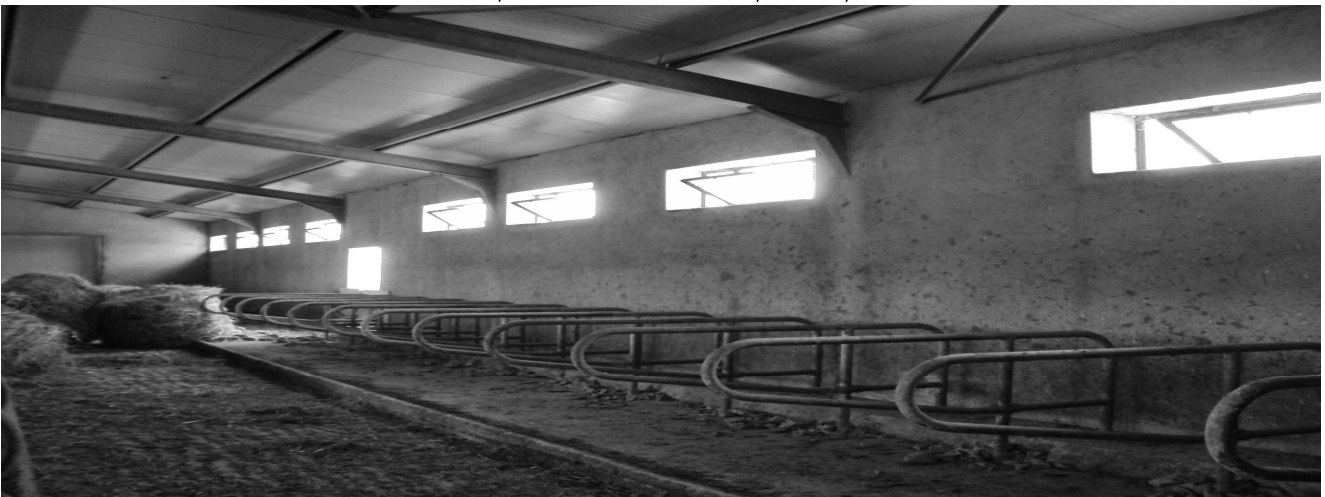
VISTA INTERNA messa in evidenza delle poste e della cunetta per l'asportazione delle deiezioni
