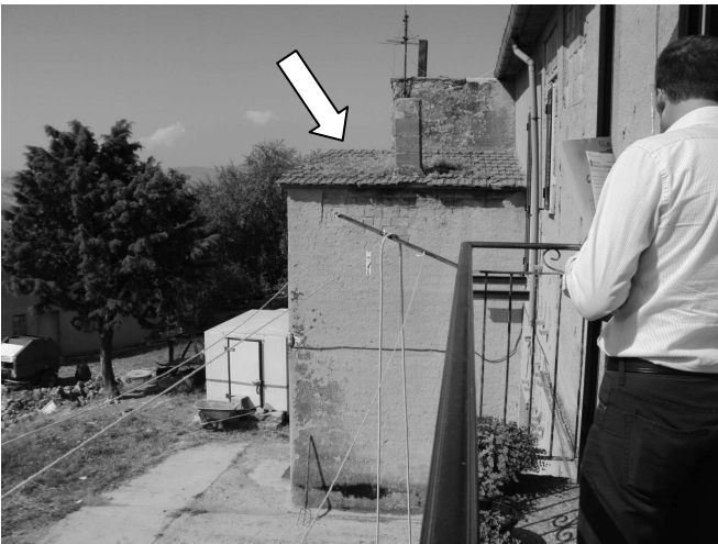
MANTO di COPERTURA tegole marsigliesi
