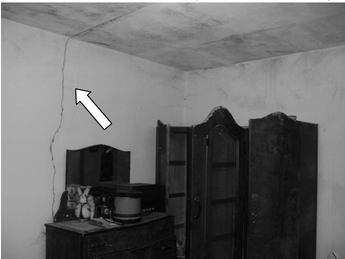
PATOLOGIE EDILIZIA cattiva esecuzione dell'appoggio della trave in c.a.
