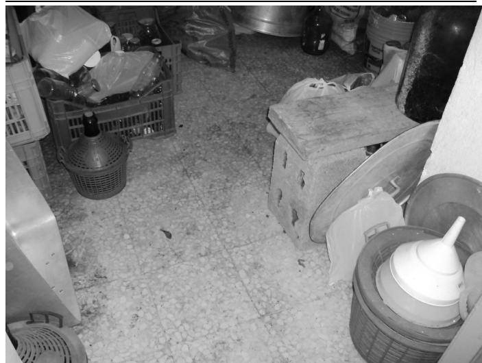
PAVIMENTAZIONE interna con marmettoni di cemento
