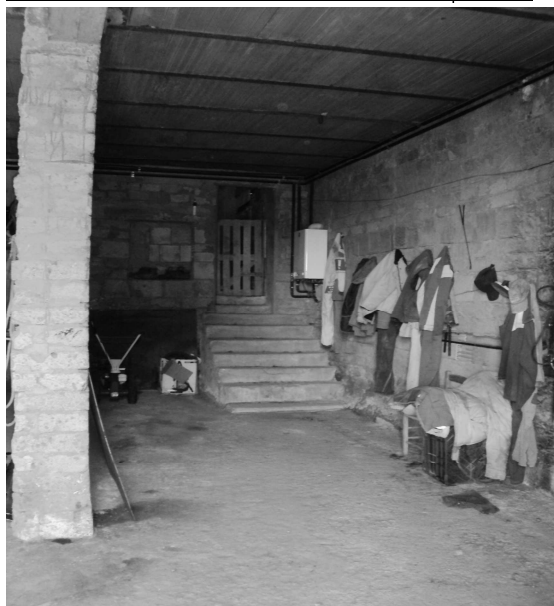
PAVIMENTAZIONE interna locali deposito
