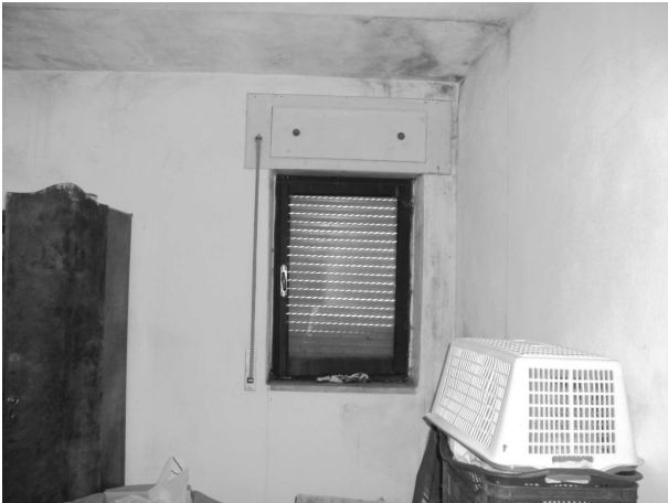
FINESTRA IN LEGNO con TAPPARELLA in PVC
