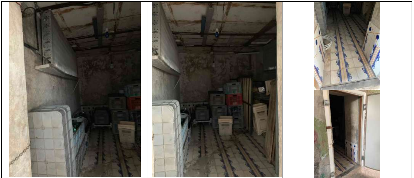
Foto 72, 73, 74, 75: viste Locale Deposito 2 - Sub 3
