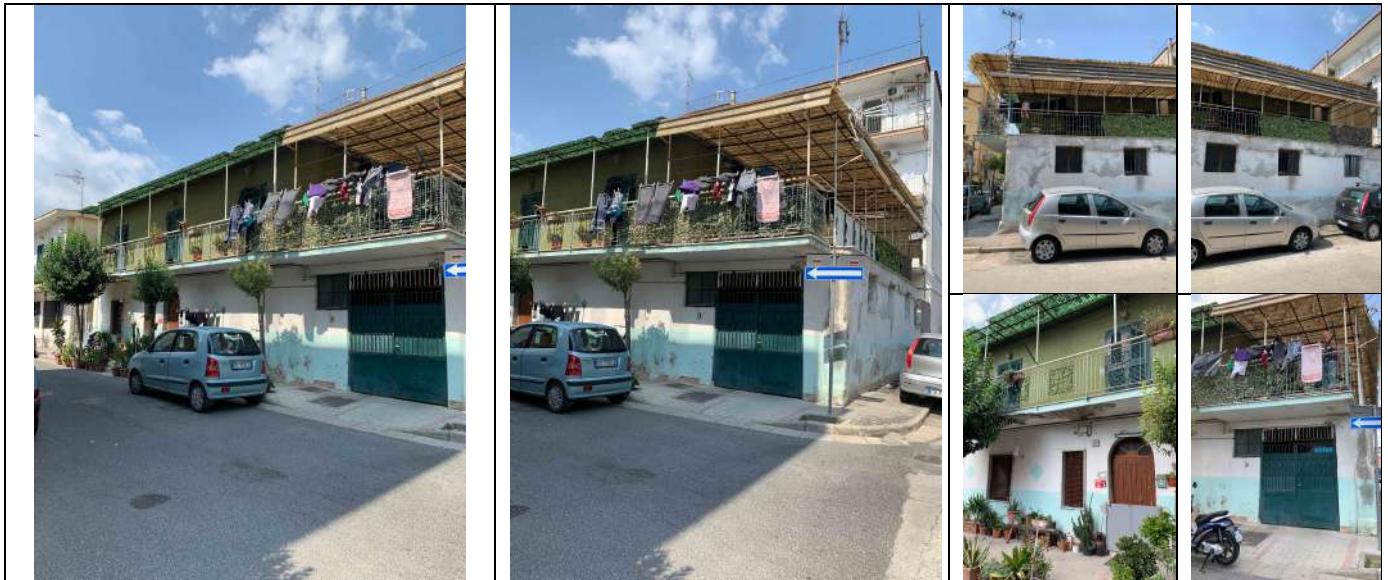
Foto 4, 5, 6, 7, 8, 9: Viste fabbricato da Via Suor Maria della Passione, ingressi civ. 252 e 250
