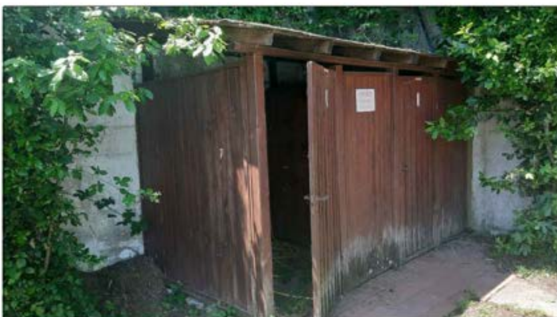
foto 48 - vista degli spogliatoi.
