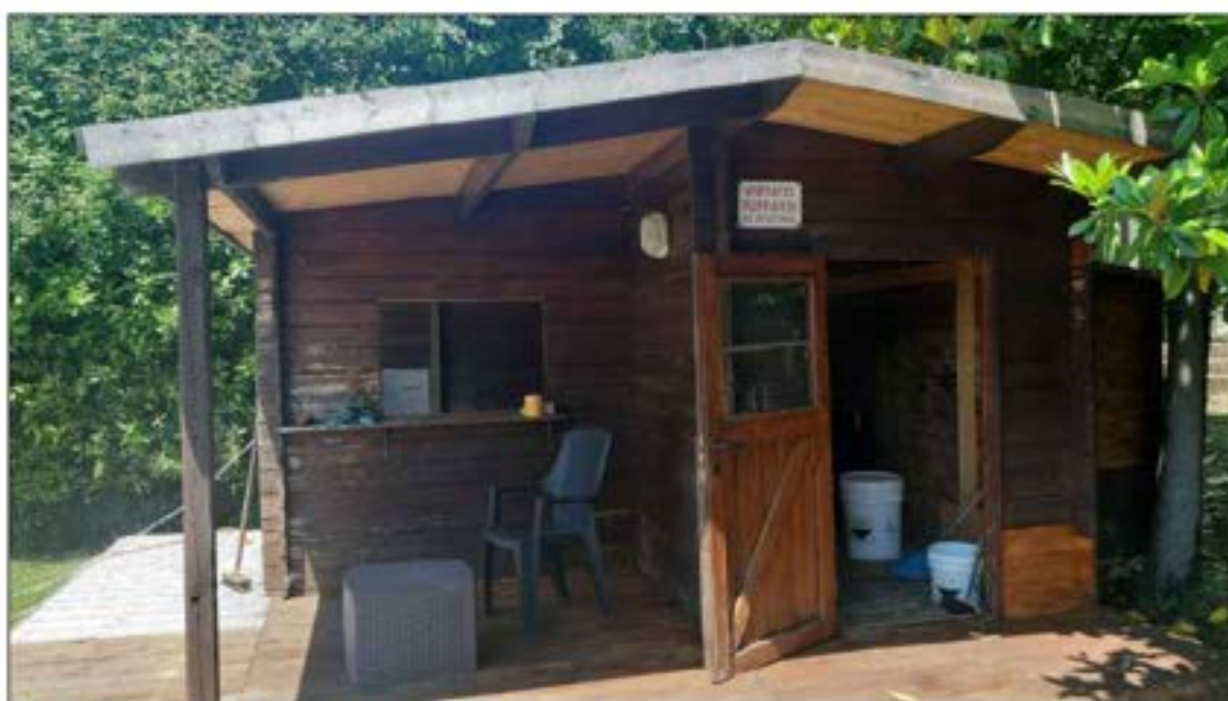
foto 49 - vista del locale del chioschetto in legno di servizio.
