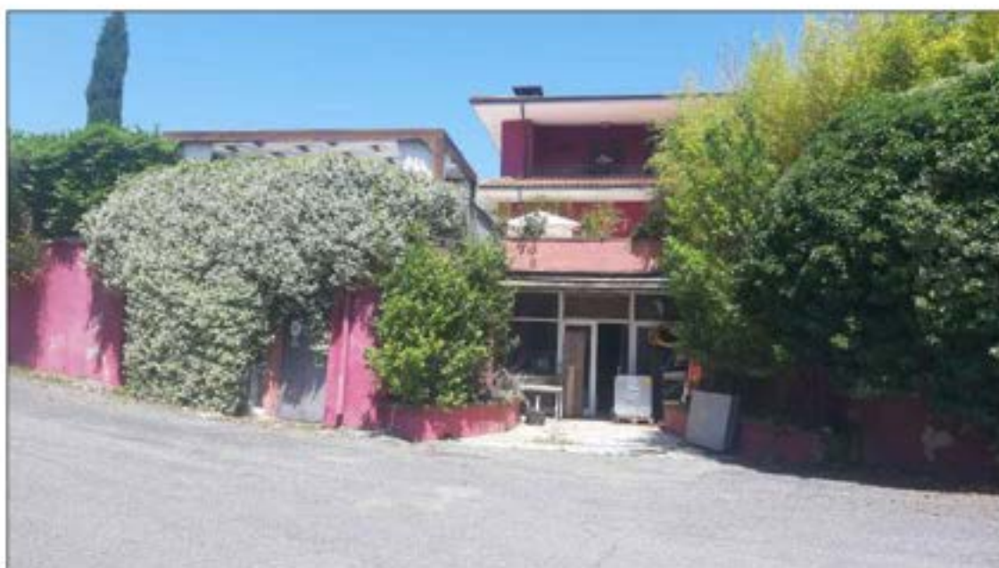
foto 18 - vista esterna con l'accesso al locale posto al piano seminterrato (sub 11).
