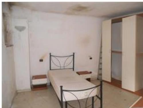
*veduta della "cantina" impropriamente utilizzata come "camera", con finestre che si aprono sul retro del fabbricato, su proprietà di terzi: si notano le evidenti zone ammuffite in corrispondenza della copertura e delle pareti.*
