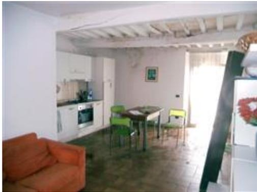
veduta della cucina-tinello al piano primo, con presenza di copiose infiltrazioni di acqua piovana dalla copertura; il trave di sostegno del solaio è crepato nella parte centrale
