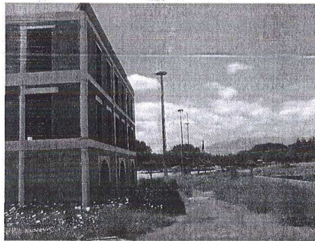
Foto n°7 - Vista prospetto lato proprietà privata
