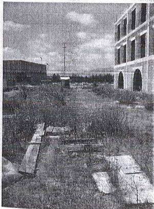
Foto n° 6 - Vista prospetto lato Lotti nn°1-2
